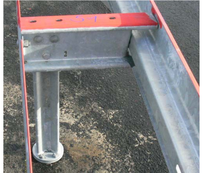
Bild 1: EDSP 2,0 mit geschraubten Steckpfosten mit Zusatzschraube
