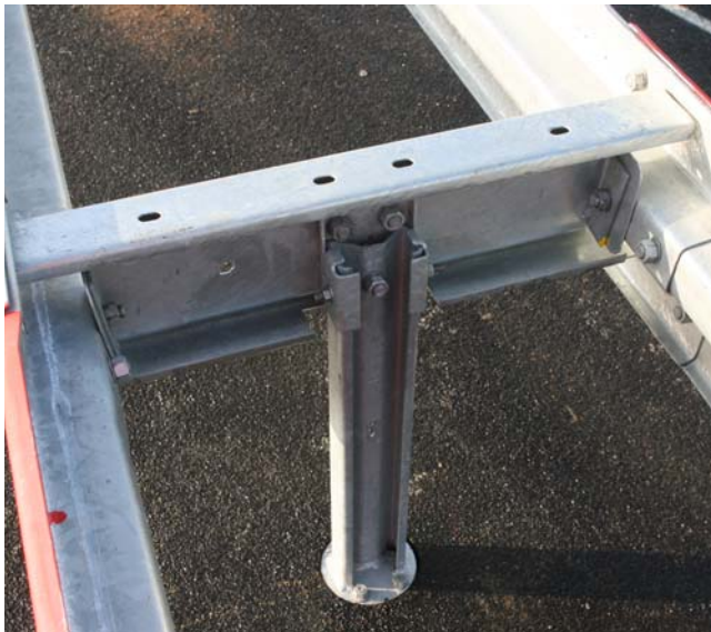
Bild 2: DDSP 4,0+ mit geschraubten Steckpfosten mit Zusatzschraube
