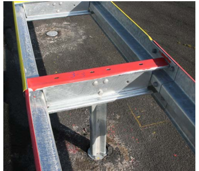
Bild 2: DDSP 4,0+ mit geschraubten Steckpfosten mit Zusatzschraube
