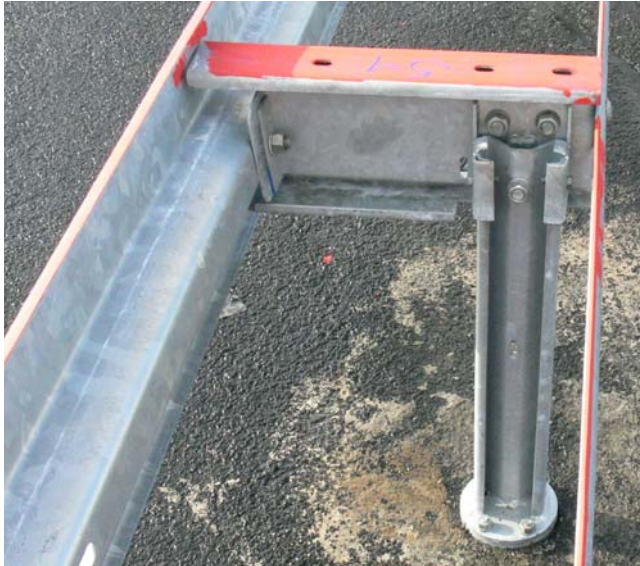
Bild 1: EDSP 2,0 mit geschraubten Steckpfosten mit Zusatzschraube
