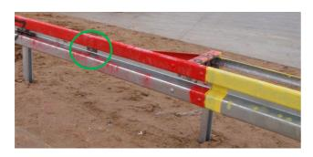
Der hinten am System verlaufende Abspanngurt wird von der Hinterkante des Abstandhalters an den Holm (in einem Abstand von 1 m vom Pfosten) geführt und dort verschraubt mit 1 HRK-Schraube mit Nase M 16x45, Güte 4.6 mit Mutter (40.01) und Unterlegscheibe 18 (40.30) sowie vorderseitig mit einer Decklasche M16.
