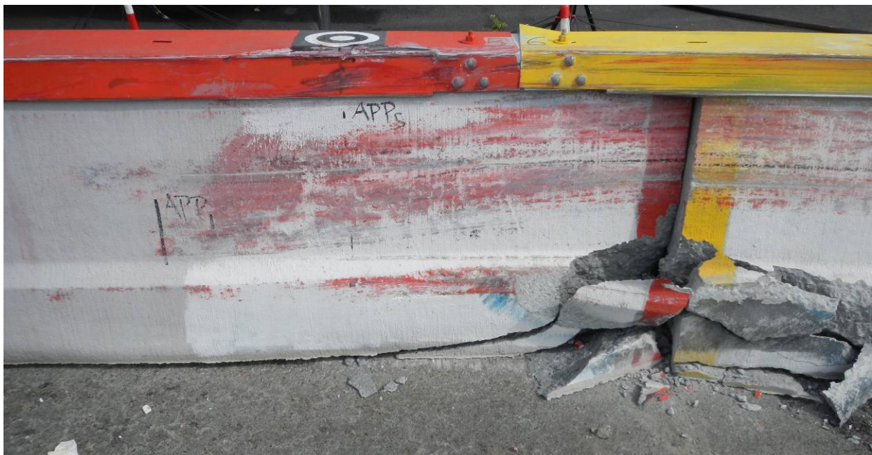
Bild 14 Tatsächlicher Anprallpunkt und Spuren (Ansicht von vorne)
