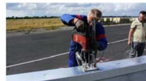
Abb. 6: Bohren der Ankerlöcher
