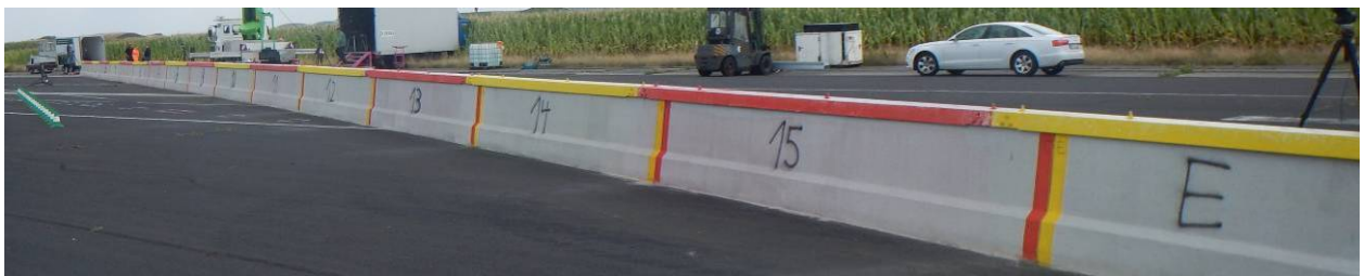
Bild 4 BSW O mit angebrachter Sanierungslösung (Ansicht von vorne gegen Anprallrichtung)
