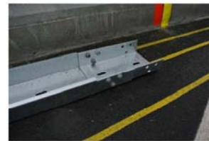
Abb. 1: Vorbereiten der Kastenprofile
