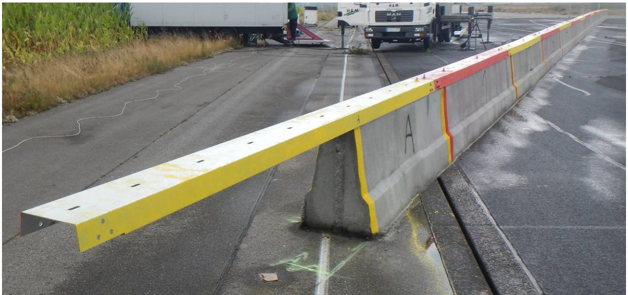
Bild 1 BSW O mit angebrachter Sanierungslösung (Ansicht von vorne in Anprallrichtung)
