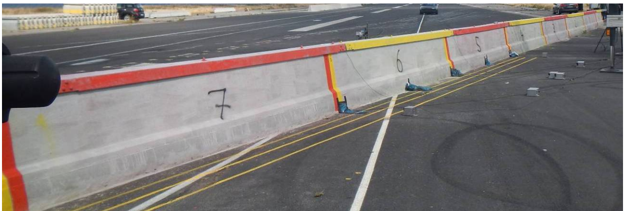
Bild 5 BSW O mit angebrachter Sanierungslösung (Ansicht von hinten gegen Anprallrichtung)
