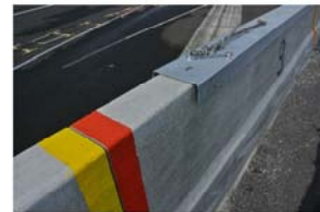
Abb. 2: Auslegen der Kastenprofile
