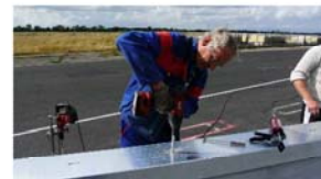
Abb. 10: Einschrauben des Betonankers
