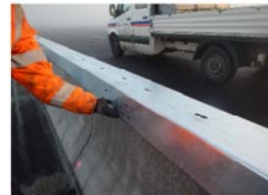
Abb. 4: Ausrichten der Kastenprofile
