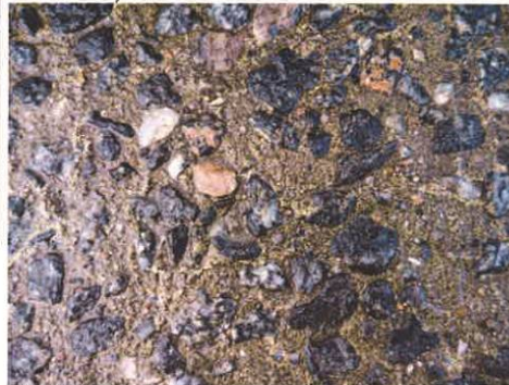
Abbildung 6: Detail (Exemplarisch für eine Messstelle)
