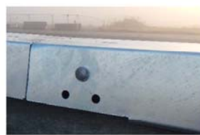
Abb. 3: Verbinden der Kastenprofile
