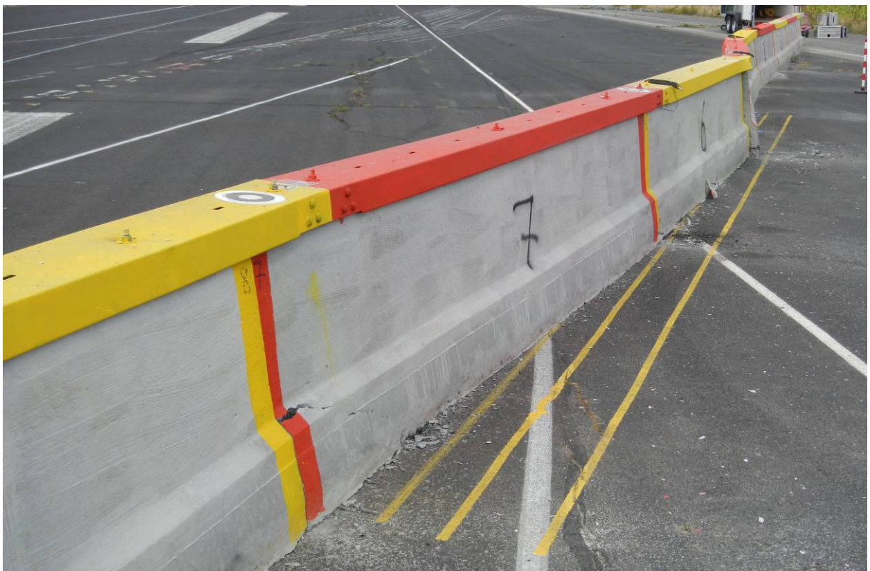
Bild 13 Anprallbereich nach dem Anprallversuch (Ansicht von hinten gegen Anprallrichtung)
