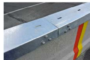
Abb. 2: Auslegen der Kastenprofile
