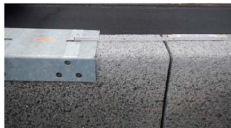
Abb. 5: Ausrichten des Kastenprofils
