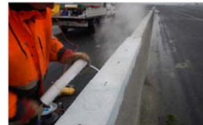
Abb. 7: Ausblasen der Bohrlöcher
