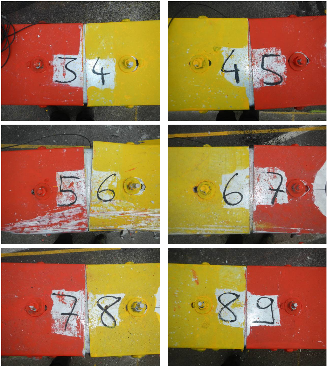
Bild 18 Stöße der Sanierungslösung von oben gesehen
