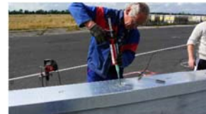
Abb. 9: Einpressen des Spezialmörtels
