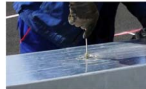
Abb. 8: Ausbürsten der Bohrlöcher
