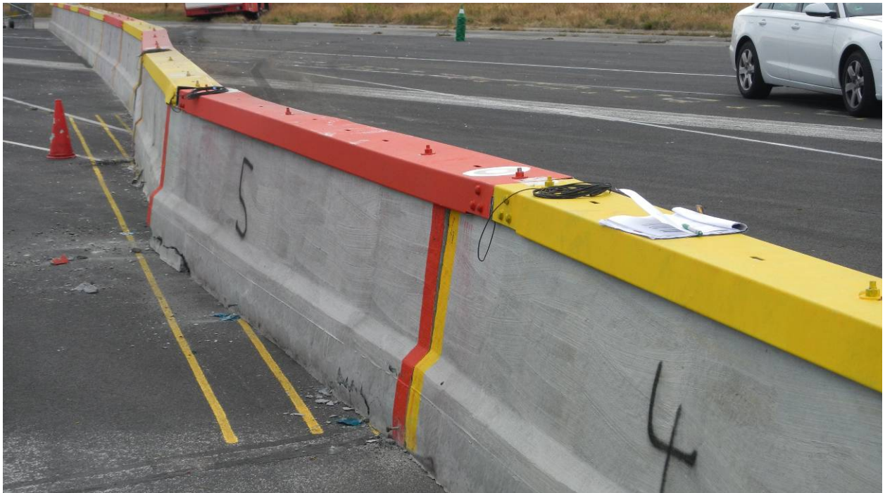
Bild 12 Anprallbereich nach dem Anprallversuch (Ansicht von hinten in Anprallrichtung)
