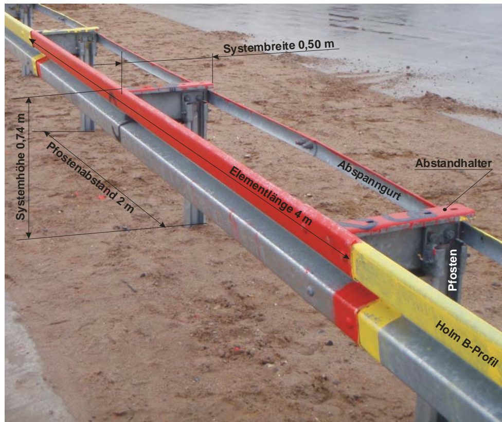
Abbildung 3: Einfache Distanzschutzplanke EDSP 2,0 m B-Profil
