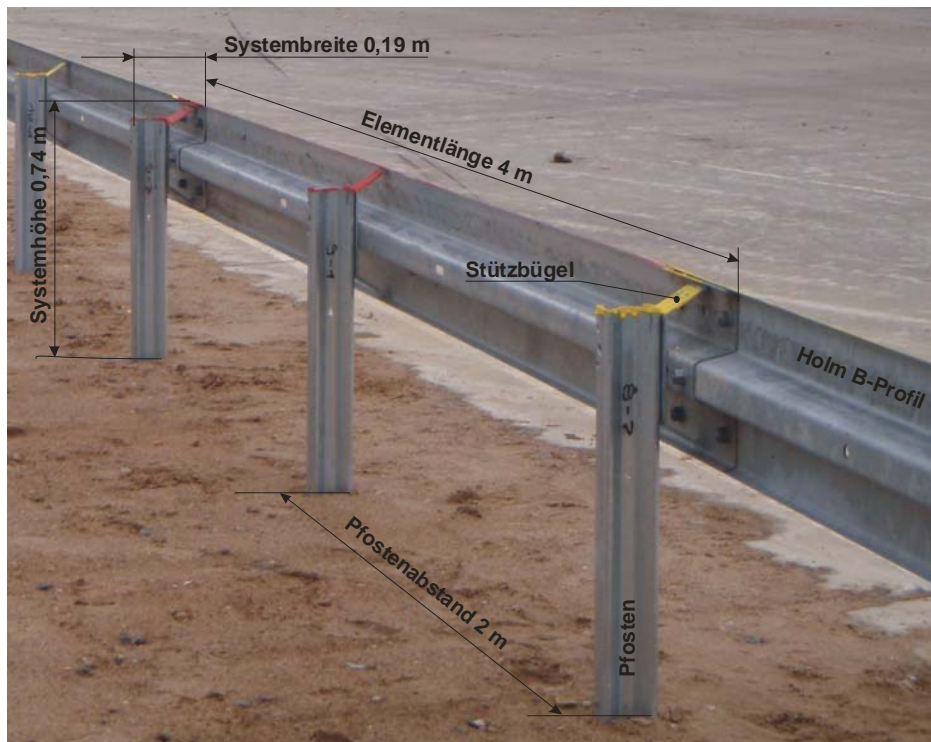
Abbildung 1: Einfache Stahlschutzplanke ESP 4,0 m B-Profil
