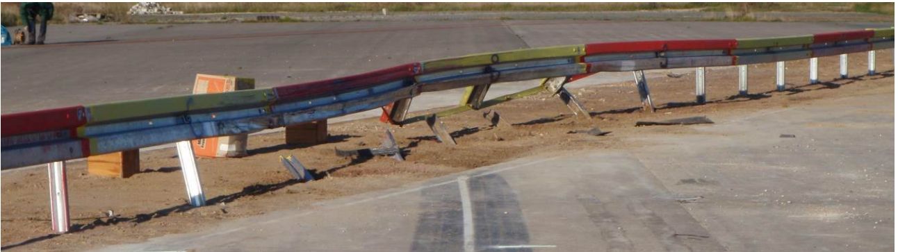
Bild 3: Übergangskonstruktion nach dem Versuch (Ansicht in Anprallrichtung)
