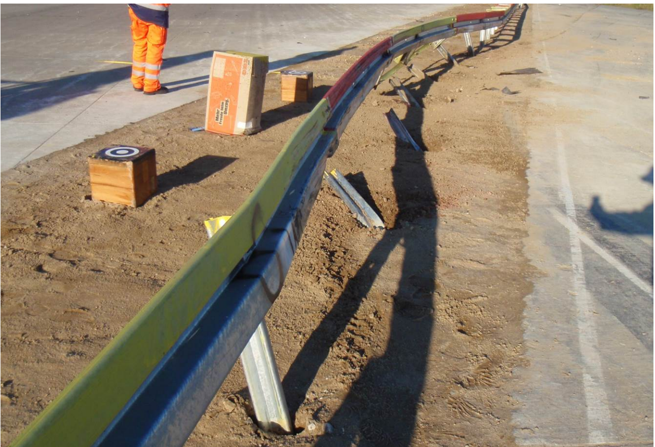
Bild 4: Übergangskonstruktion nach dem Versuch (Ansicht in Anprallrichtung)
