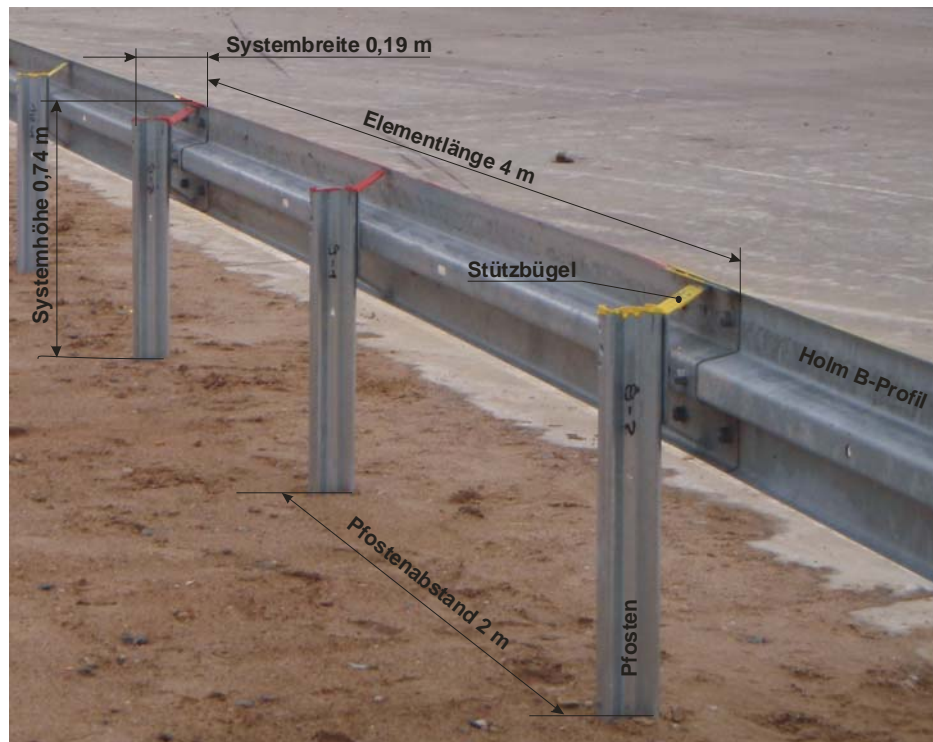
Abbildung 1: Einfache Stahlschutzplanke ESP 4,0 m B-Profil
