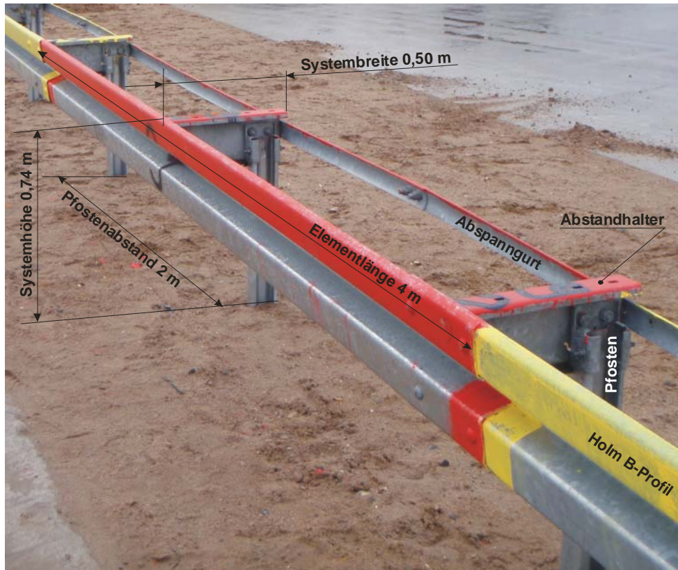
Abbildung 3: Einfache Distanzschutzplanke EDSP 2,0 m B-Profil
