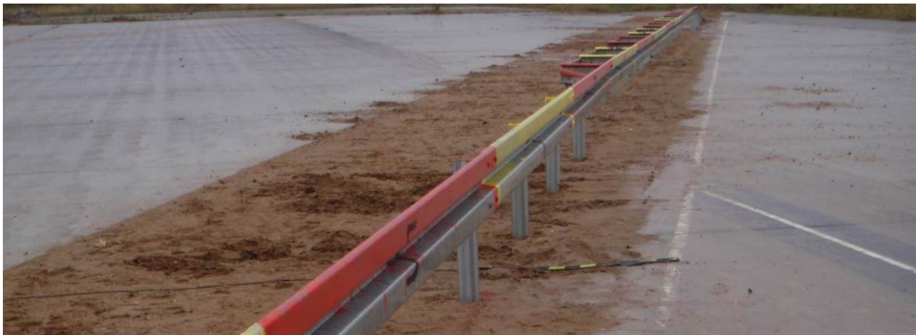
Bild 1: Übergangskonstruktion (Ansicht in Anprallrichtung)
