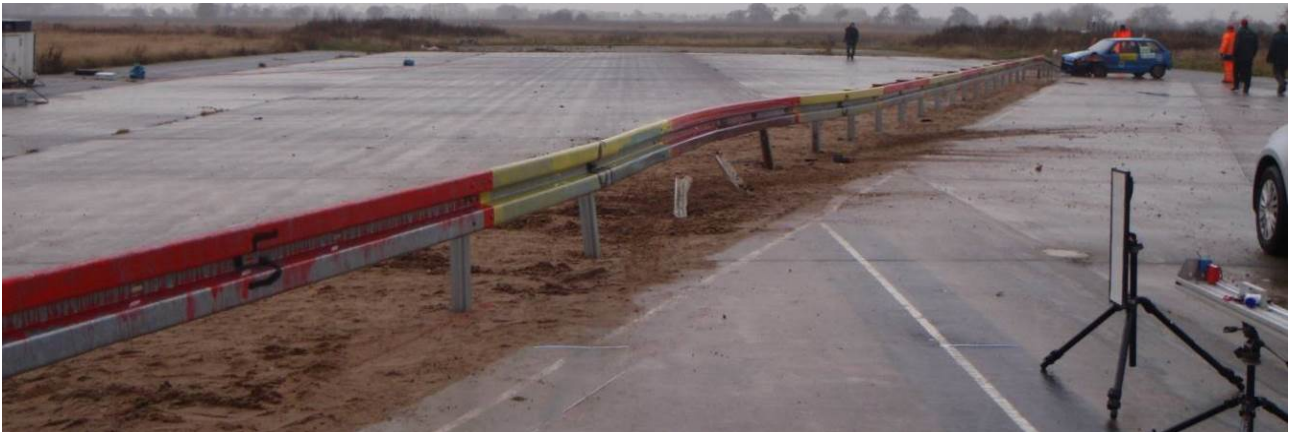
Bild 3: Übergangskonstruktion nach dem Versuch (Ansicht in Anprallrichtung)
