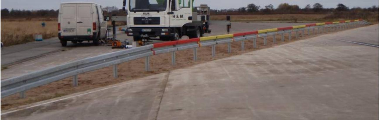
Bild 1: Schutzeinrichtung mit Anfangs- und Endabsenkung (Ansicht in Anprallrichtung)
