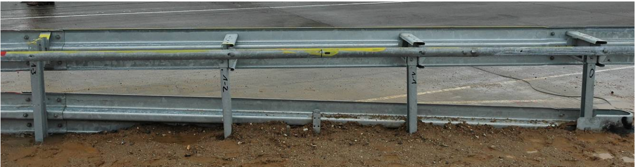
Bild 4: Beginn Übergang EDSP auf Betonschutzwand (Element 1 Systemrückseite)
