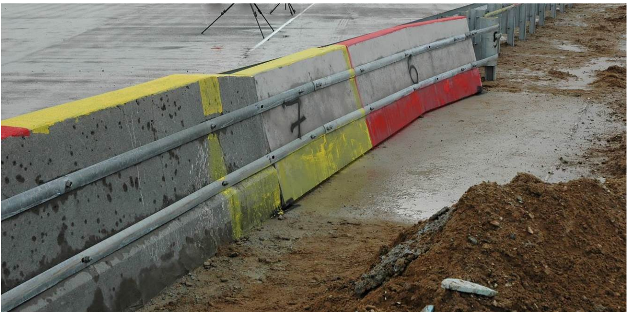
Bild 3: Übergangskonstruktion (Ansicht entgegen der Anprallrichtung - Systemrückseite)
