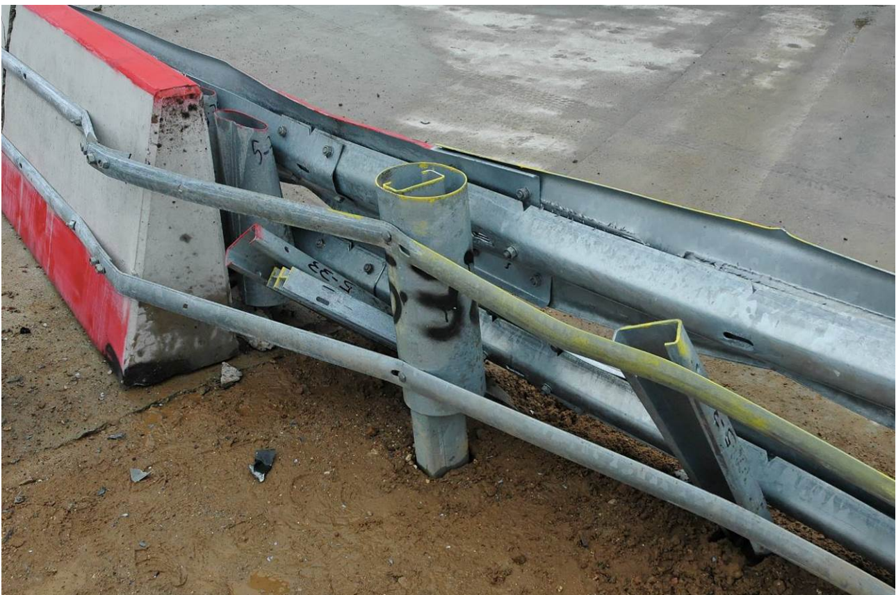
Bild 15: Übergangskonstruktion nach dem Versuch (Ansicht von hinten in Anprallrichtung)
