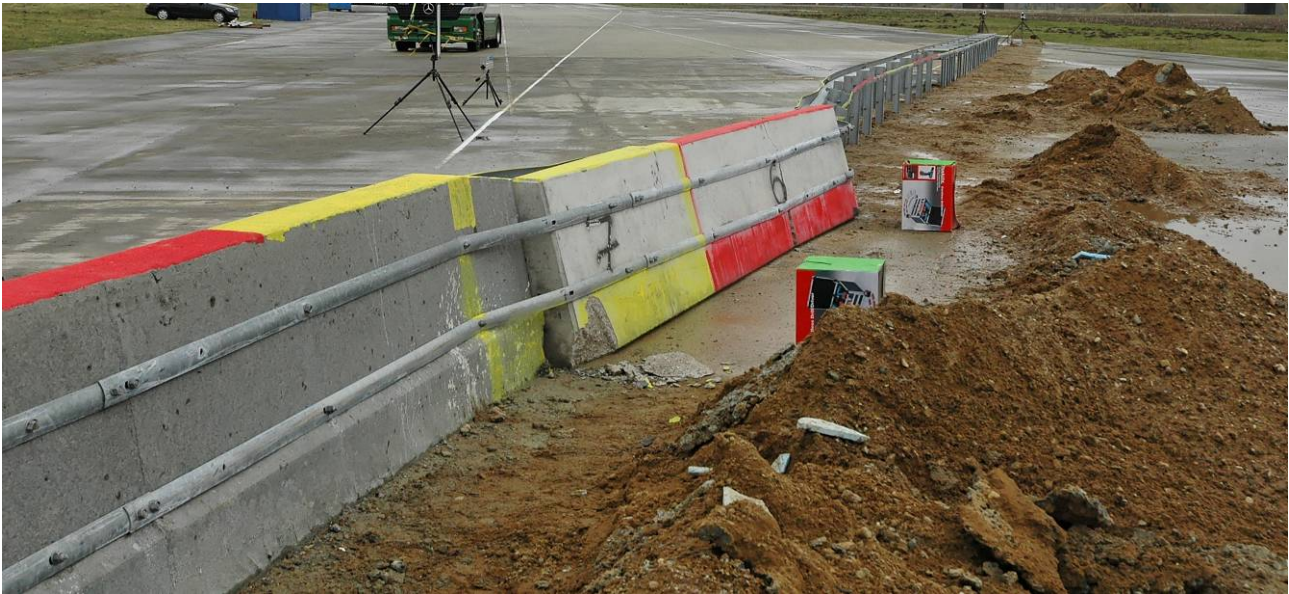
Bild 14: Übergangskonstruktion nach dem Versuch (Ansicht von hinten gegen Anprallrichtung)
