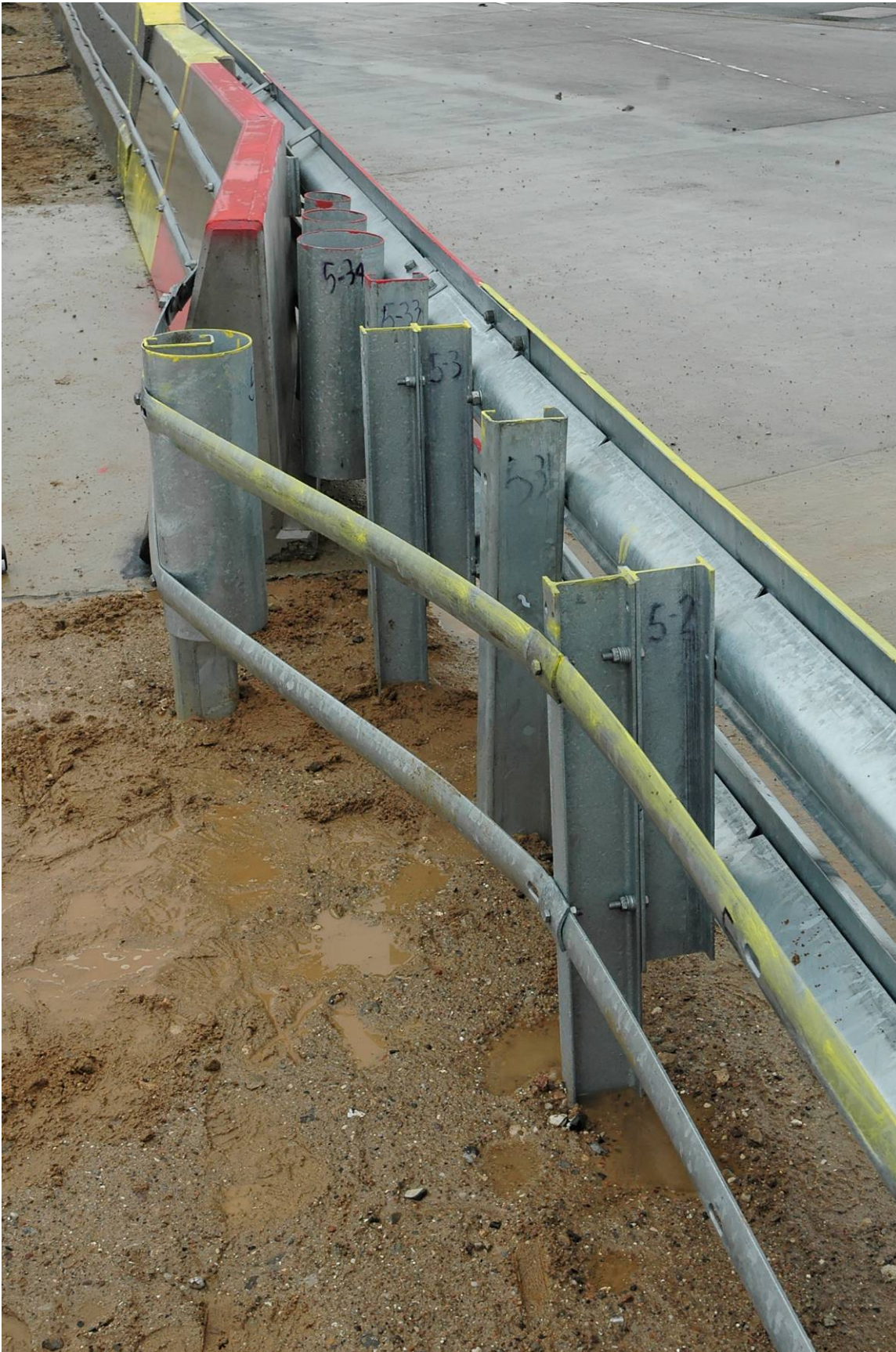
Bild 7: Übergang EDSP auf Betonschutzwand (Ansicht Betonfertigteil in Anprallrichtung)
