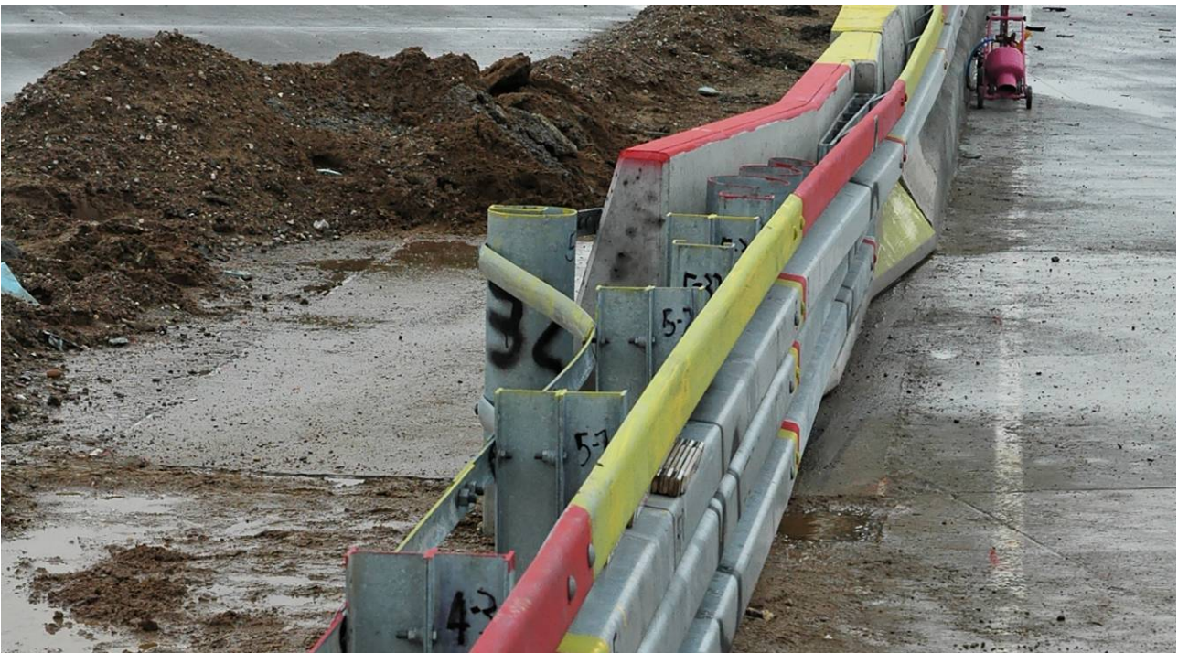
Bild 6: Übergang EDSP auf Betonschutzwand (Ansicht in Anprallrichtung)
