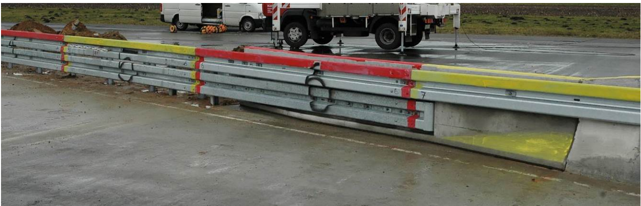
Bild 2: Übergangskonstruktion (Ansicht entgegen der Anprallrichtung - Systemvorderseite)
