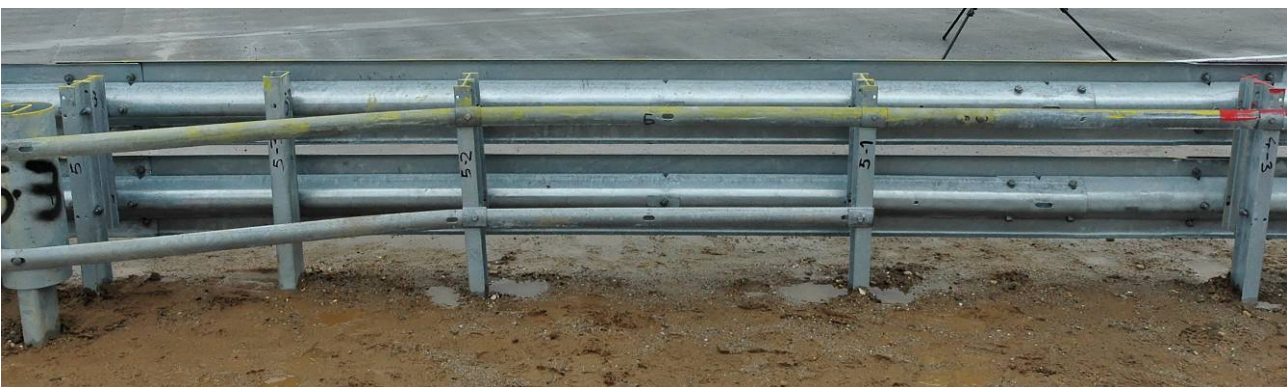
Bild 5: Übergang EDSP auf Betonschutzwand (Element 5 Systemrückseite)
