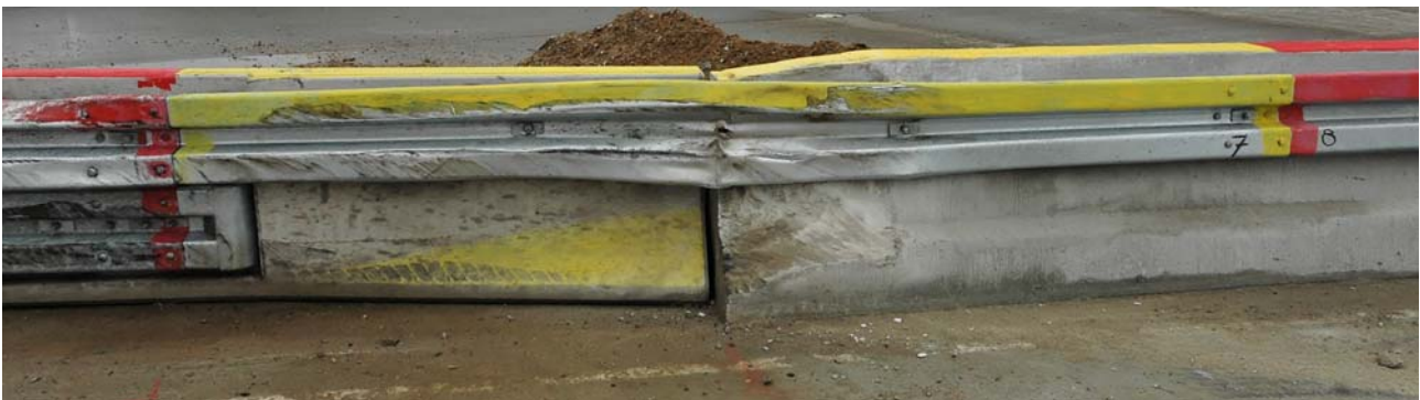
Bild 18: Übergang Betonfertigteilelement auf Ortbetonwand
