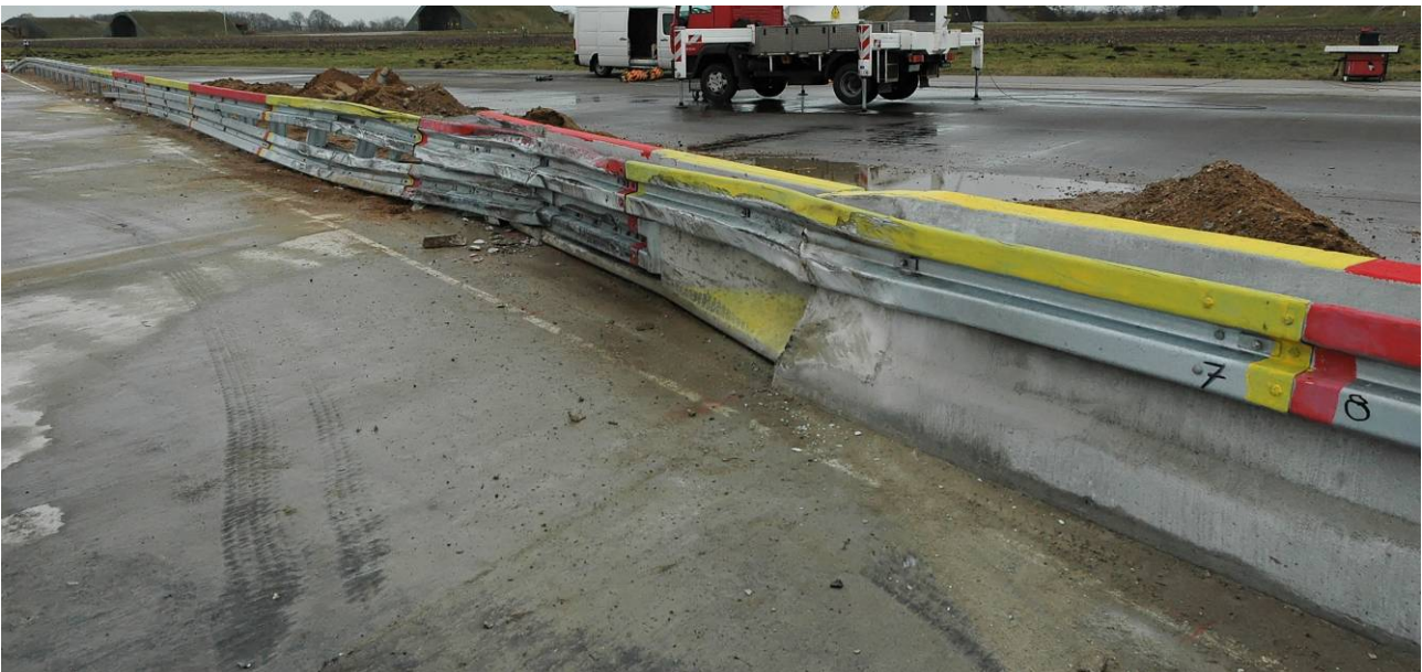
Bild 13: Übergangskonstruktion nach dem Versuch (Ansicht der Systemvorderseite von vorne entgegen der Anprallrichtung)
