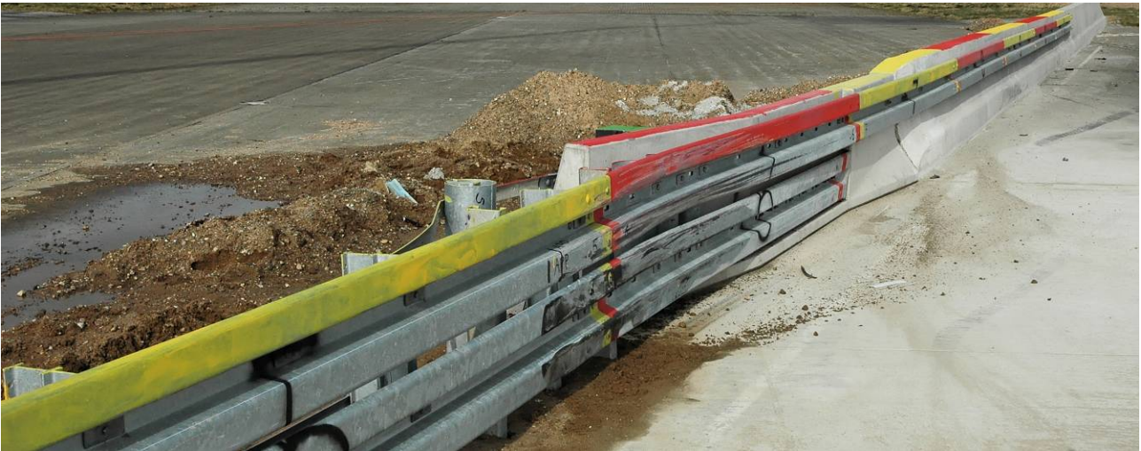
Bild 12: Übergangskonstruktion nach dem Versuch (Ansicht in Anprallrichtung)
