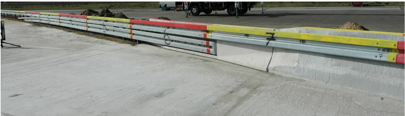
Bild 2: Übergangskonstruktion (Ansicht entgegen der Anprallrichtung - Systemvorderseite)
