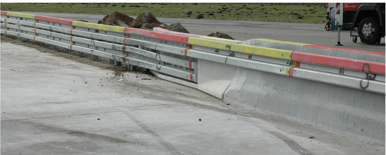
Bild 14: Übergangskonstruktion nach dem Versuch (Ansicht entgegen Anprallrichtung)
