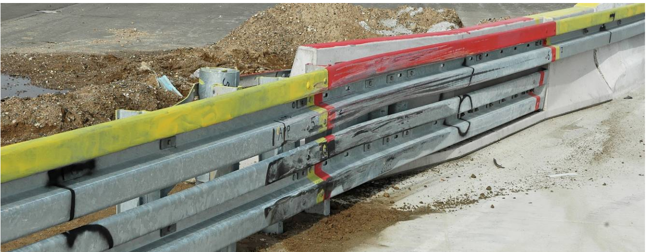
Bild 13: Übergangskonstruktion nach dem Versuch (Ansicht in Anprallrichtung)
