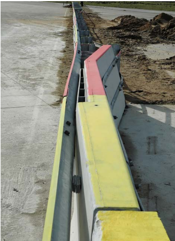
Betonfertigteil (Ansicht gegen Anprallrichtung)
