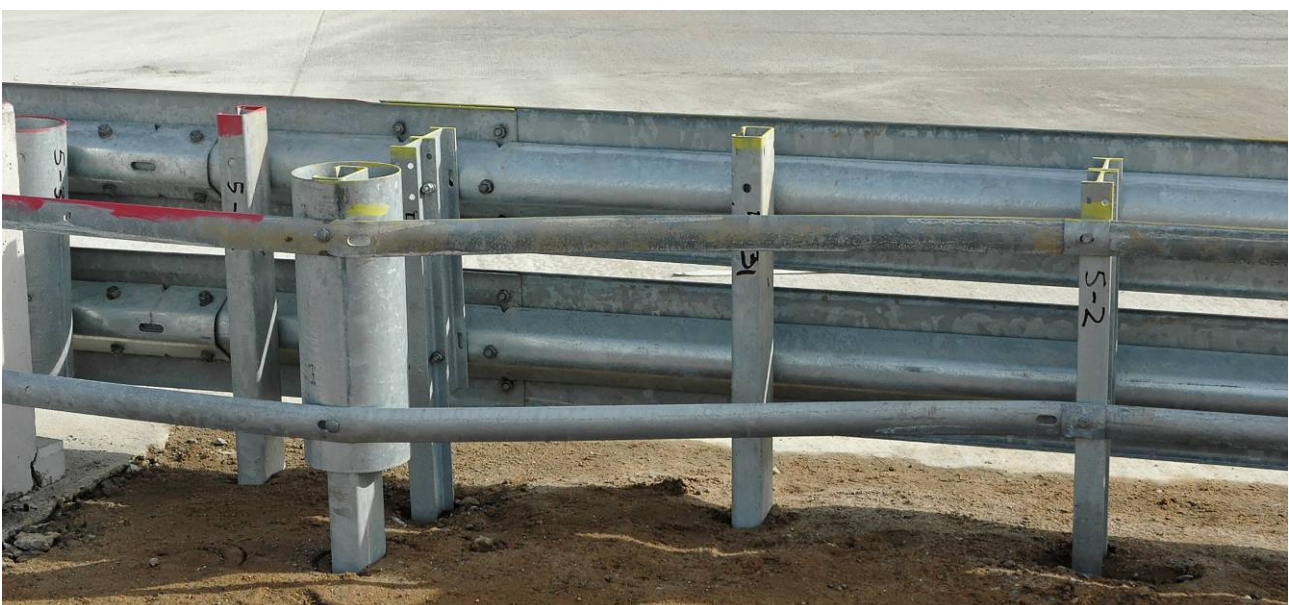
Bild 6: Übergang EDSP auf Betonschutzwand (Element 5 und 6 Systemrückseite)
