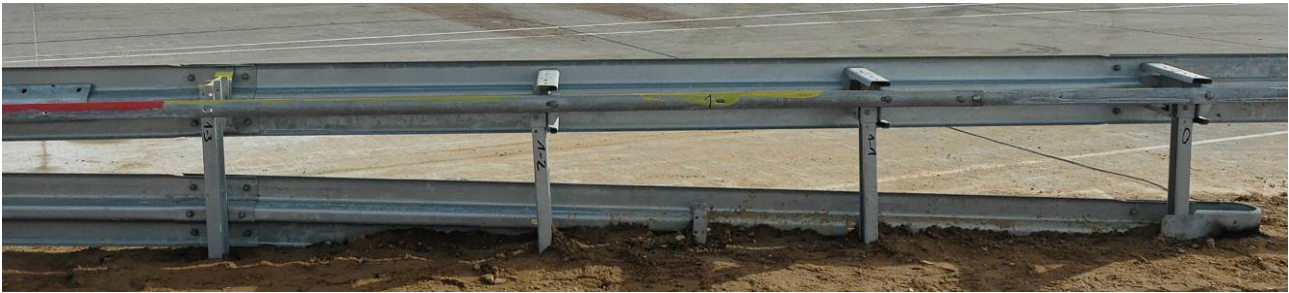
Bild 4: Beginn Übergang EDSP auf Betonschutzwand (Element 1 Systemrückseite)
