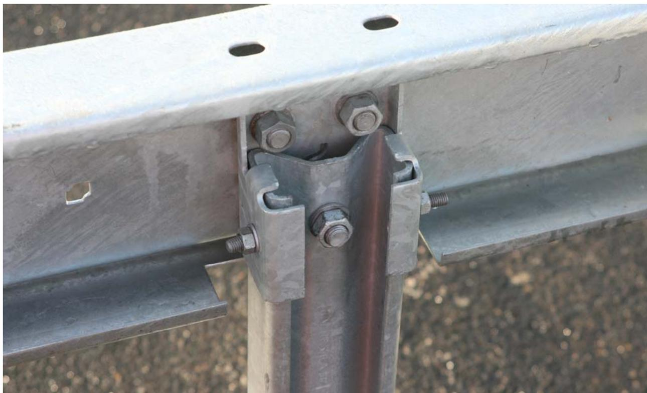
Bild 4: Gesicherter Steckpfosten (Detail)
