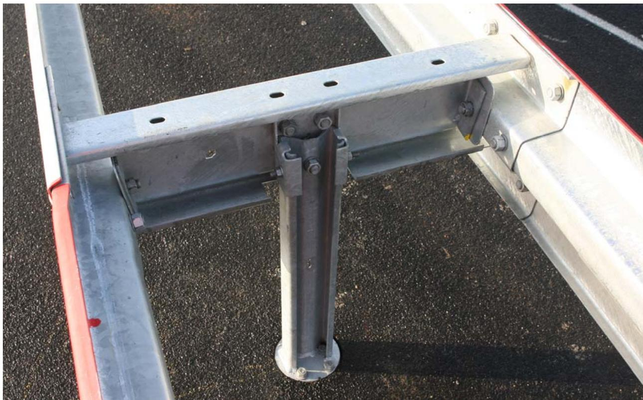
Bild 3: Distanzstück mit gesichertem Steckpfosten (Ansicht gegen Anprallrichtung)
