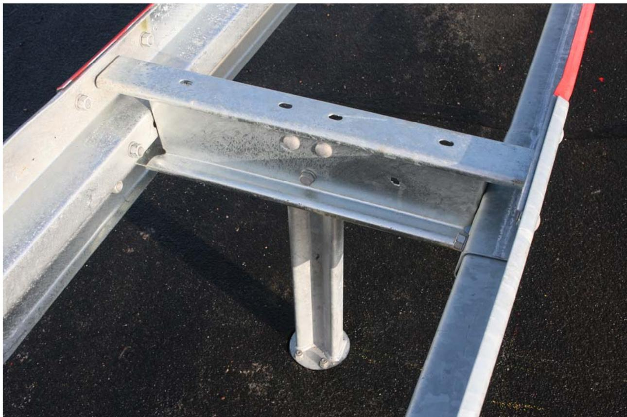
Bild 2: Distanzstück mit gesichertem Steckpfosten (Ansicht in Anprallrichtung)
