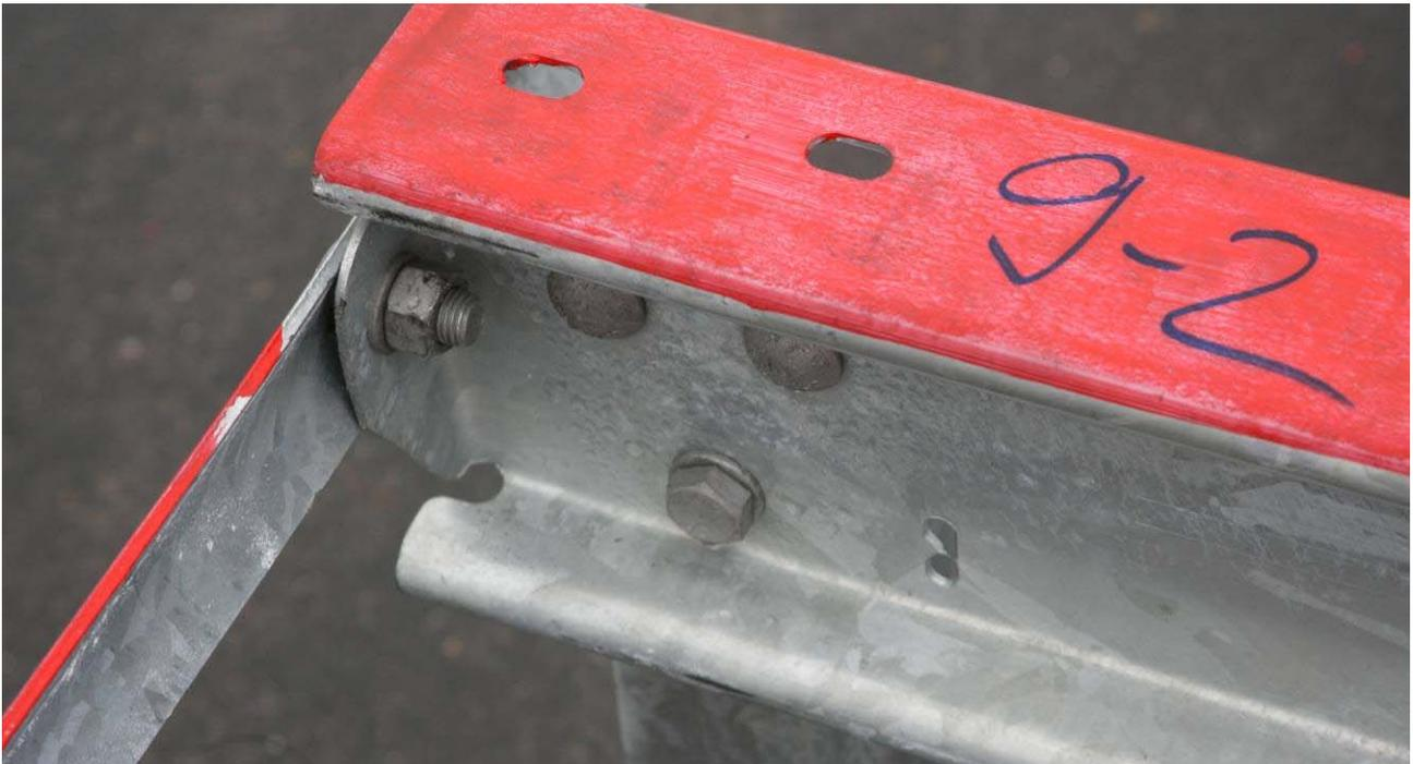
Bild 4: Steckpfostensicherung im Detail (anprallzugewandte Seite)
