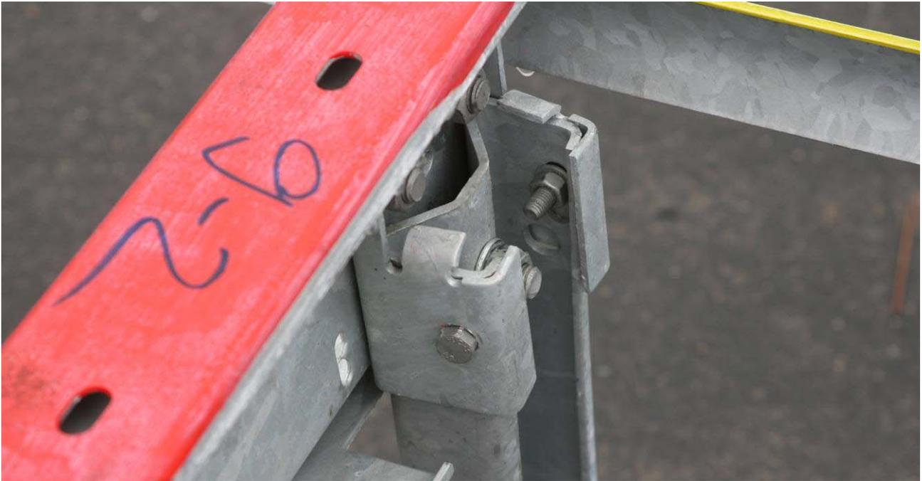
Bild 3: Steckpfostensicherung im Detail (anprallabgewandte Seite)
