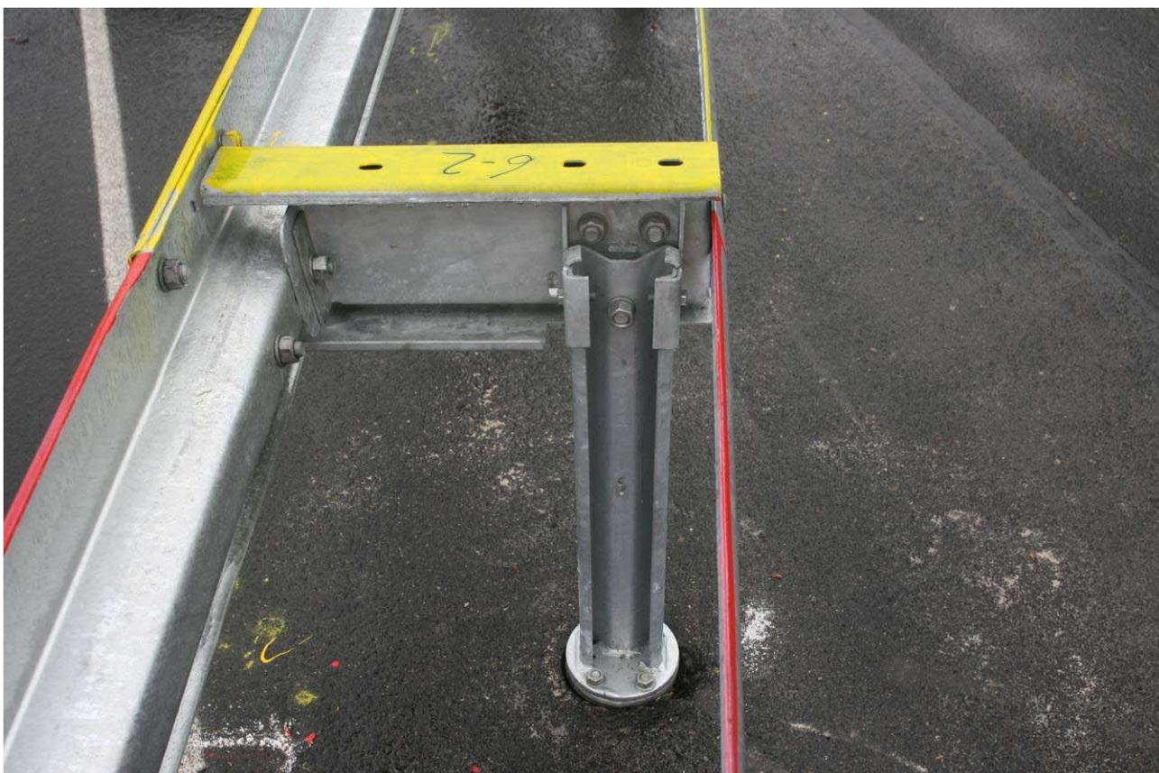
Bild 2: EDSP mit gesichertem Steckpfosten
