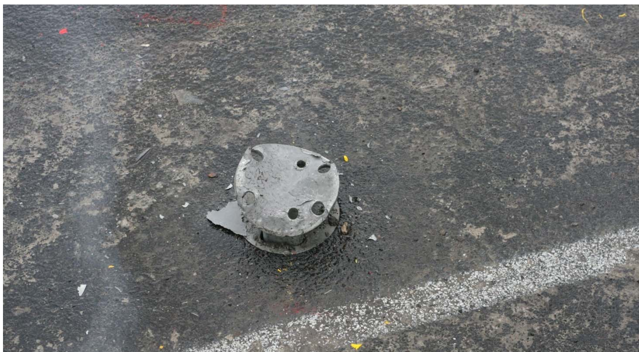
Bild 15: Teilweise herausgezogener Steckpfosten bei 12-1
