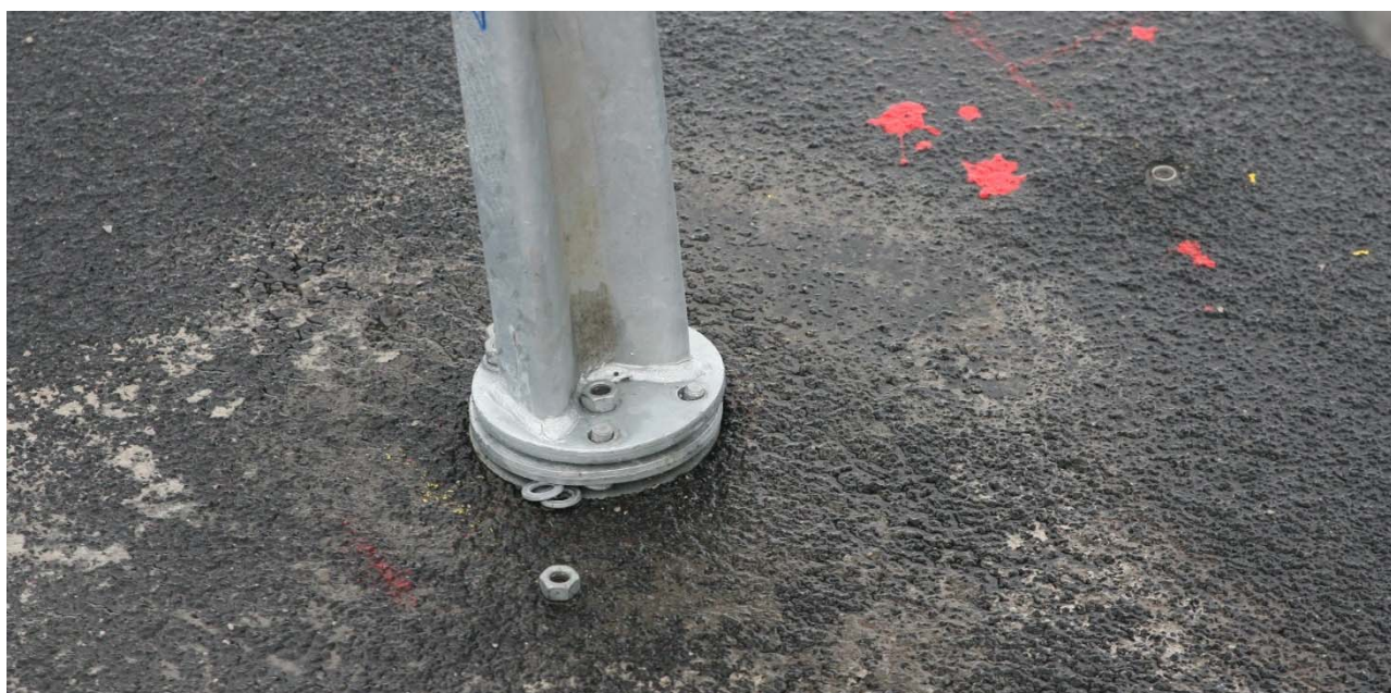
Bild 11: Gelöste Verschraubung bei Steckpfosten 2-2 (Detail)
