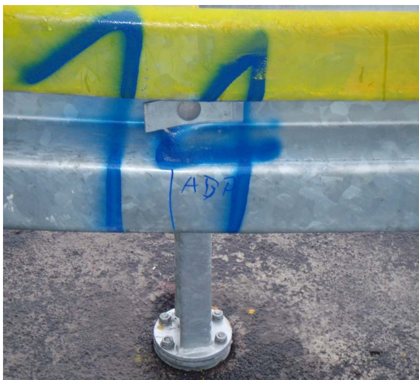
Bild 21: Abprallpunkt (1,83 m nach Stoß 13/14)
