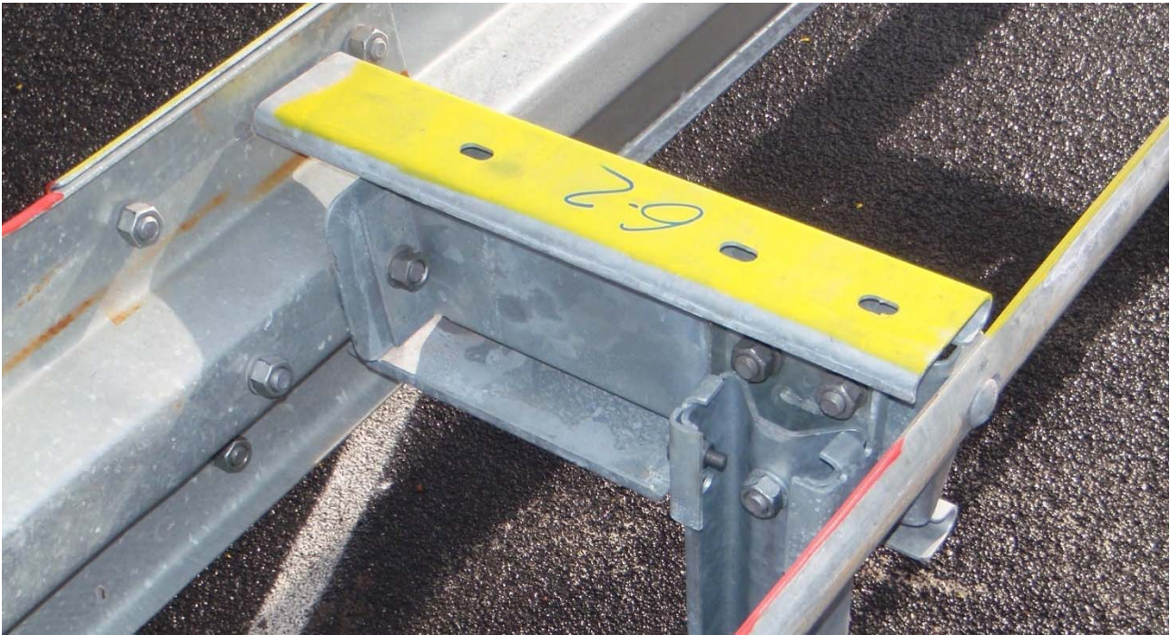
Bild 18: Verschraubung der Pfostensicherung am Abstandhalter vor Crash
