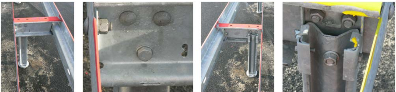
Bild 2: Sicherung des Steckpfostens
