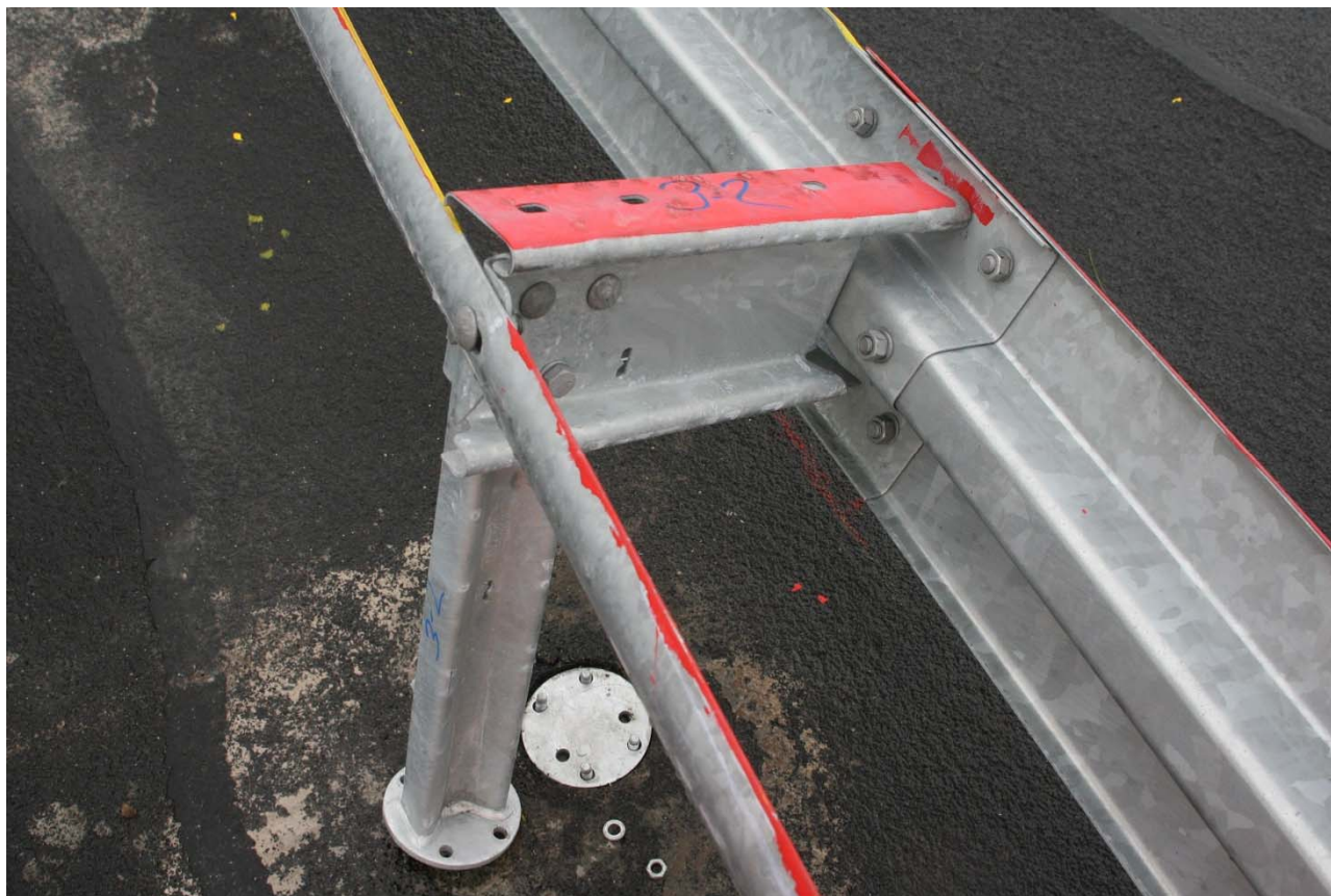
Bild 12: Vollständig gelöste Verschraubung bei Steckpfosten 3-2
