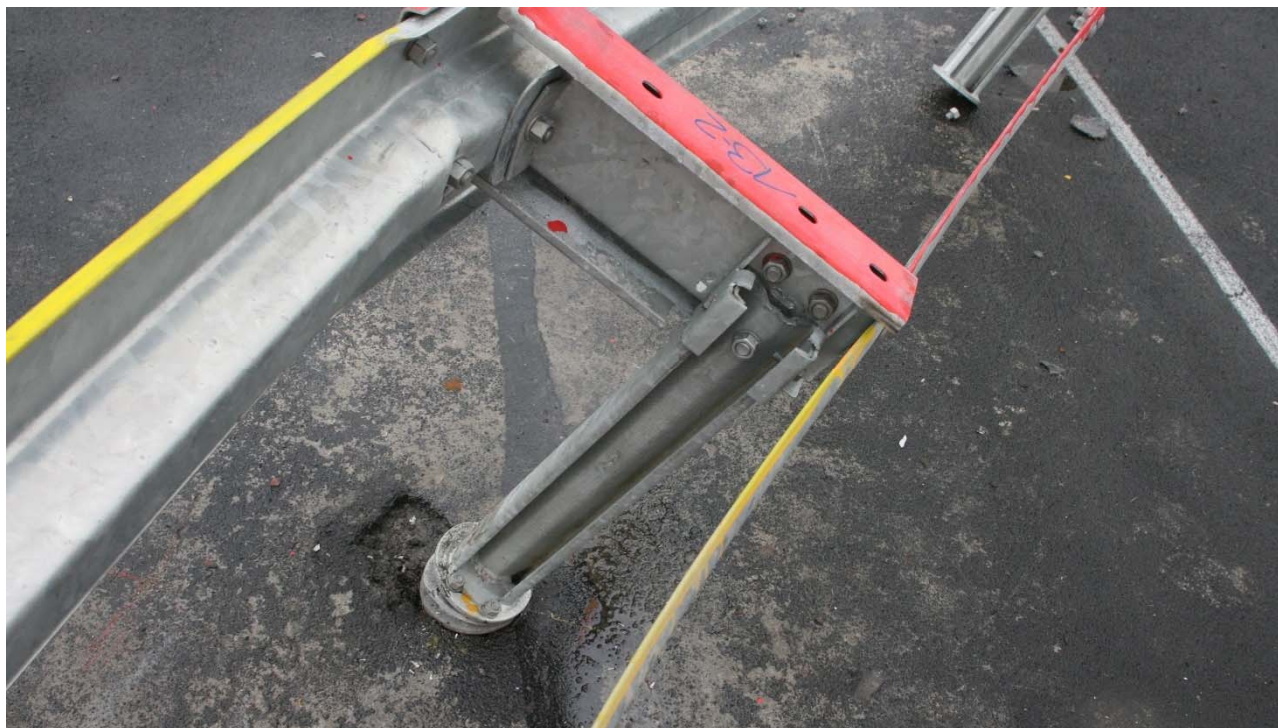
Bild 16: Steckpfosten 13-2 (intakte Schraubenverbindung)
