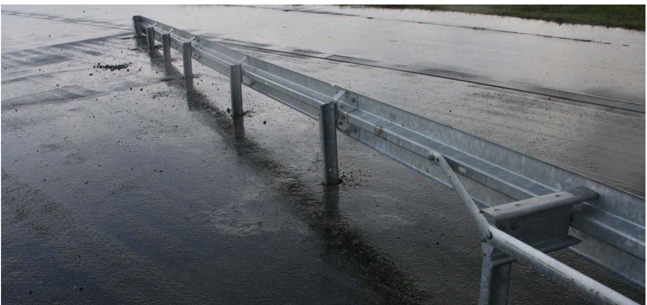
Bild 3: Ausführung der Regelabsenkung
