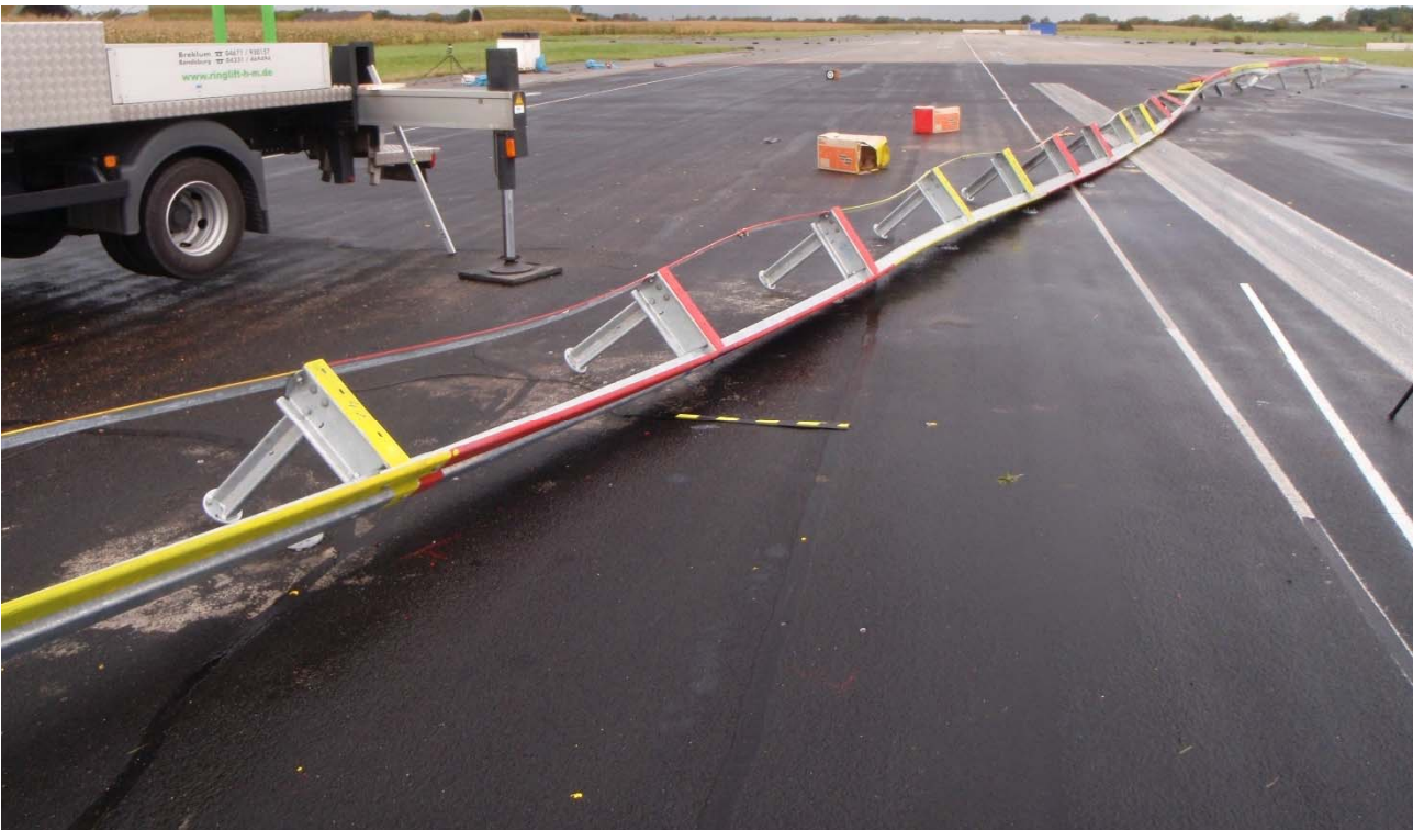
Bild 7: Schutzeinrichtung nach Crash (Ansicht in Anprallrichtung)
