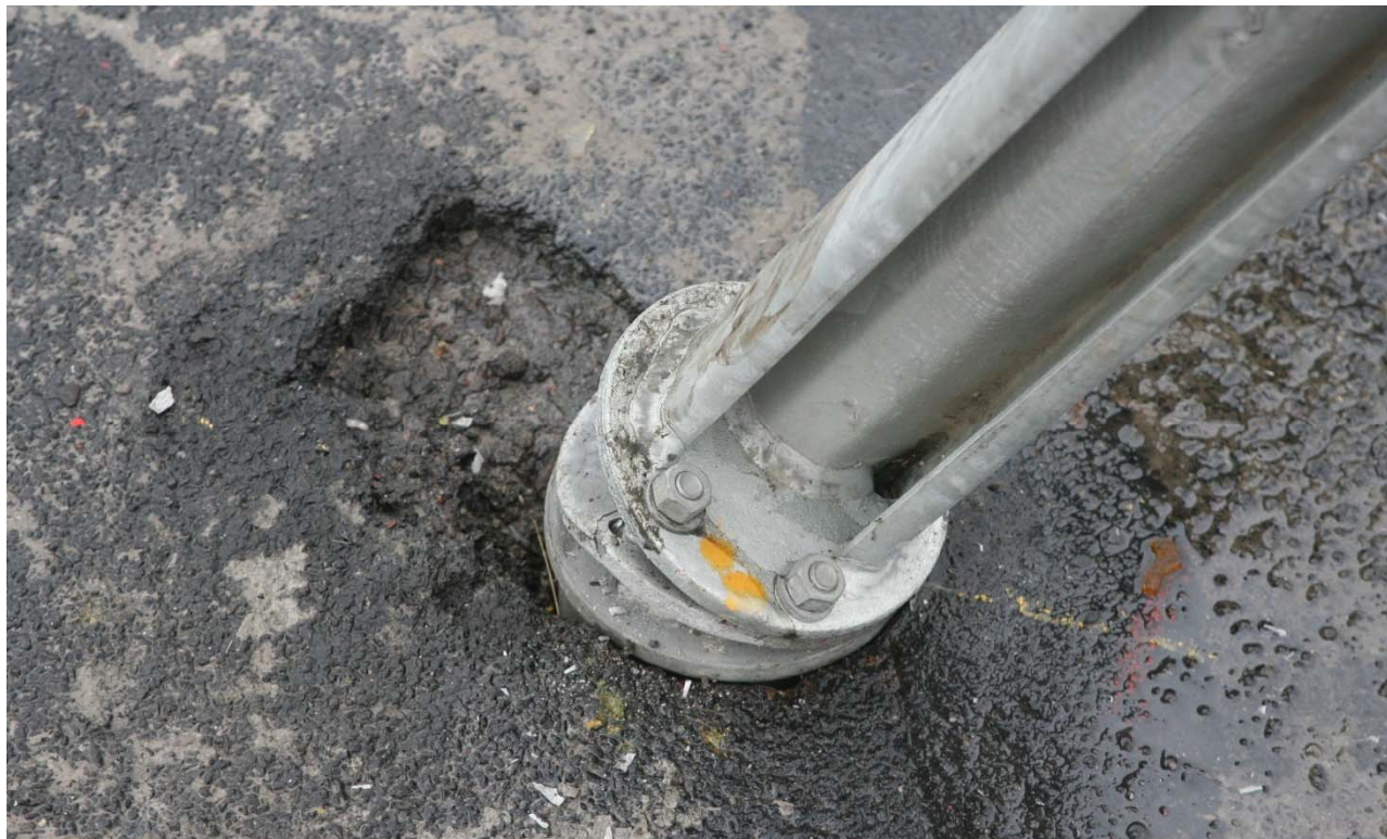
Bild 17: Steckpfosten 13-2 (Schraubenverbindung Detail)
