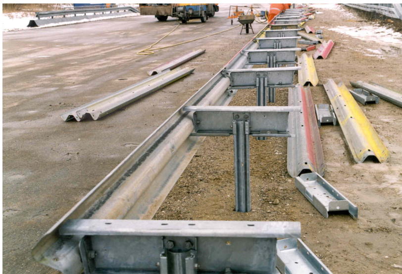
Bild 2: Montage der Elemente
