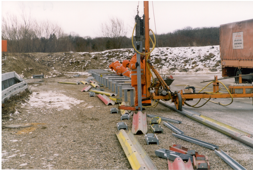
Bild 1: Rammen der Pfosten
