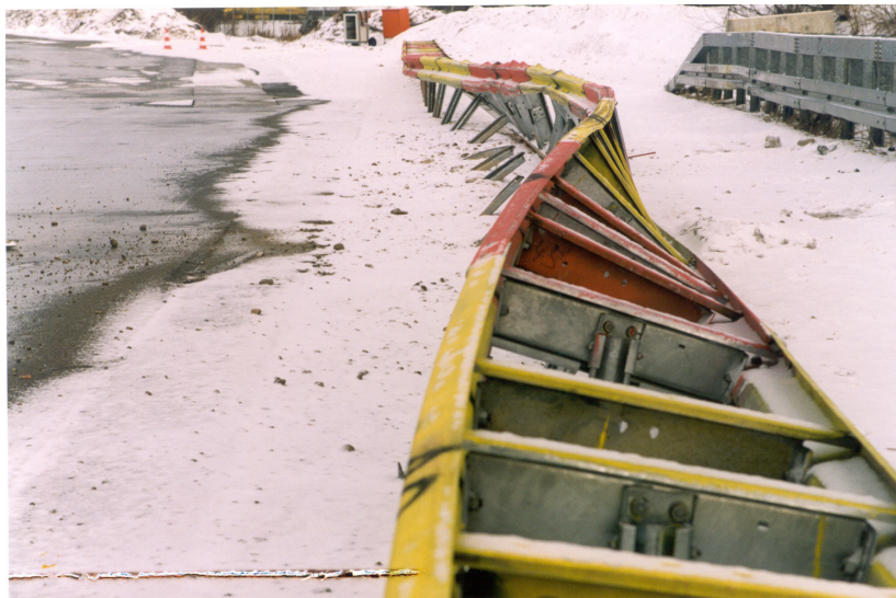
Bild 19: Verschiebung der Schutzeinrichtung (entgegen der Anprallrichtung)
