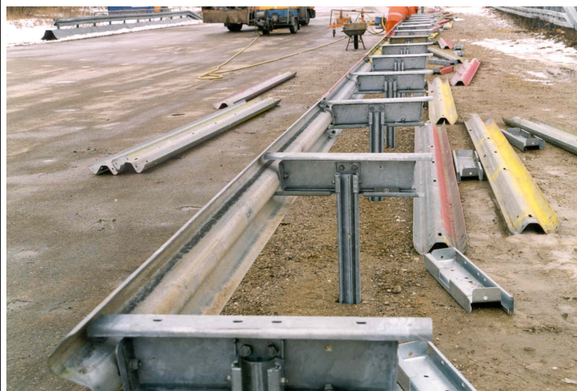
Bild 2: Montage der Elemente
