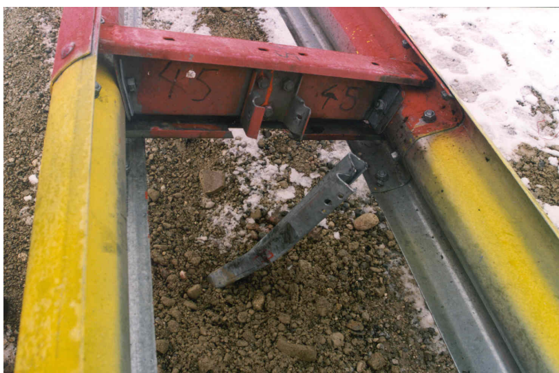
Bild 23: Detail: Distanzstück mit aus der Klaue gelöstem Pfosten
