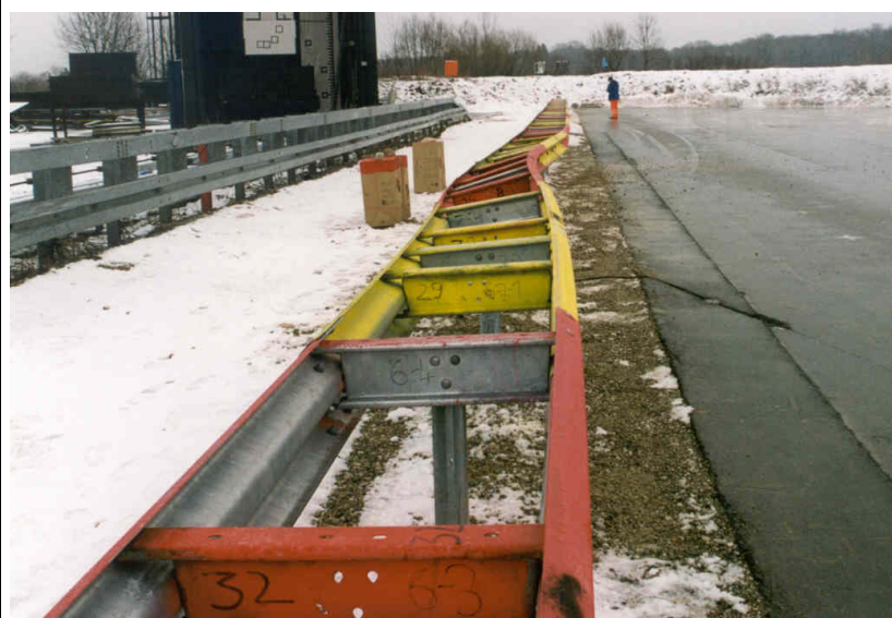
Bild 20: Verschiebung der Schutzeinrichtung
