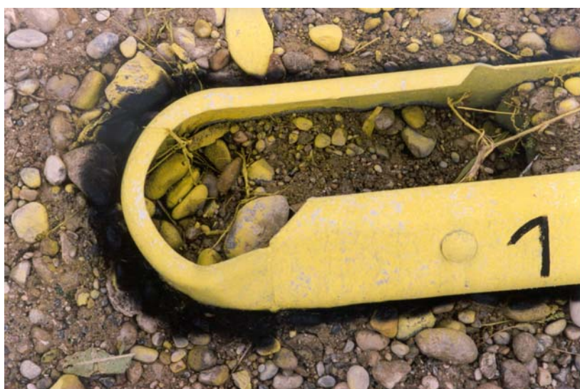
Bild 17: Kopfstück ohne Längsverschiebung
