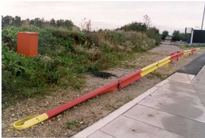
Bild 1: Anfangs- und Endkonstruktion mit angeschlossener Schutzeinrichtung
