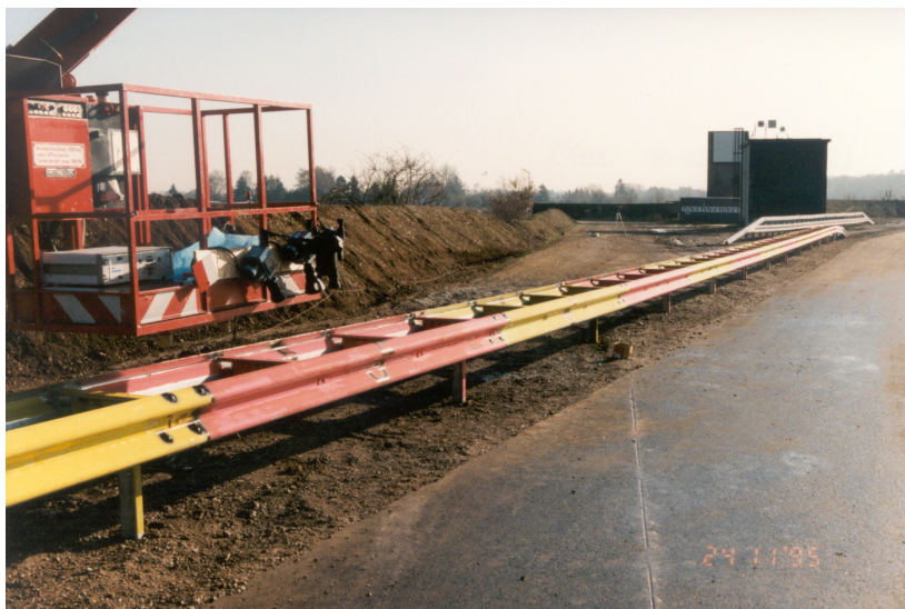
Bild 2: Schutteinrichtung Gesamtansicht mit Endabsenkung
