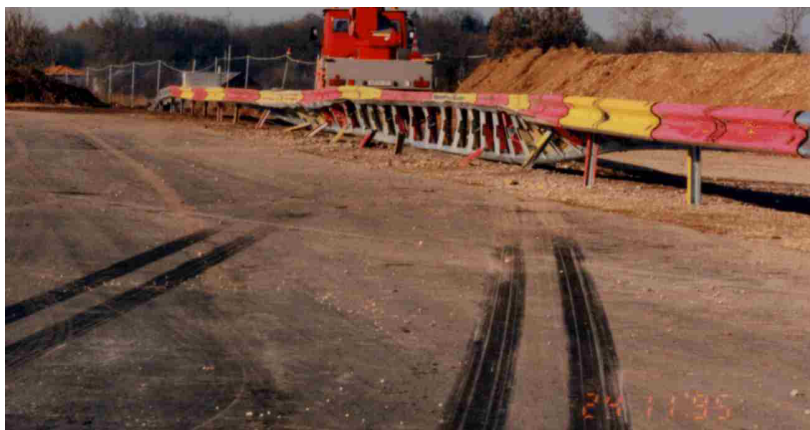
Bild 17: Schutzeinrichtung nach der Prüfung
