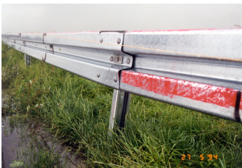
Bild 9: Schäden ab dem tatsächlichen Anprallpunkt (Kon- taktstrecke)
