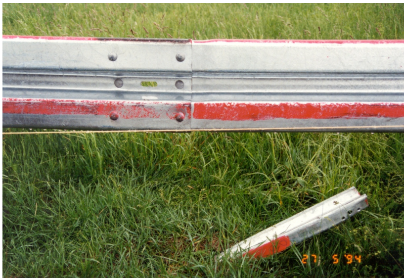
Bild 11: Detail: abgetrennter Pfosten
