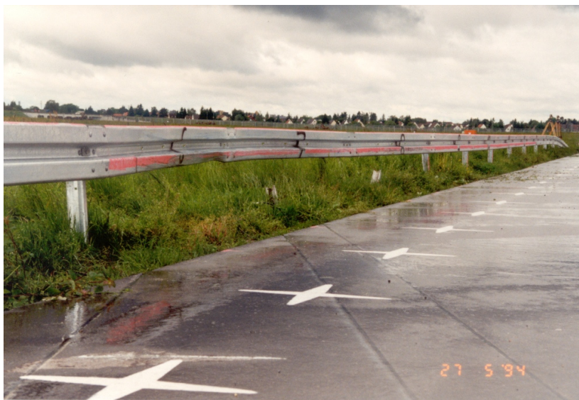
Bild 8: Schutzeinrichtung nach der Prüfung
