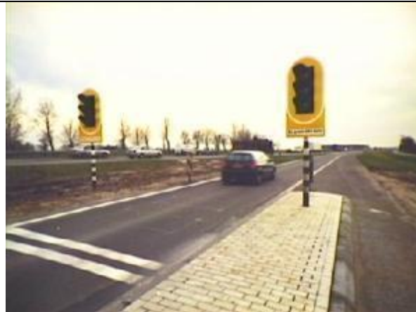
Abbildung 18: Signalanlage auf niedriger Ebene RWS
