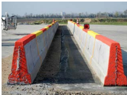
a) Schutzeinrichtungen aus Ortbeton
