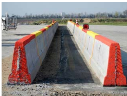
a) Schutzeinrichtungen aus Ortbeton
