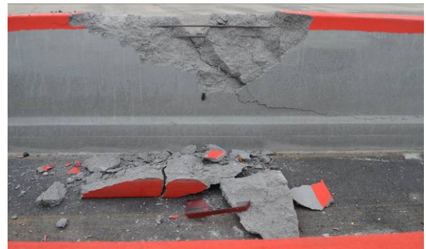
Abbildung 9 gelöste Bruchstücke aus dem Kopfbereich von Segment 7 (Ansicht)
