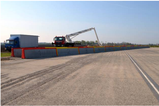
Abbildung 4 Betonschutzwände aus Annäherungsrichtung
