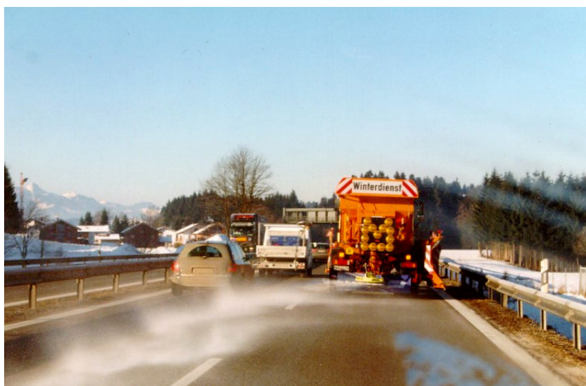
Abbildung 15: Ausbringung von trockenem feinkörnigen Salinensalz (ca. 30 g/m 2 bei ca. 50 km/h)
