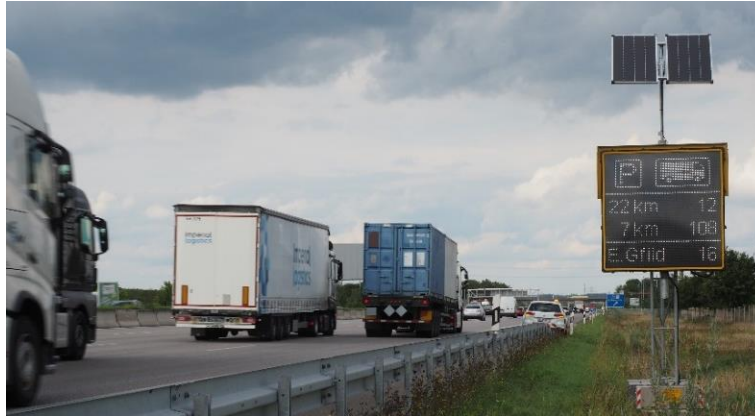
Abbildung 5: Foto einer LED-Anzeige für die Rastanlage Echinger Gfild auf der A9 in Fahrtrichtung Nürnberg aus der Umfrage [Quelle: Landesbaudirektion Bayern, Zentralstelle Verkehrsmanagement]
