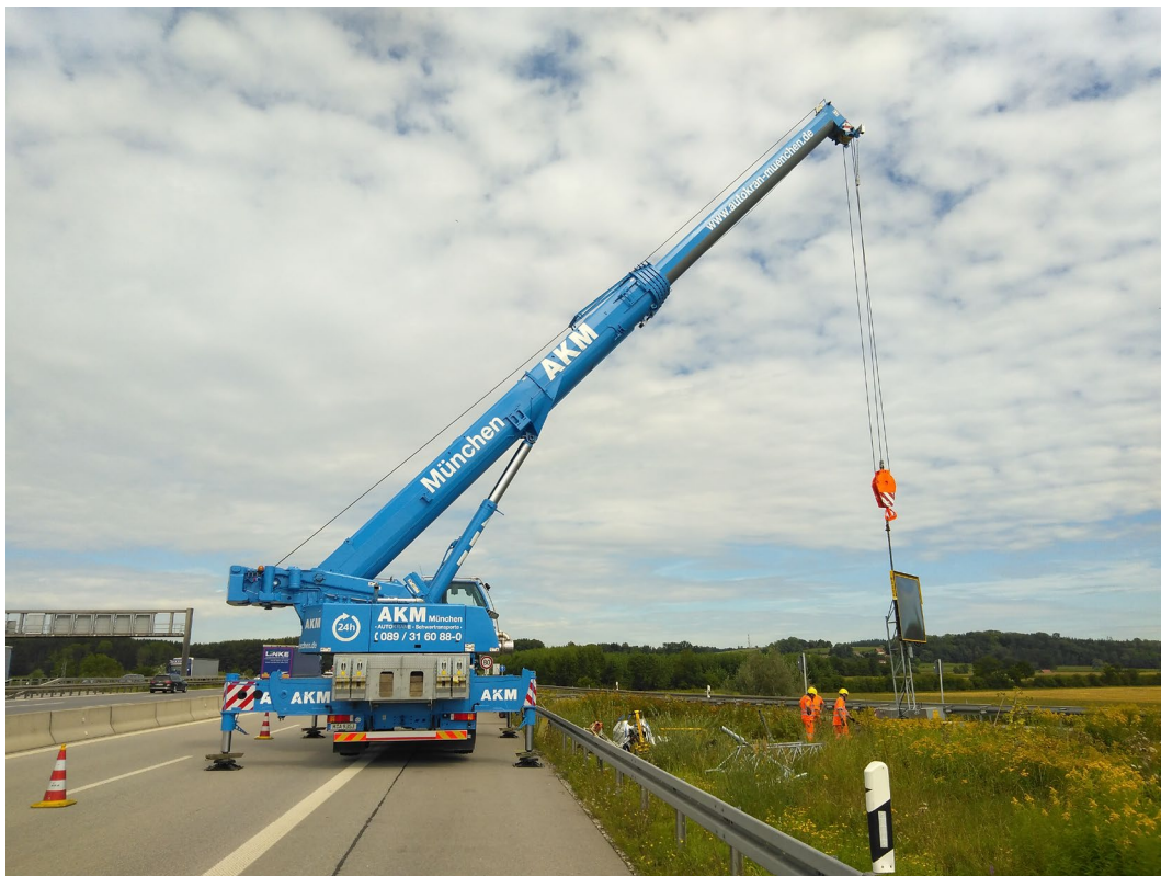
Abbildung 14: Montage mobile LED-Anzeige in einer rechtsliegenden Rampe (1 Fahrstreifen) am AK Neufahrn
