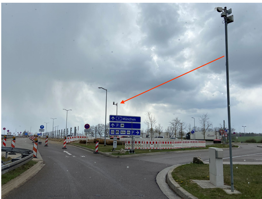
Abbildung 21: Versetzen der ANPR-Kamera vom Scannermast zum Gabelständer, T+R Köschinger Forst West
