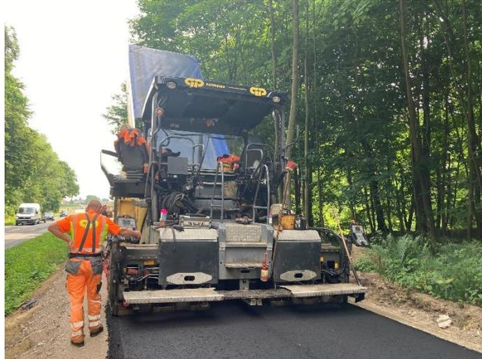
Abbildung 5: Einbau Asphalttragschicht - Tutow
