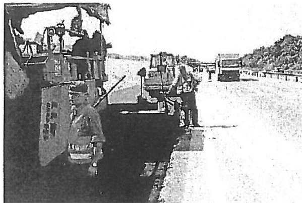
Abb. 4: Arbeitsraum neben dem Fertiger mit Höhentaster bei ausreichendem Sicherheitsabstand zum fließenden Verkehr
