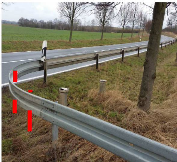
Bild 6: Ausbildung Einmündung mit kleinem Radius ohne Pfosten
