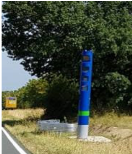
Bild 8: Mautkontrollsäule mit BOS Primus 2a
