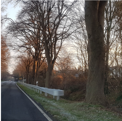
Bild 7: Zu kurze Ausführung einer Absicherung
