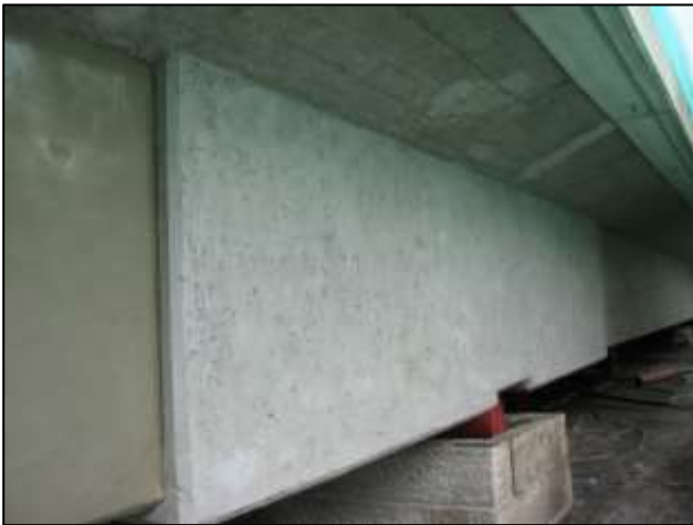
Bild 6: Ansicht Spritzbetonoberfläche nach Spritzvorgang und nach Fertigstellung
