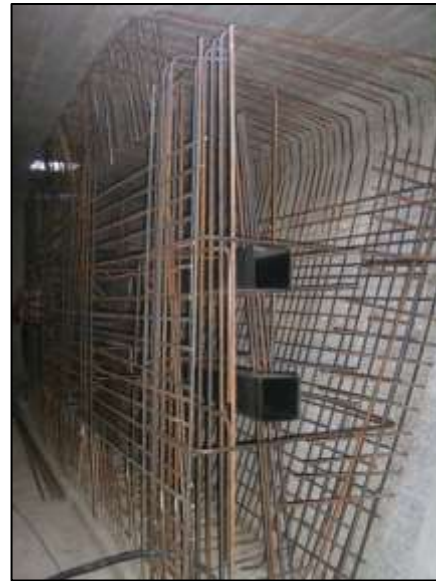
Bild 3: Bewehrung der Ankerblöcke zur Verankerung der nachträglich ergänzten Längsspannglieder
