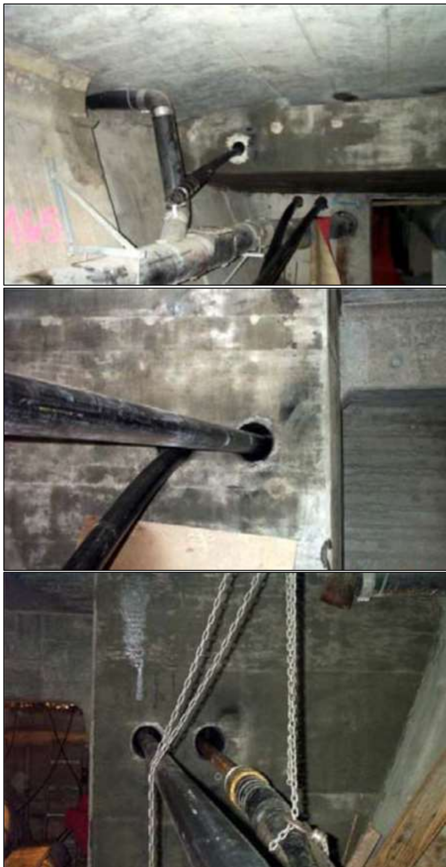
Bild 15: Externe Vorspannung (Ausführung)
