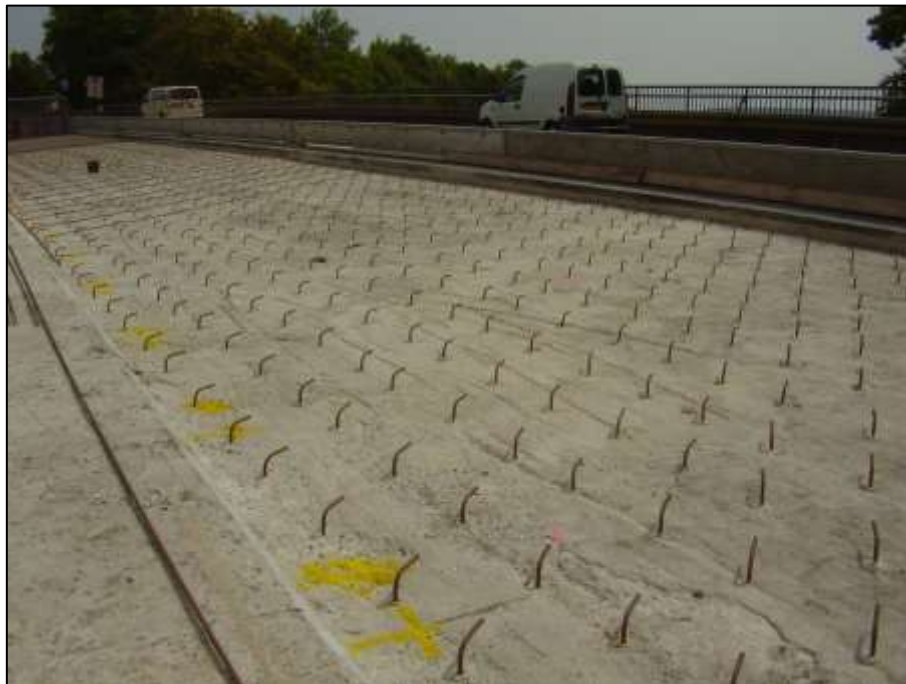
Bild 6: Verdübelung zwischen Konstruktionsbeton und Ortbetonergänzung
