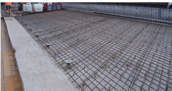
Bild 20: Bewehrung der Ortbetonergänzung (Erfahrungssammlung Beispiel 3.4)
