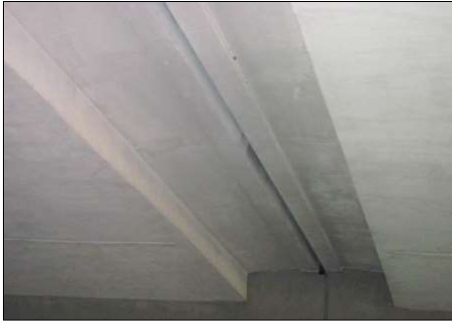
Bild 4: Unteransicht Mittelkappen und Kragarme
