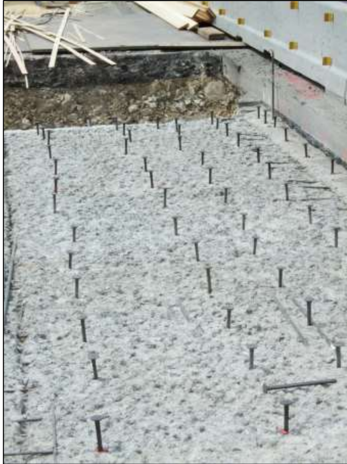
Bild 9: Gestaffelte Anordnung der Verbundanker
