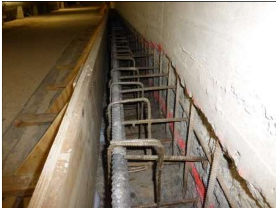
Bild 3: Vorbehandelte Oberfläche, Schalung und Bewehrung des zusätzlich anbetonierten Stahlbetonbalkens
