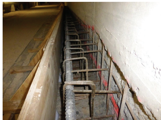
Bild 36: Beispiel für eine Querschnittsergänzung in Form eines anbetonierten Stahlbetonbalkens: Ausführung (vorbehandelte Oberfläche, Schalung und Bewehrung, Erfahrungssammlung Beispiel 7.4)
