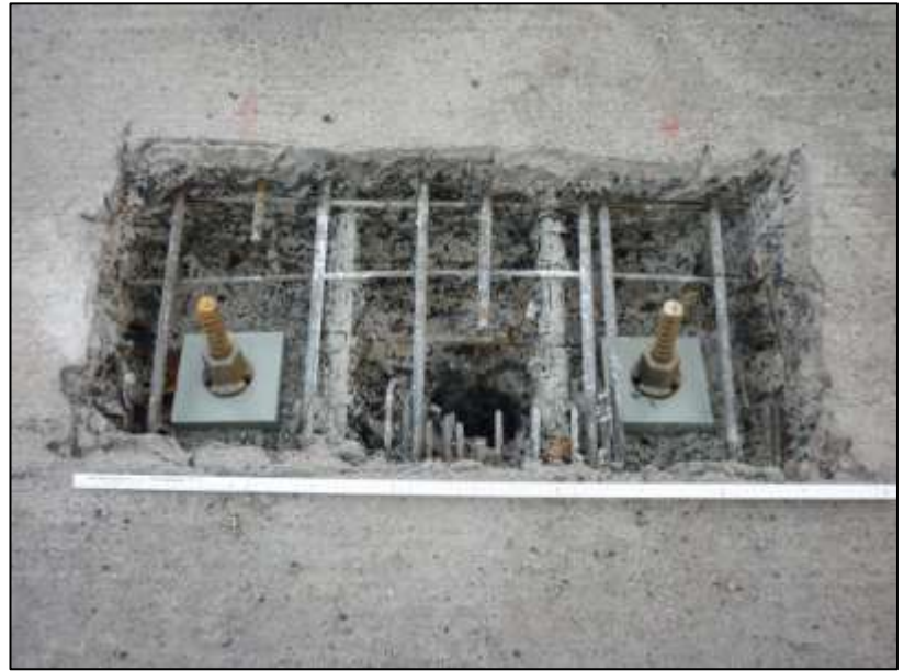
Bild 4: Kernbohrungen und Verankerungsdetail in der Fahrbahnplatte der Querkraftverstärkung (Ausführung)
