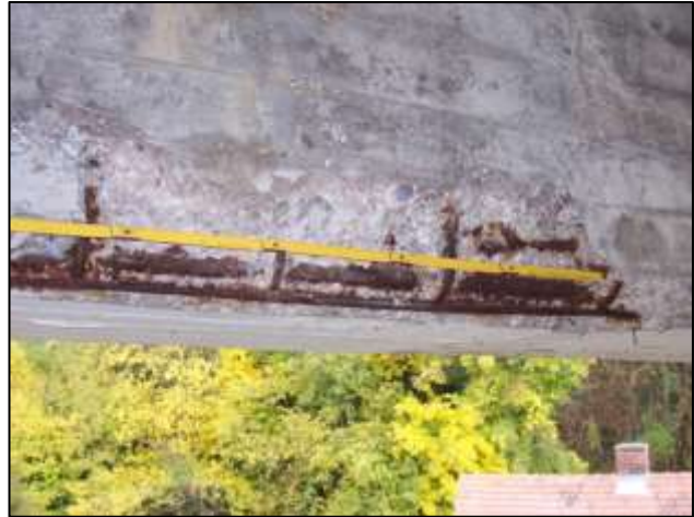
Bild 2: Schadensbild: Betonabplatzungen und Korrosion der Bewehrung
