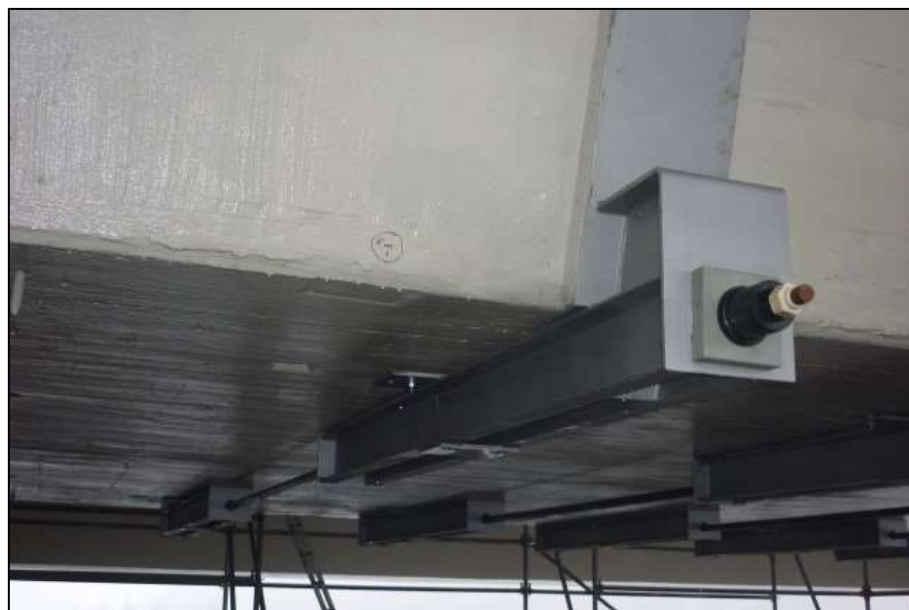
Bild 7: Torsionsverstärkung (Ausführung)
