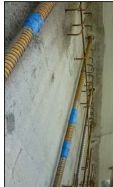
Bild 4: Kernbohrungen und Verankerungsdetail in der Fahrbahnplatte der Querkraftverstärkung (Ausführung)
