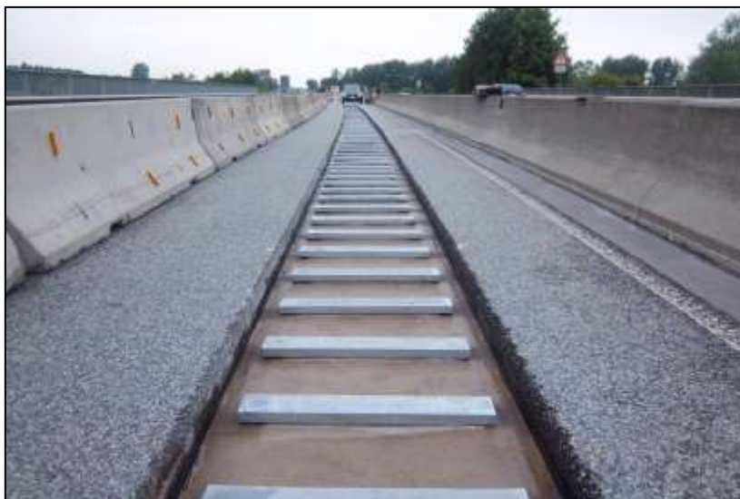
Bild 6: Anschweißplatten Brückenoberseite (Ausführung)
