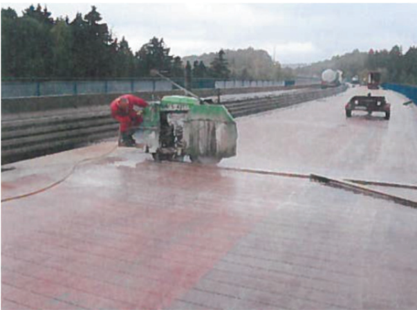
Bild 27: Maschinelle Herstellung der Schlitze (Erfahrungssammlung Beispiel 6.2)
