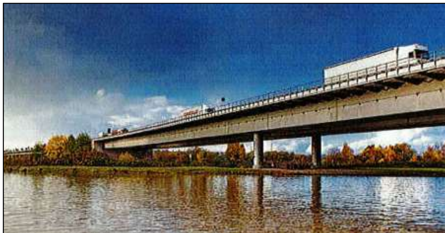
Bild 1: Übersichtsfoto des Brückenbauwerks
