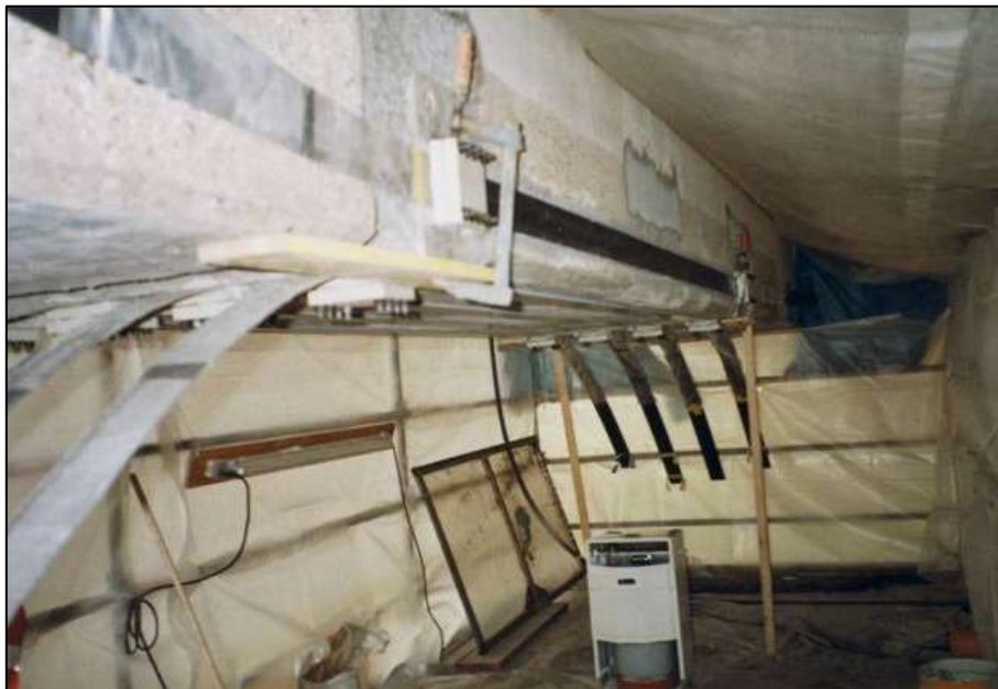
Bild 3: Lokale Verstärkung – vorgespannte CFK-Lamellen
