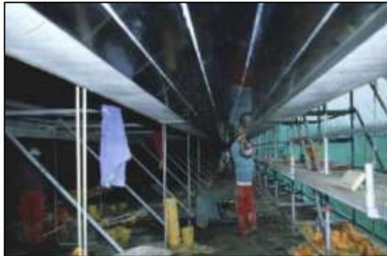
Bild 5: CFK-Lamellen im Zugbereich der Randträger, abgestreut und noch nicht beschichtet
