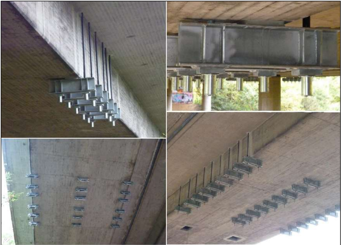
Bild 6: Verankerung der zusätzlichen Querkraftverstärkung (Ausführung)
