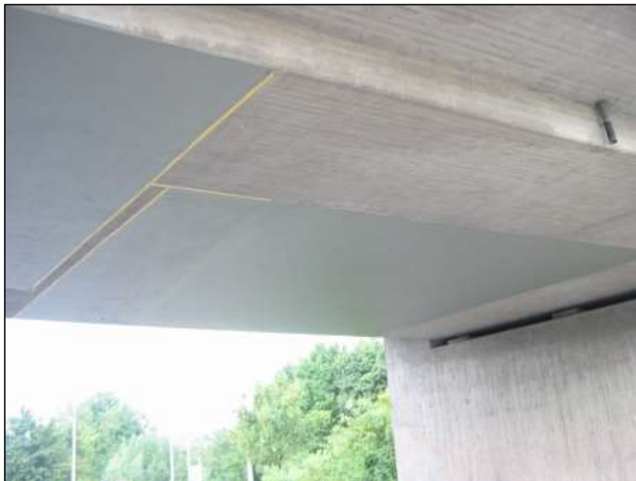
Bild 8: Untersicht nach erfolgter Verstärkung
