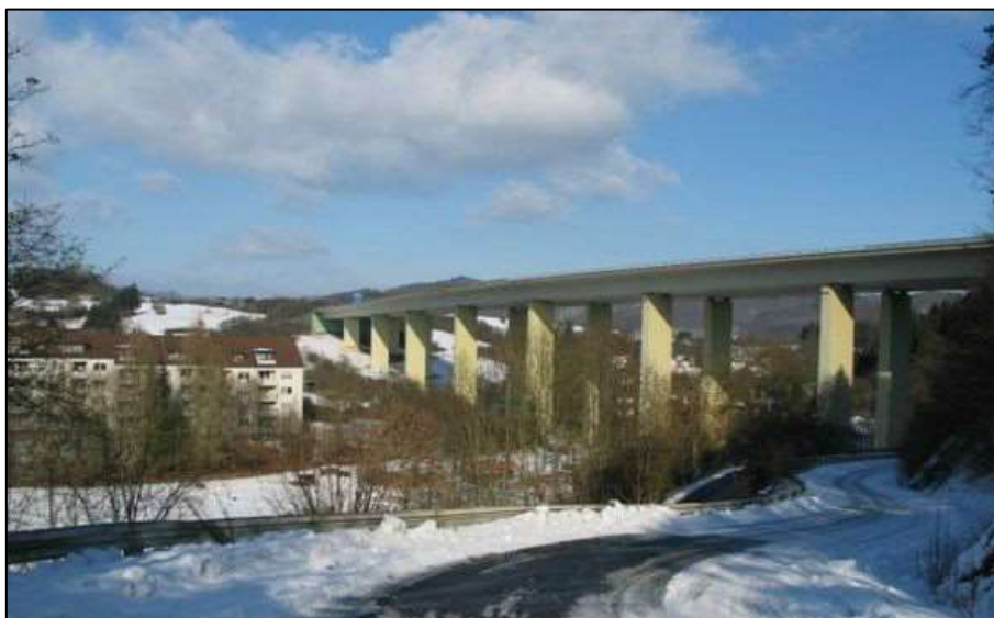
Bild 1: Übersichtsfoto des Brückenbauwerks
