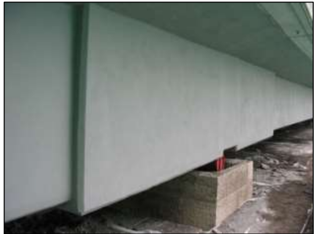
Bild 6: Ansicht Spritzbetonoberfläche nach Spritzvorgang und nach Fertigstellung
