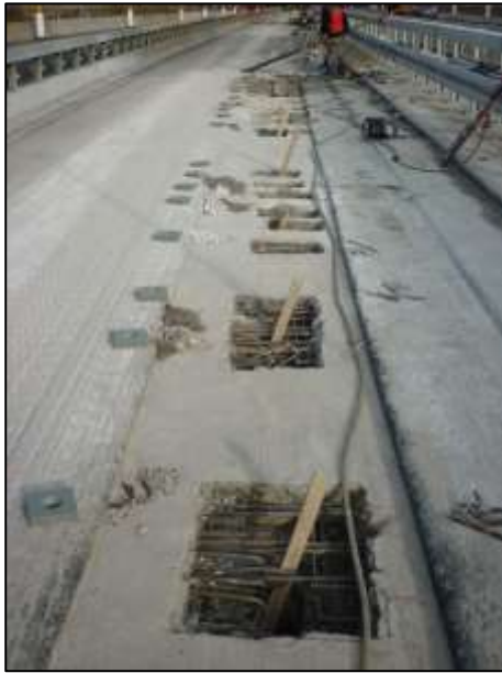
Bild 4: Kernbohrungen und Verankerungsdetail in der Fahrbahnplatte der Querkraftverstärkung (Ausführung)
