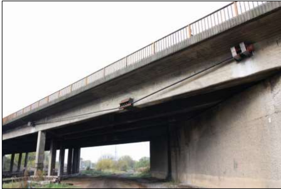
Bild 3: Verlauf der externen Spannglieder
