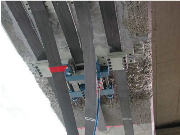
Bild 31: Verankerungselemente des Vorspannsystems SLC II, (PETERS, 2013)
