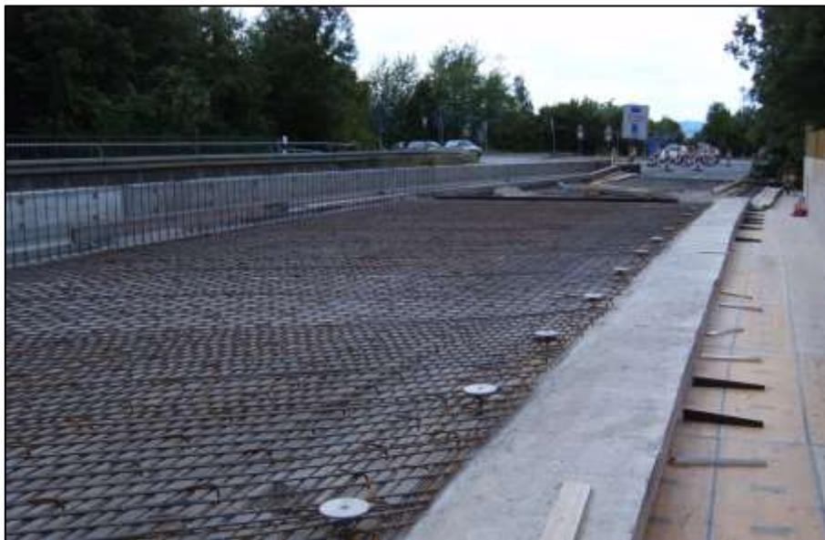
Bild 4: Bewehrung der Ortbetoneergänzung
