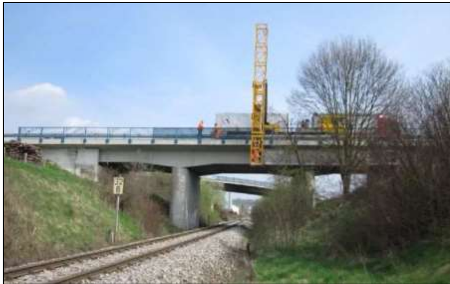
Bild 1: Übersichtsfoto des Brückenbauwerks
