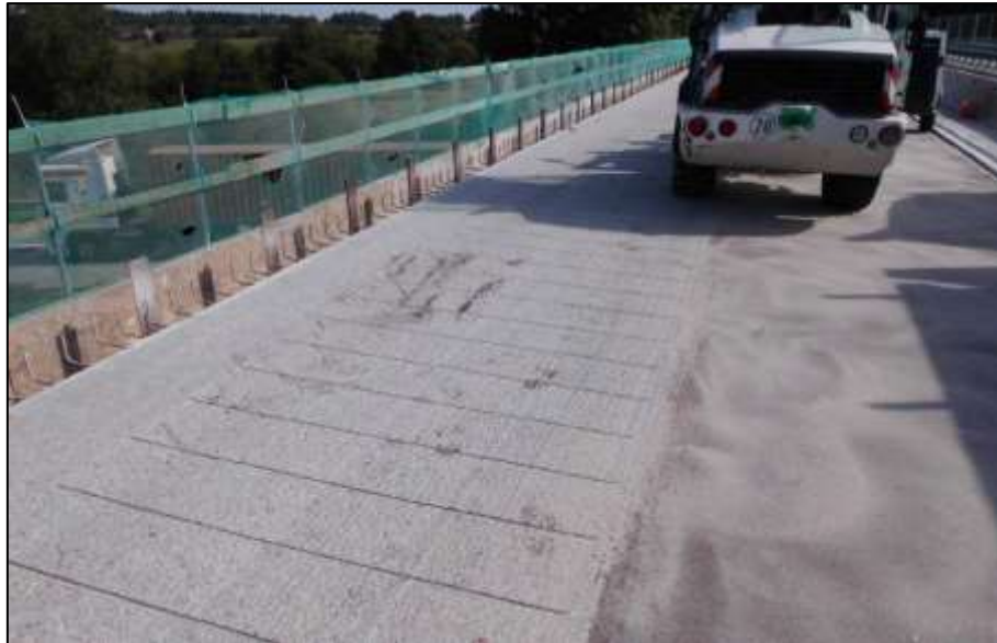
Bild 6: Schlitze für die CFK-Lamellen im Kragarm des Plattenbalkens
