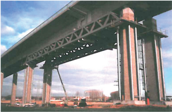
Bild 37: Fachwerkssystem unter einem Brückenfeld
