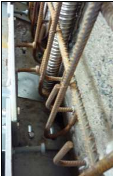
Bild 5: Querkraftverstärkung (Ausführung)
