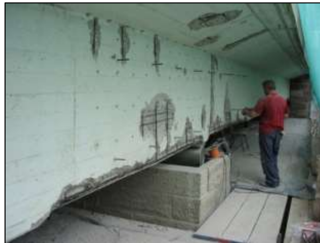
Bild 3: Vorbereitung der Betonoberfläche
