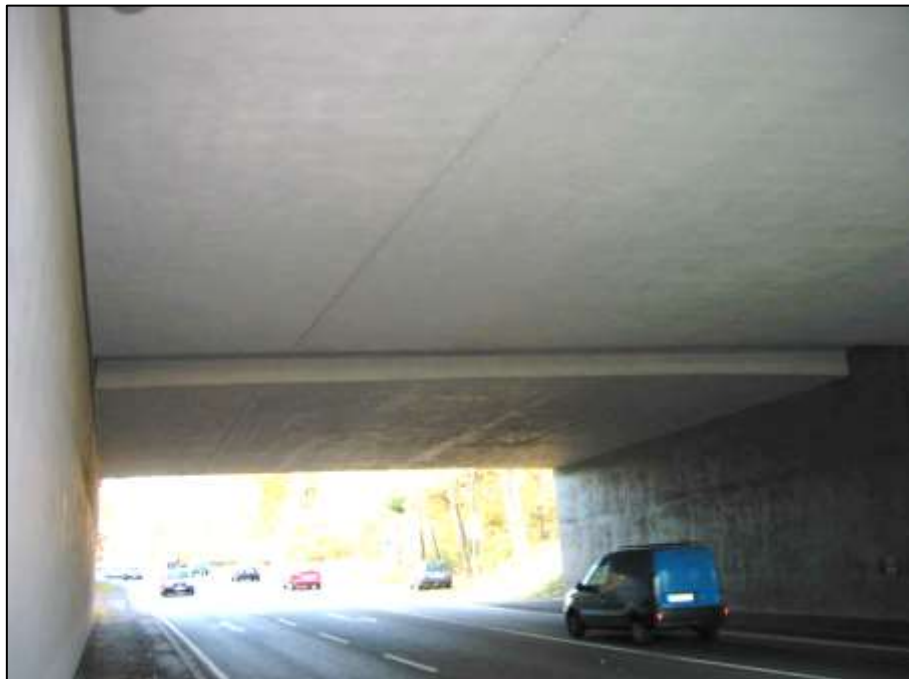
Bild 5: Unteransicht Überbau nach der Verstärkung
