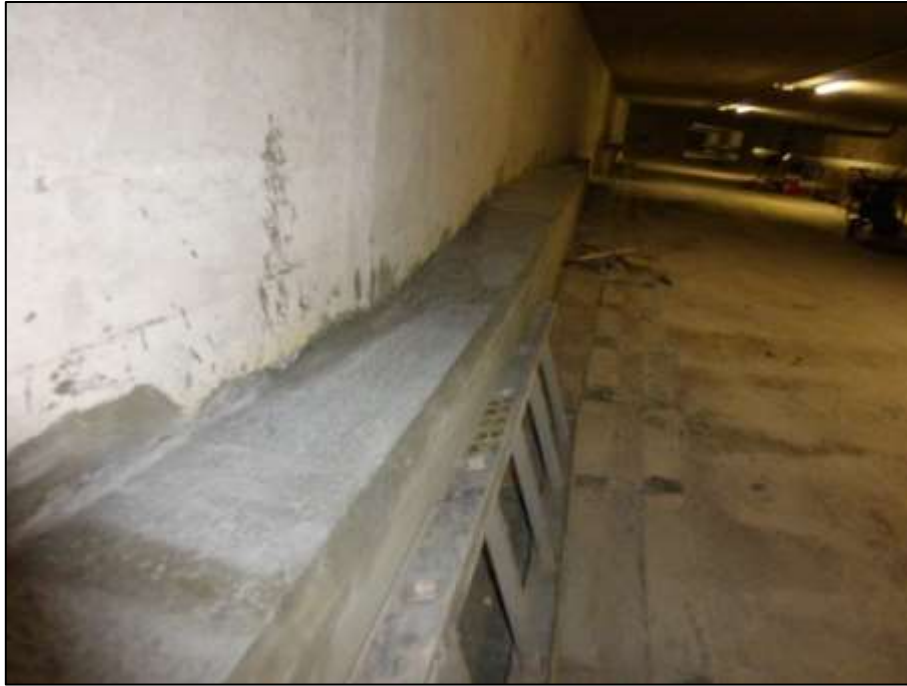
Bild 4: Zusätzlich anbetonierter Stahlbetonbalken
