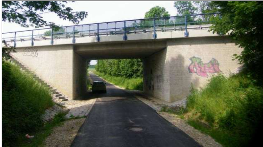
Bild 1: Übersichtsfoto des Brückenbauwerks
