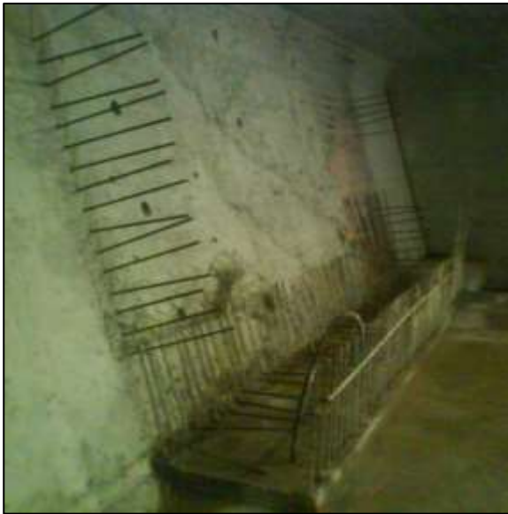
Bild 3: Bewehrung der Ankerblöcke zur Verankerung der nachträglich ergänzten Längsspannglieder
