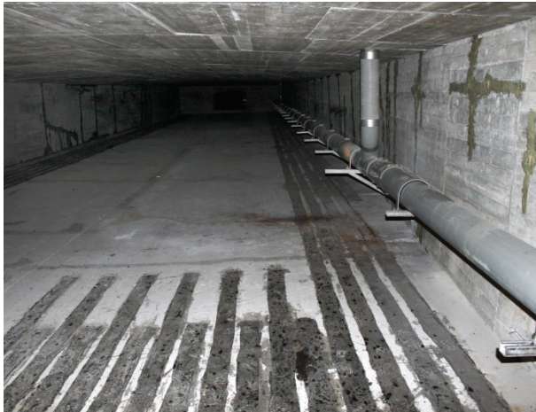
Bild 32: Aufgeklebte Stahllaschen in einem Brückenhohlkasten
