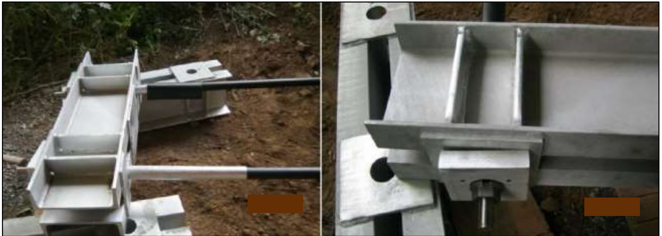
Bild 5: Stahltraversen zur Verankerung der zusätzlichen Querkraftbewehrung an der Brückenunterseite
