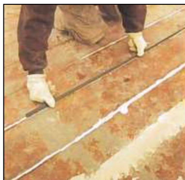
Bild 13: Einbringen der CFK-Lamelle in die Schlitze
