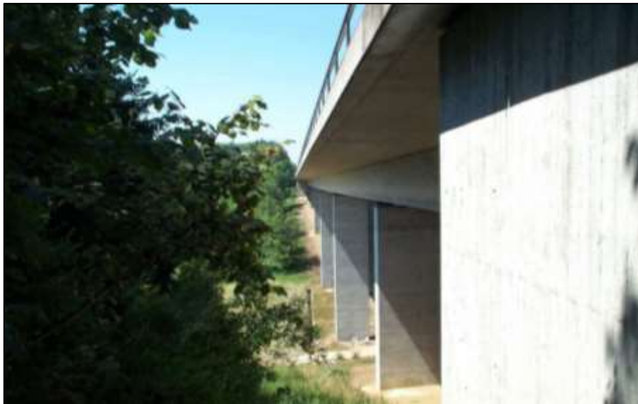
Bild 2: Übersichtsfoto des Brückenbauwerks
