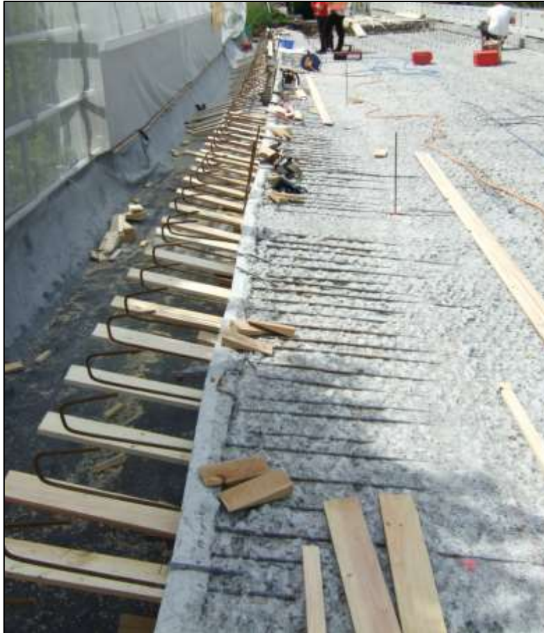
Bild 8: Eingebaute Steckbügel der Fahrbahnplatte
