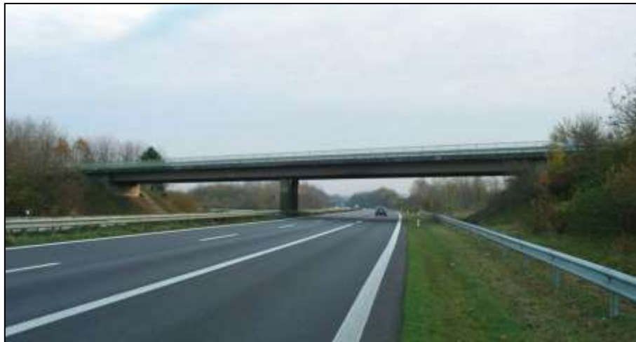
Bild 1: Übersichtsfoto des Brückenbauwerks
