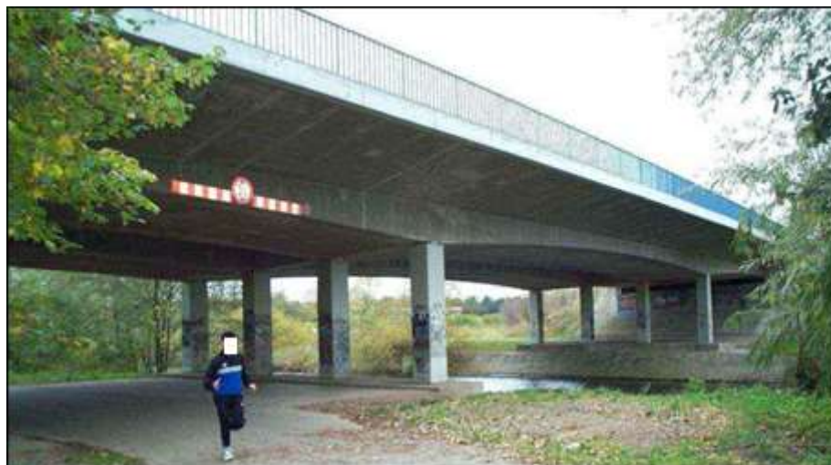
Bild 1: Übersichtsfoto des Brückenbauwerks
