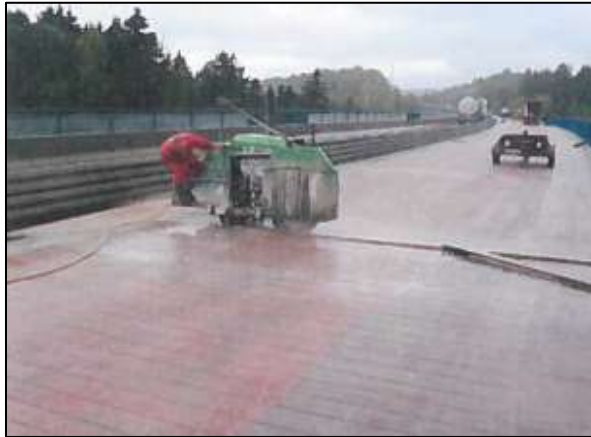
Bild 7: Schneiden der Schlitze
