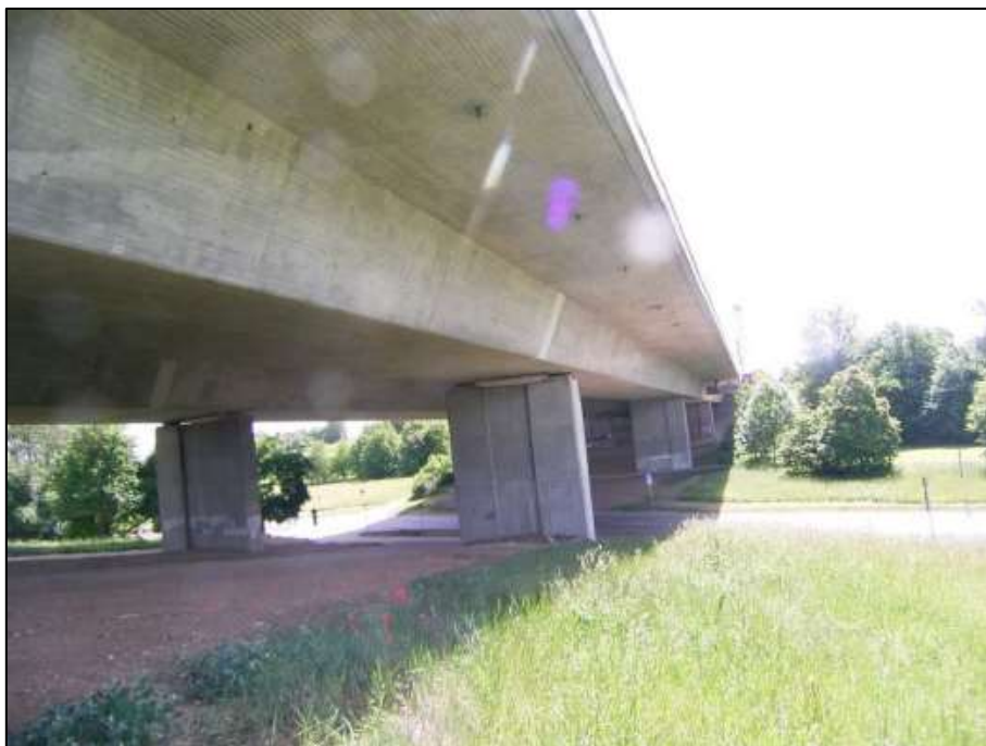
Bild 1: Übersichtsfoto des Brückenbauwerks
