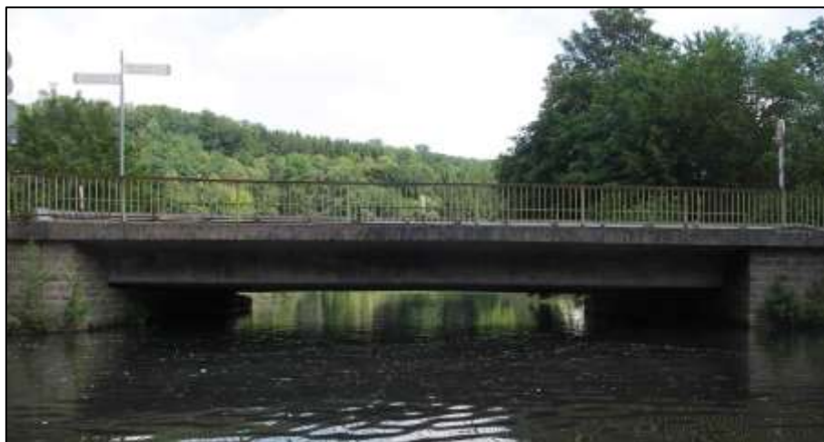
Bild 1: Übersichtsfoto des Brückenbauwerks
