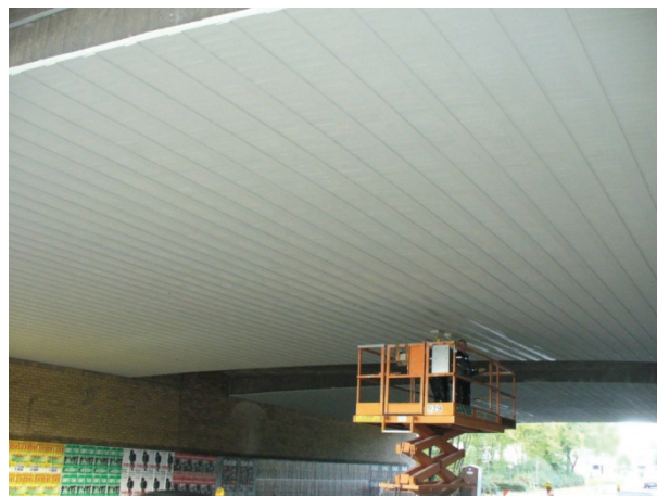
Bild 24: Untersicht nach der Verstärkung (Erfahrungssammlung Beispiel 5.2)
