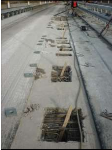
Bild 10: Kernbohrungen und Verankerungsdetail in der Fahrbahnplatte der Querkraftverstärkung (Ausführung)
