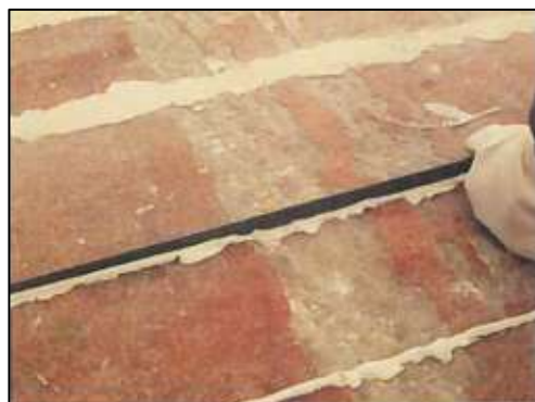
Bild 13: Einbringen der CFK-Lamelle in die Schlitze
