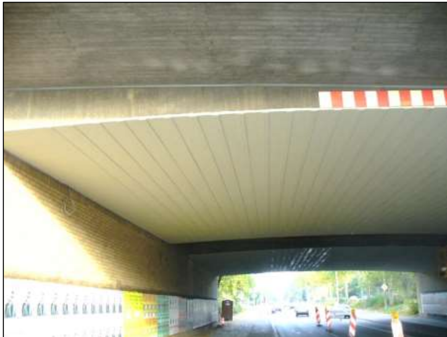
Bild 8: Plattenunterseite – Aufgeklebte CFK-Lamellen inklusive der OS-Beschichtung
