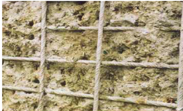
Bild 33: Durch Hochdruckwasserstrahlen vorbereitete Oberfläche (HANKERS, 2008)
