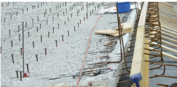
Bild 19: gestaffelte Anordnung der Verbundanker (Erfahrungssammlung Beispiel 3.2)
