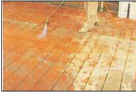
Bild 10: Austrocknen der Schlitze mittels Gasbrenner, reinigen der Schlitze mittels Druckluft
