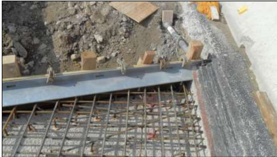
Bild 11: Eingebaute Bewehrung des Aufbetons und Verbundbewehrung zwischen Bestand und Aufbeton
