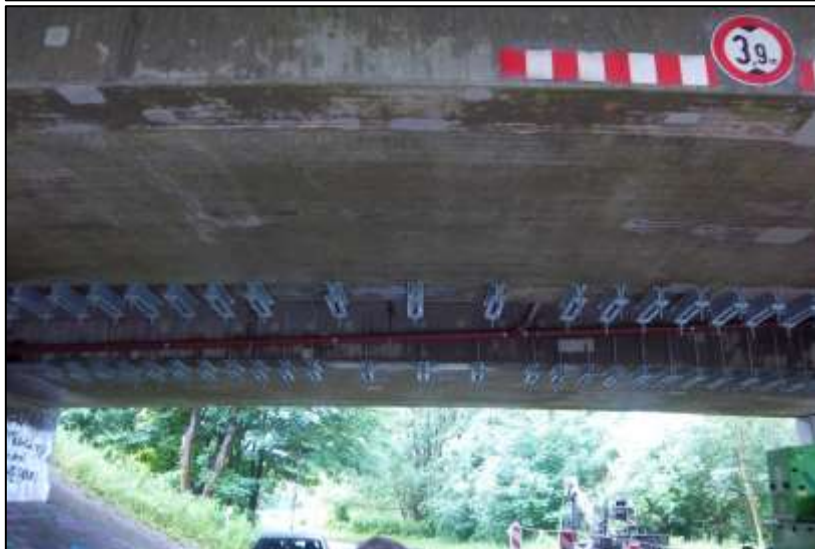
Bild 5: Querkraftverstärkung Brückenunterseite (Ausführung)
