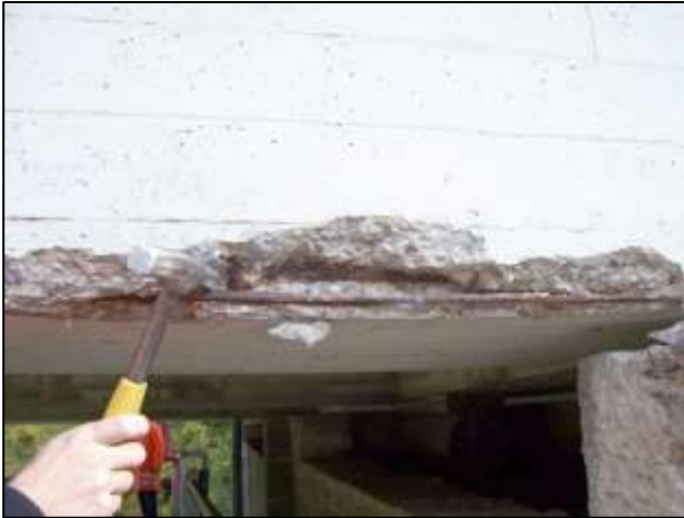
Bild 2: Schadensbild: Betonabplatzungen und Korrosion der Bewehrung
