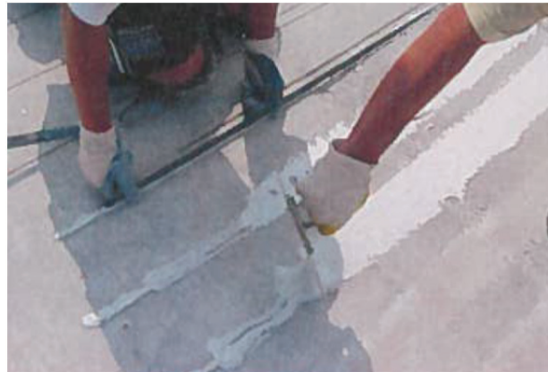
Bild 29: Einkleben der Lamellen (Erfahrungssammlung Beispiel 6.2)
