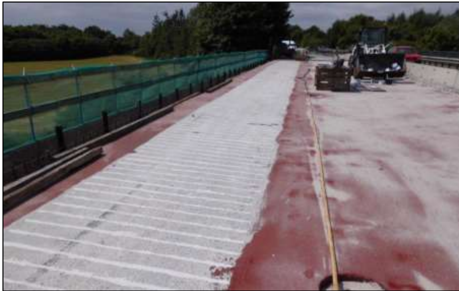
Bild 8: Mit eingeschlitzten CFK-Lamellen verstärkter Kragarm des Plattenbalkens
