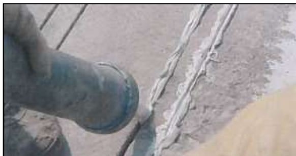
Bild 12: Einbringen des Epoxidharzklebers mittels Druckluftgerät mit Aufsatz
