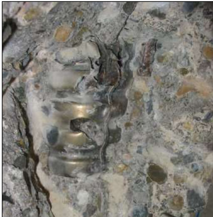
Bild 4: Geschädigtes Spannglied
