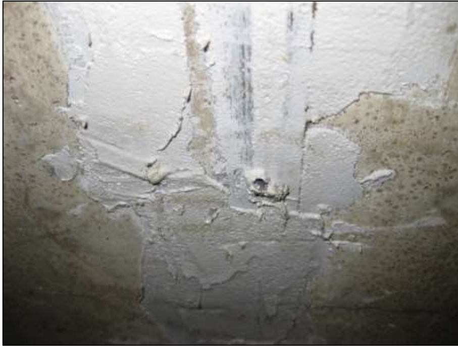
Bild 8: In Schlitze eingeklebte CFK-Lamellen an der Überbauunterseite
