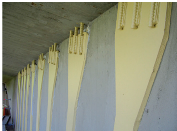
Bild 15: Stahllaschen als Querkraftverstärkung mit in Bohrlochern eingefädelten Gewindestangen (ROESER, 2010)
