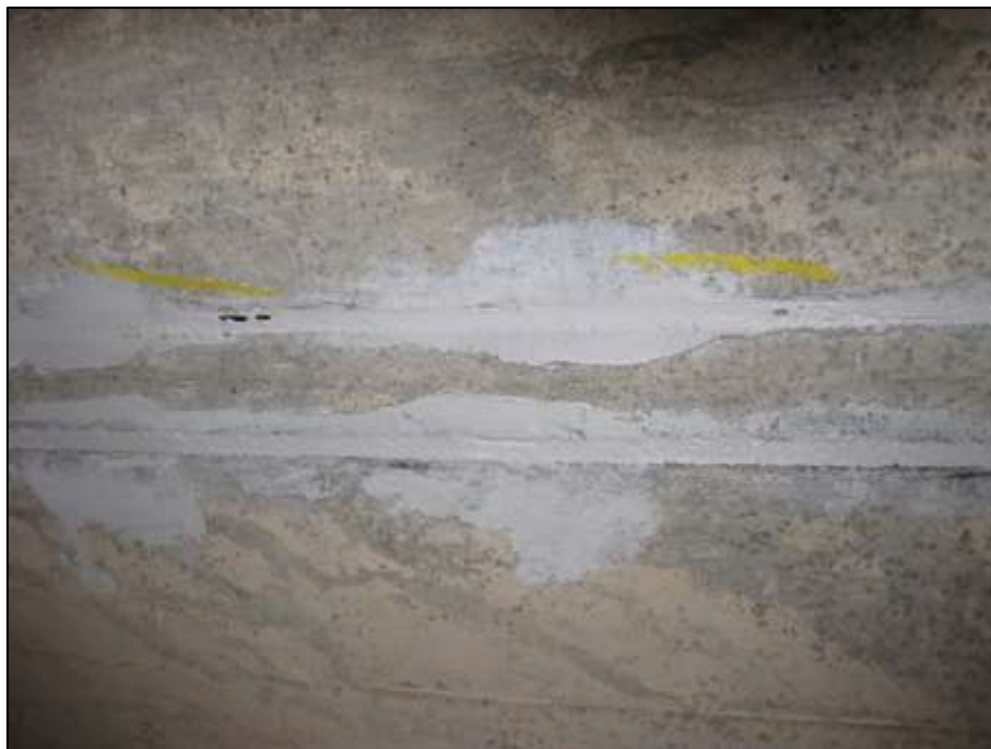
Bild 7: In Schlitze eingeklebte CFK-Lamellen an der Überbauunterseite
