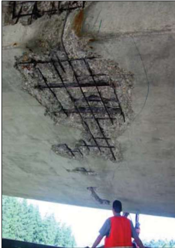
Bild 3: Betonabplatzungen
