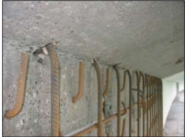
Bild 5: Anschluss der Bewehrung (Ausführung)
