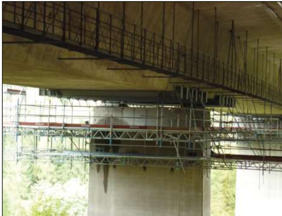
Bild 5: Untersicht Brücke mit Stahlträgern zur Verankerung der Querkraftverstärkung
