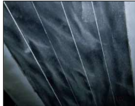
Bild 5: CFK-Lamellen im Zugbereich der Randträger, abgestreut und noch nicht beschichtet
