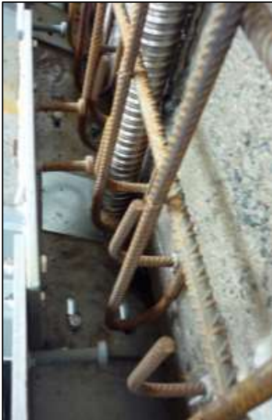
Bild 11: Querkraftverstärkung (Ausführung)
