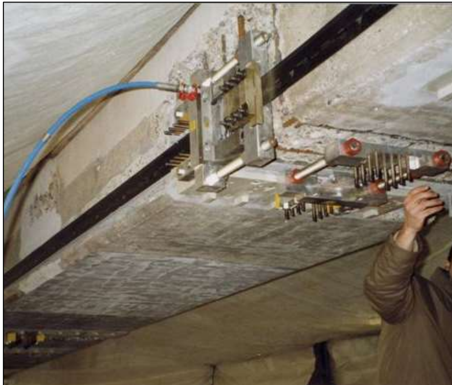
Bild 4: Vorspannvorrichtung der vorgespannten CFK-Lamellen
