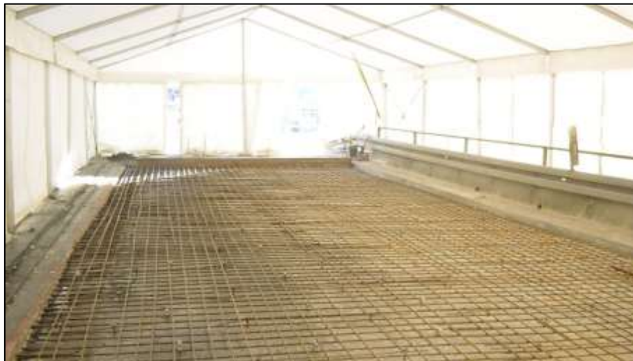
Bild 4: Bewehrung der Ortbetonbetonergänzung
