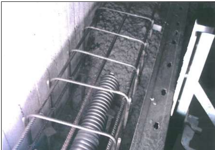
Bild 1: Zusätzliches Längsspannglied in anbetoniertem Balken (Ausführung)
