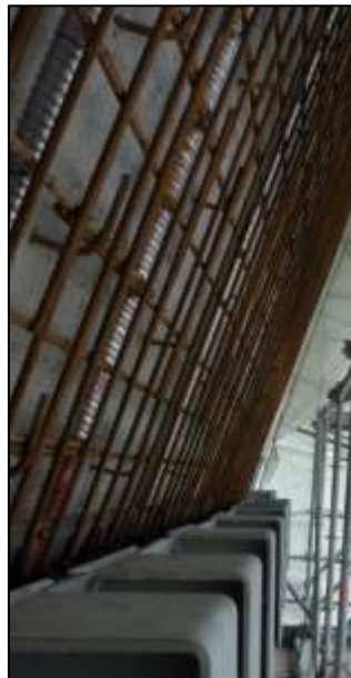
Bild 5: Querkraftverstärkung (Ausführung)
