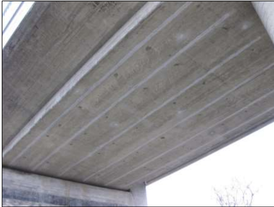
Bild 6: In Schlitze eingeklebte CFK-Lamellen an der Überbauunterseite zwischen Widerlager und Pfeiler
