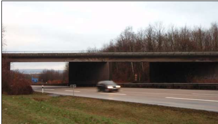
Bild 1: Übersichtsfoto des Brückenbauwerks
