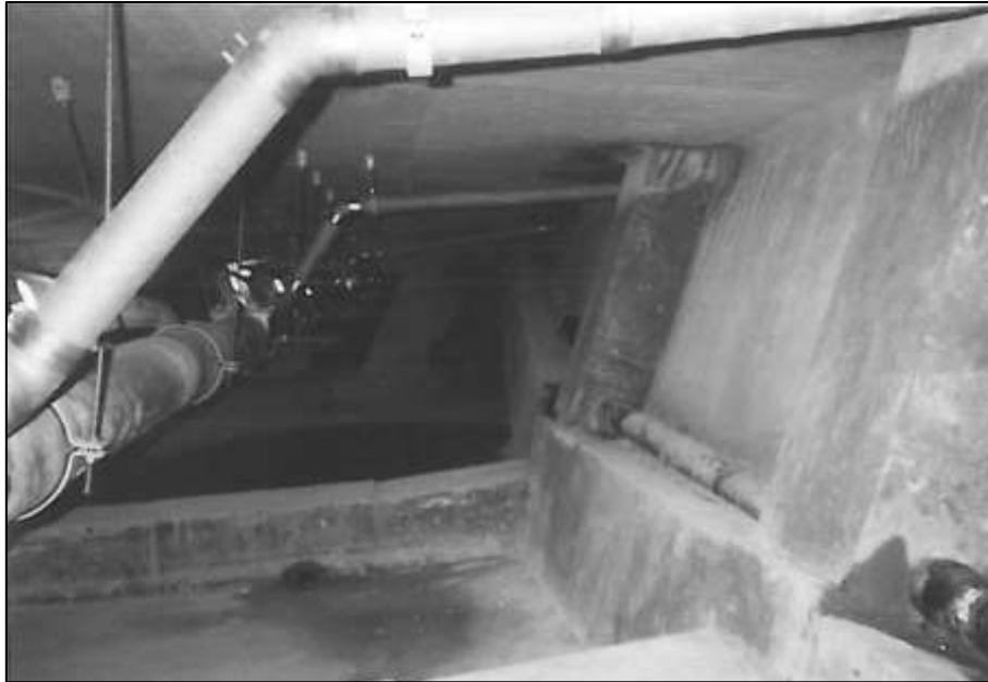
Bild 9: Verstärkter Steg nach Sanierung und Querrippe für Umlenkung. Längsrippe für Spannglieder im Verbund; auf oberer Seite Längsrippe Spannglied ohne Verbund
