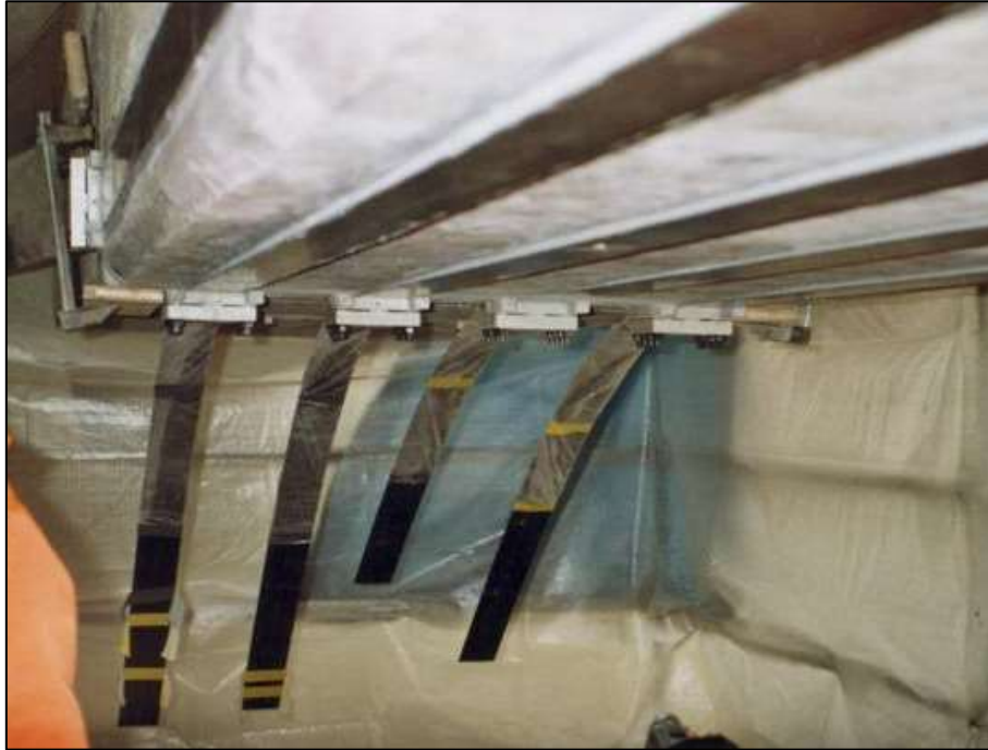
Bild 2: Einbau der vorgespannten CFK-Lamellen
