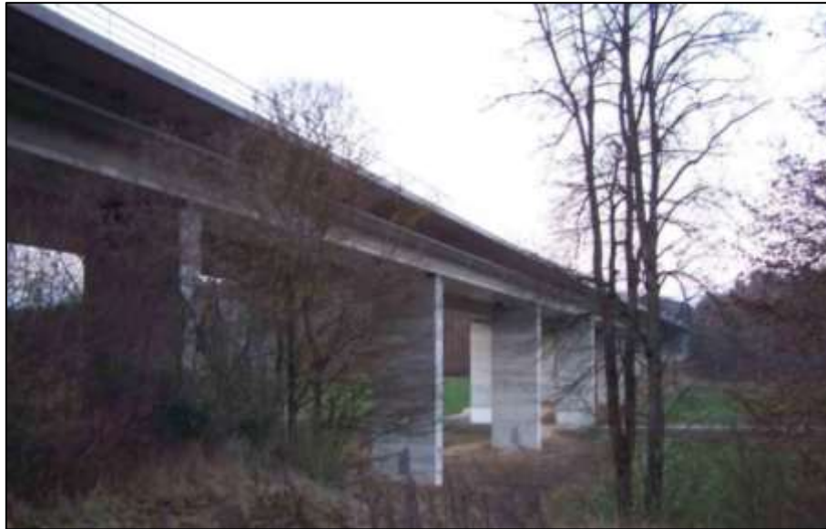
Bild 2: Übersichtsfoto des Brückenbauwerks
