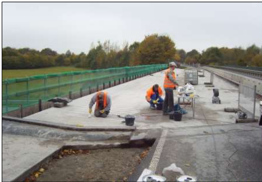
Bild 7: Einbringen der CFK-Lamellen
