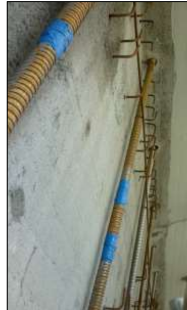
Bild 10: Kernbohrungen und Verankerungsdetail in der Fahrbahnplatte der Querkraftverstärkung (Ausführung)
