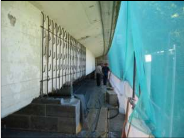
Bild 5: Anschluss der Bewehrung (Ausführung)
