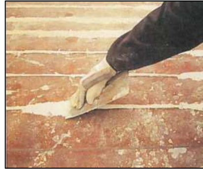
Bild 14: Verstreichen von herausgedrückt Epoxidharzkleber
