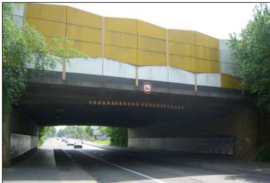
Bild 1: Übersichtsfoto des Brückenbauwerks
