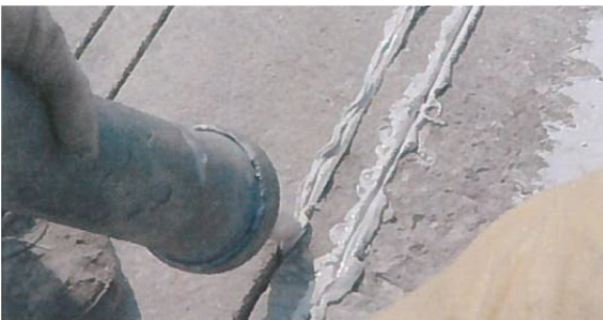
Bild 28: Einbringen des Klebers (Erfahrungssammlung Beispiel 6.2)
