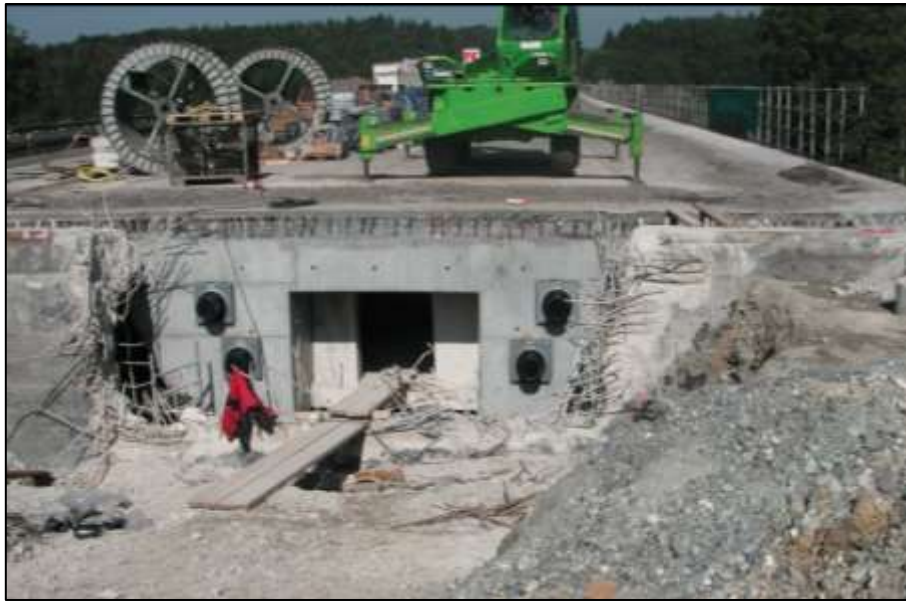
Bild 8: Endverankerung der externen Spannglieder (Ausführung)
