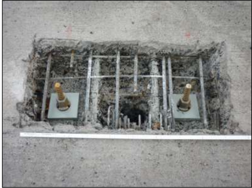
Bild 10: Kernbohrungen und Verankerungsdetail in der Fahrbahnplatte der Querkraftverstärkung (Ausführung)
