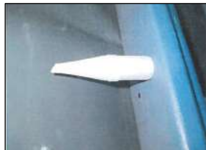
Bild 12: Einbringen des Epoxidharzklebers mittels Druckluftgerät mit Aufsatz
