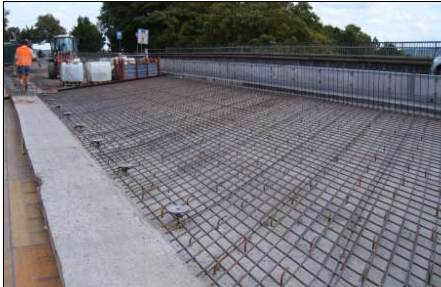
Bild 5: Bewehrung der Ortbetonergänzung
