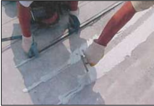
Bild 14: Verstreichen von herausgedrückt Epoxidharzkleber
