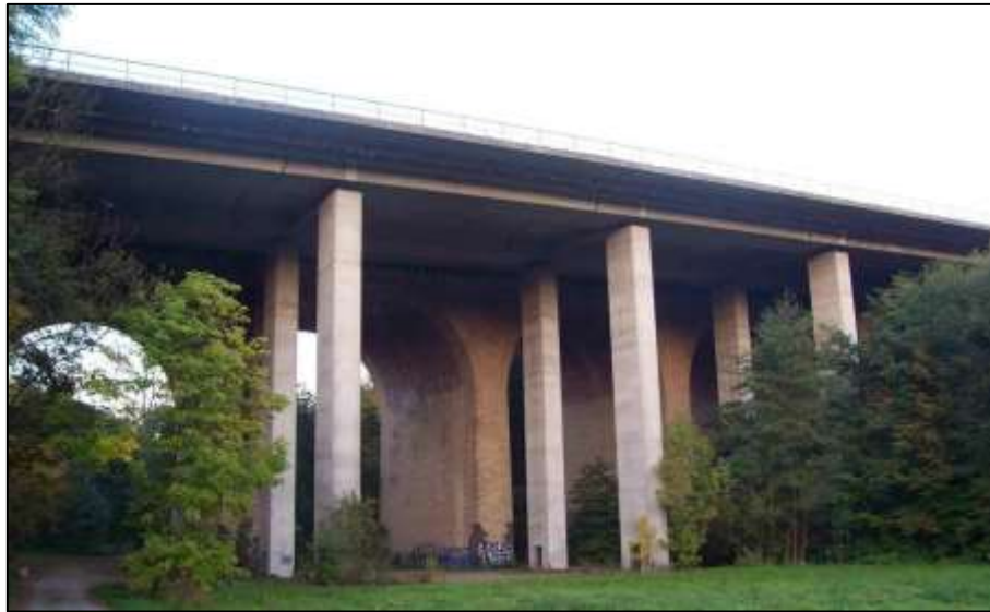
Bild 1: Übersichtsfoto des Brückenbauwerks
