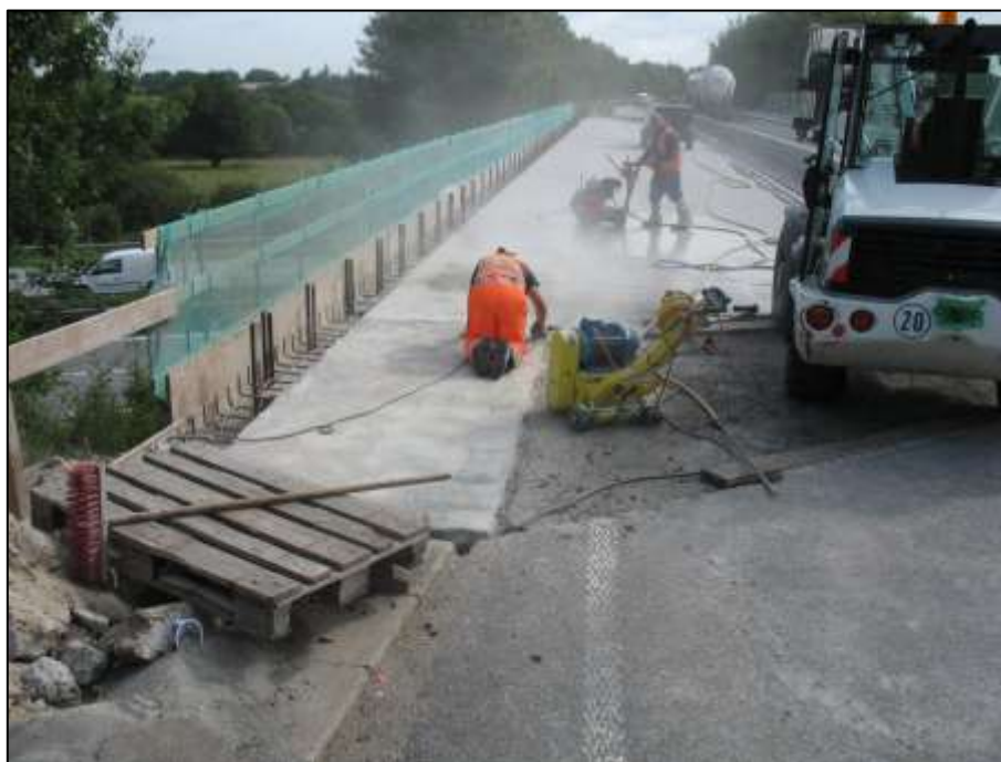
Bild 5: Einschneiden der Schlitze
