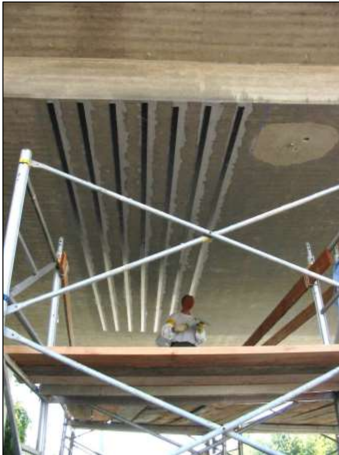
Bild 7: Aufkleben der CFK-Lamellen
