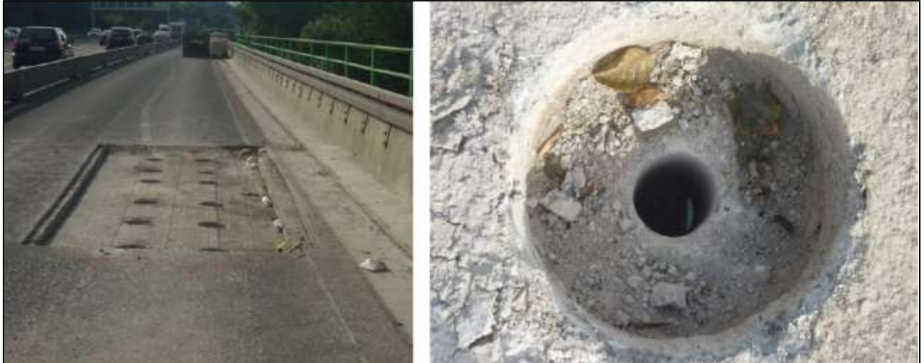
Bild 4: Kernborungen in Fahrbahnplatte zur Verankerung der zusätzlichen Querkraftbewehrung (Ausführung)
