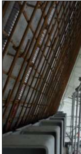
Bild 11: Querkraftverstärkung (Ausführung)
