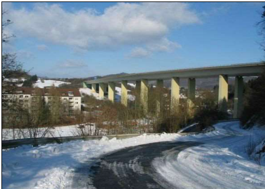
Bild 1: Übersichtsfoto des Brückenbauwerks
