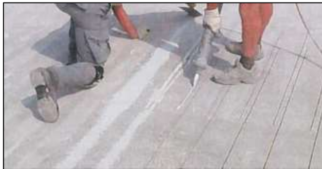
Bild 11: Einbringen des Epoxidharzklebers mittels Druckluftgerät
