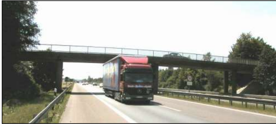
Bild 1: Übersichtfoto des Bauwerks
