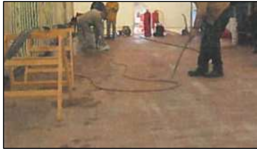
Bild 10: Austrocknen der Schlitze mittels Gasbrenner, reinigen der Schlitze mittels Druckluft
