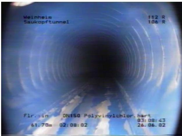
Man erkennt auf diesem Bild deutlich eine leichte „Schmierbildung“ von Calciumcarbonat auf den Schlitzen der Drainageleitung. Aushärtungen haben sich allerdings noch nicht gebildet, so dass die Funktion der Schlitze zwar nicht mehr reibungslos gewährleistet ist, aber immer noch Wasser durch die Schlitze in die Drainage fließen kann.
