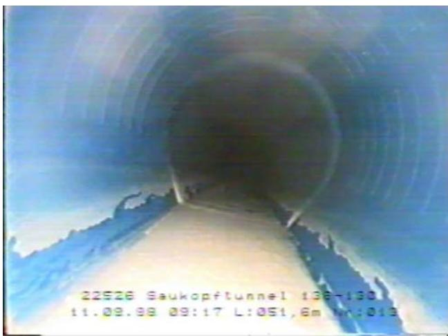
Auf Bild 10 ist zu erkennen, dass bereits der gesamte Sohlbereich mit einer Sinterschicht überzogen ist. Der Querschnitt der Drainage ist zu diesem Zeitpunkt noch nicht grundlegend reduziert, jedoch bietet sich hier bereits ein perfekter „Nährboden“ für neue Ausfällungen.
