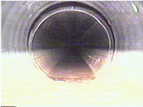
Bild 4 zeigt ebenfalls einen Rohrversatz, dieses mal jedoch in vertikaler Richtung. Diese Lageabweichung erhält dementsprechend das Kürzelpaar „LV“ für die ersten beiden Stellen. Der Kreisquerschnitt ist deutlich verschoben. An der Sohle sind bereits deutliche Versinterungsspuren zu erkennen (3. Kürzel „R“) da der Versatz am oberen Rand zu erkennen ist, wird die 4. Stelle mit einem „O“ belegt. Das Kürzel lautet also: **L V R O**
