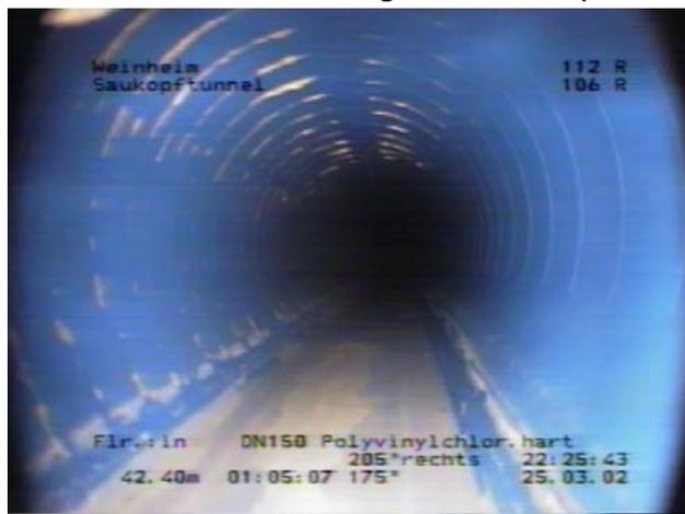
Im links zu sehenden Bild soll besonderes Augenmerk auf die Schlitze auf der linken, oberen Seite gelegt werden. Diese sind zum Teil bereits vollständig mit Sinter ausgefüllt, so dass kein Bergwasser mehr durch die betroffenen Schlitze fließen kann. Die Konturen der Ablagerungen sind dabei klar zu erkennen.
