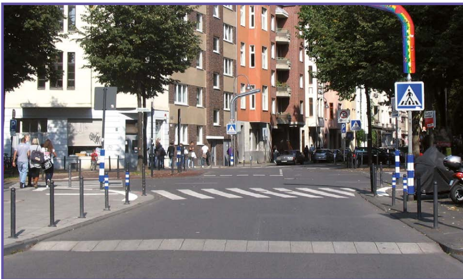
Beispiel für eine „Aufpflasterung“
