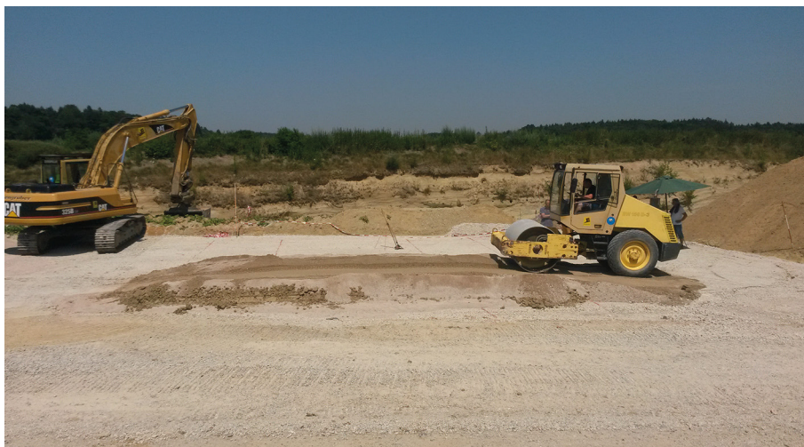
Einbau eines Probefeldes zur Bodenverbesserung (Bild: Stefan Huber)
