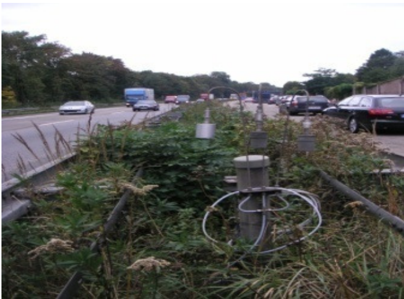
Abbildung 7: Messstelle NO x Messquerschnitt an der Bundesautobahn A4 Mittelstreifen
