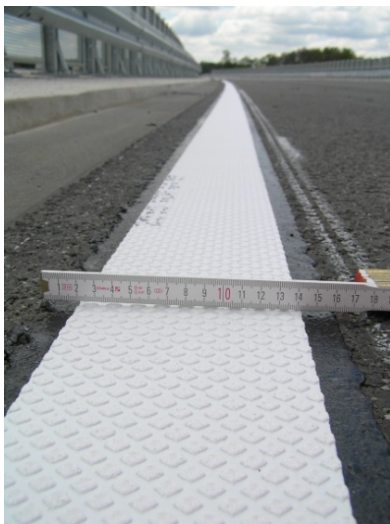
Abbildung 4-14: Applikation der Bitumenschicht (links) und applizierte Folie auf Bitumenschicht (rechts) bei Probenahme 13
