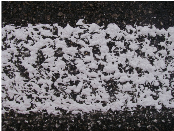
Abbildung 4-12: Applizierte Fahrbahnbegrenzung (links) und Draufsicht Agglomerat (rechts) bei Probenahme 10
