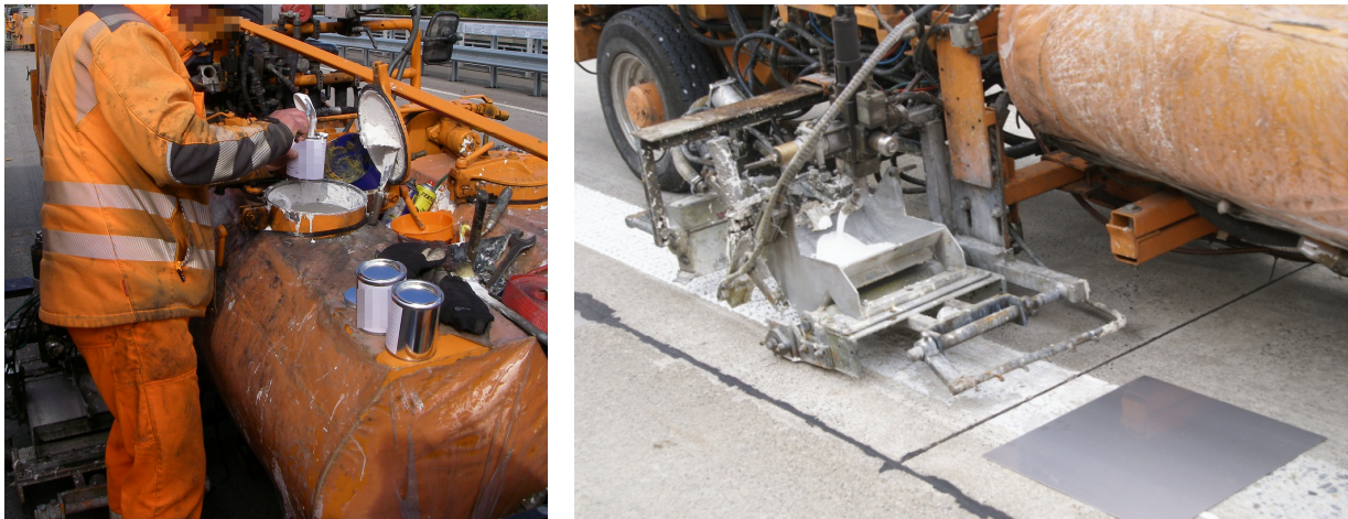
Abbildung 3-1: Entnahme eines reaktiven Markierungsstoffs aus dem Vorratsbehälter der Markiermaschine (links) und Herstellung eines Prüfblechs (rechts)
