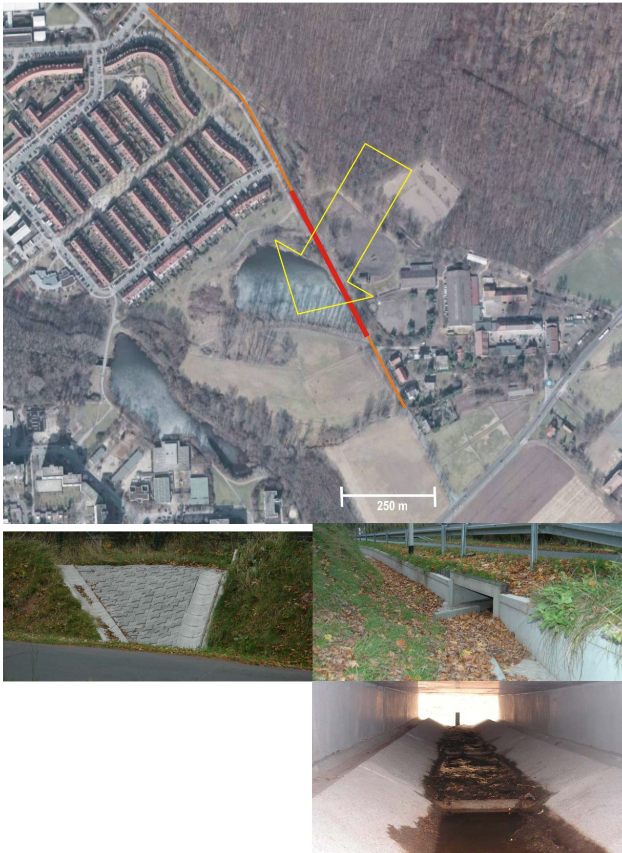
Abbildung 30: Luftbild und Überblicksfotos zur Amphibienschutzanlage (ASA) an der Parkstraße in Darmstadt-Kranichstein (orange Linie: ASA, rote Linie: Kontrollbereiche, gelber Pfeil: Bereich [früherer] Hauptwanderstrom von Amphibien während der Frühjahrswanderung)
