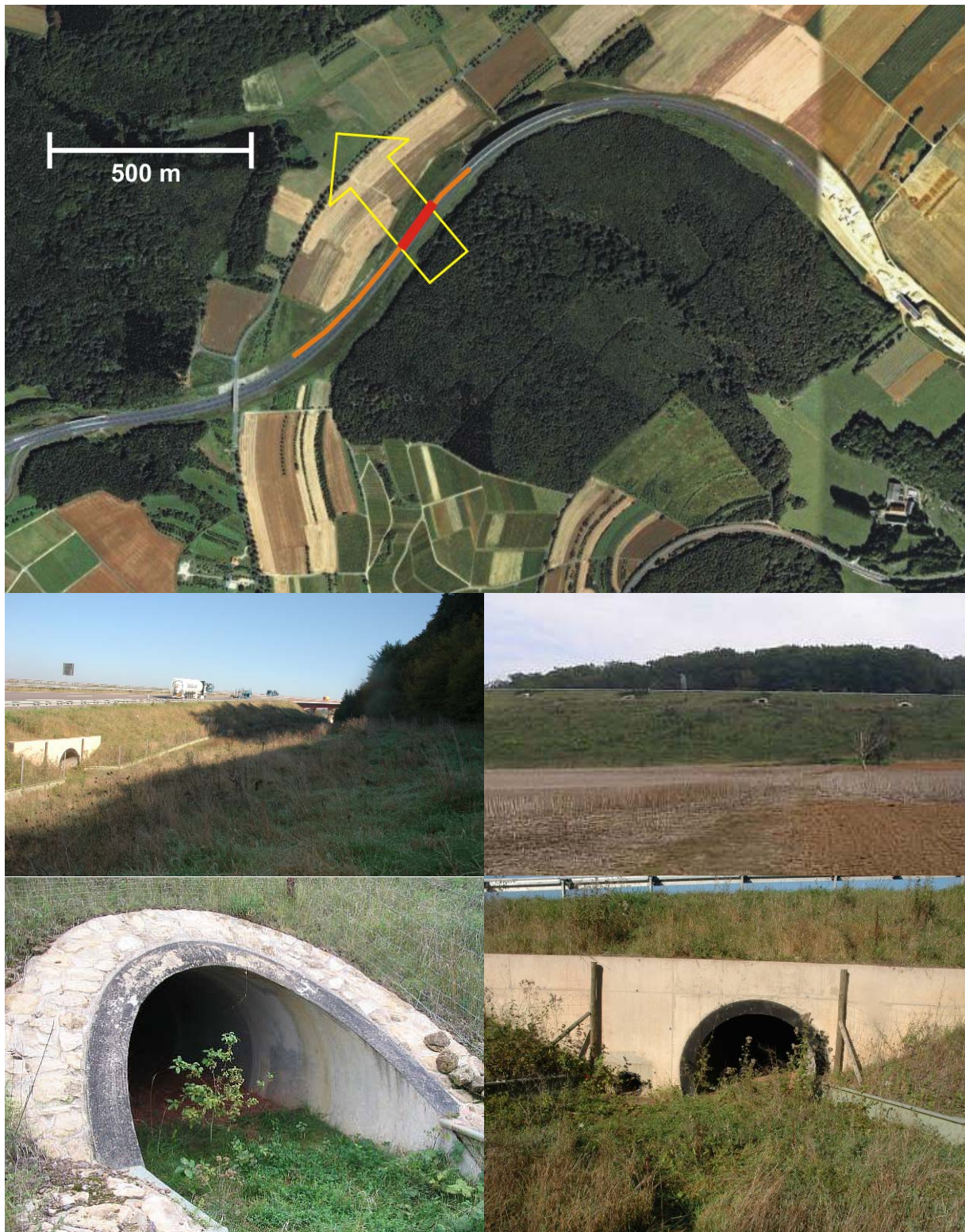
Abbildung 42: Luftbild und Überblicksfotos zur Amphibienschutzanlage (ASA) an der A 8 bei Perl (orange Linie: ASA, rote Linie: Kontrollbereiche, gelber Pfeil: Bereich [früherer] Hauptwanderstrom von Amphibien während der Frühjahrswanderung)
