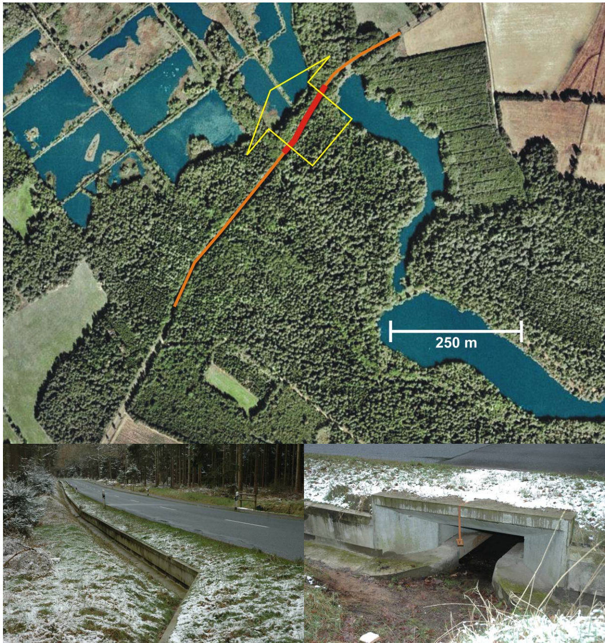
Abbildung 31: Luftbild und Überblicksfotos zur Amphibienschutzanlage (ASA) an der K 28 neben den Holmer Teichen bei Buchholz (orange Linie: ASA, rote Linie: Kontrollbereiche, gelber Pfeil: Bereich [früherer] Hauptwanderstrom von Amphibien während der Frühjahrswanderung)
