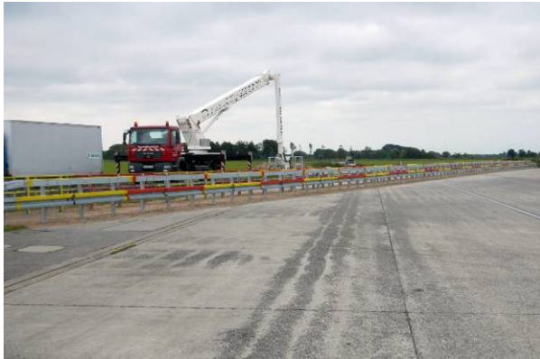
Abbildung 4 Stahlgeschützwände aus Annäherungsrichtung
