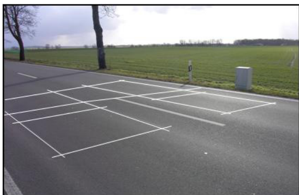
Bild 5: Querschnitt mit Doppelinduktionsschleifen
