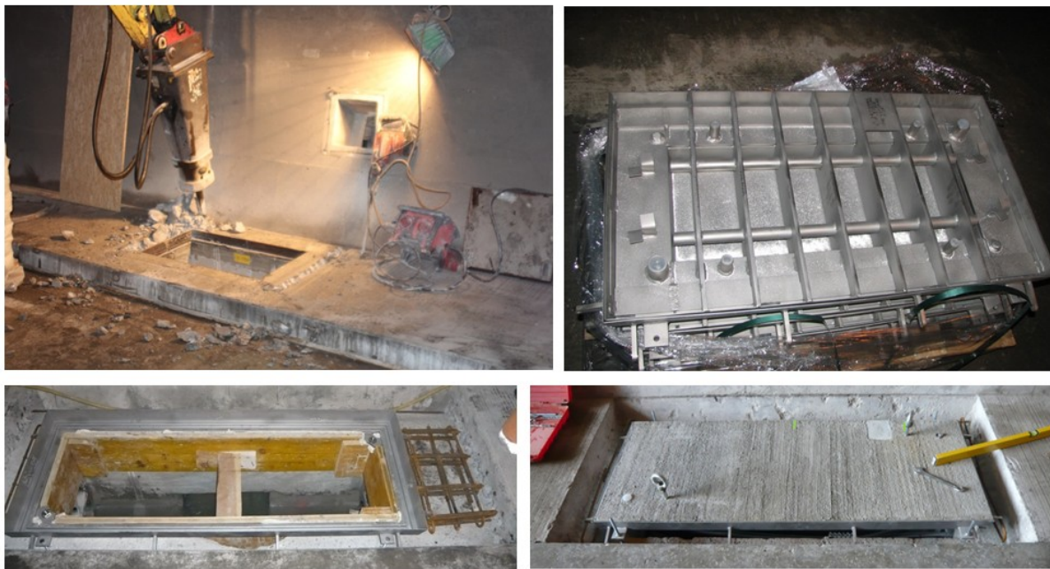
Bild 10. Austausch Kabelzugschachtabdeckungen
