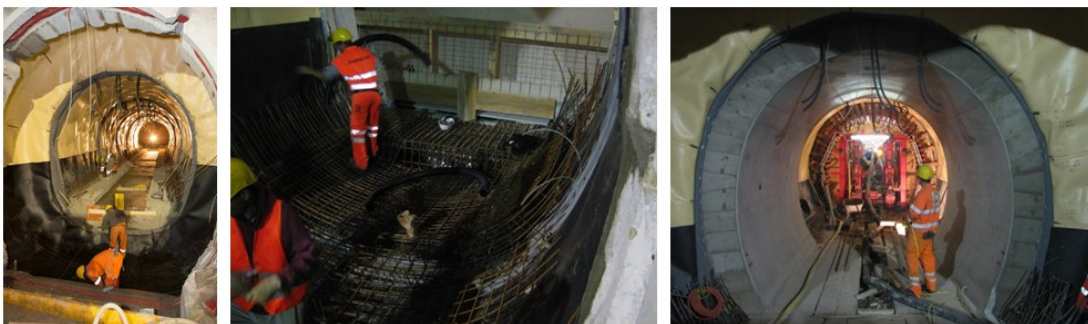
Bild 8: Einbau der Abdichtung und der Innenschale
