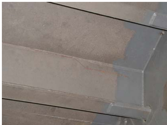
Bild 6: Risse in der Verbindungsnaht zwischen Deckblech und Längsrippe links: Sektkelchprofil rechts: Trapezprofil - instandgesetzte Naht zur späteren Prüfung noch ohne Beschichtung
