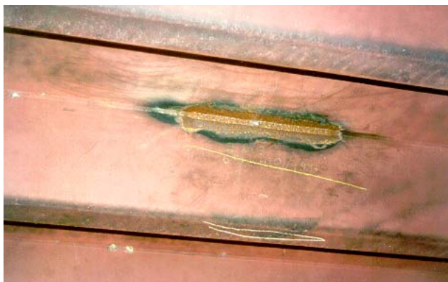
Bild 6: Risse in der Verbindungsnaht zwischen Deckblech und Längsrippe links: Sektkelchprofil rechts: Trapezprofil - instandgesetzte Naht zur späteren Prüfung noch ohne Beschichtung
