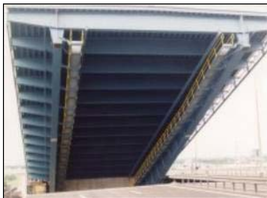
Bild 2: Beweglicher Teil der Brienoordbrücke
