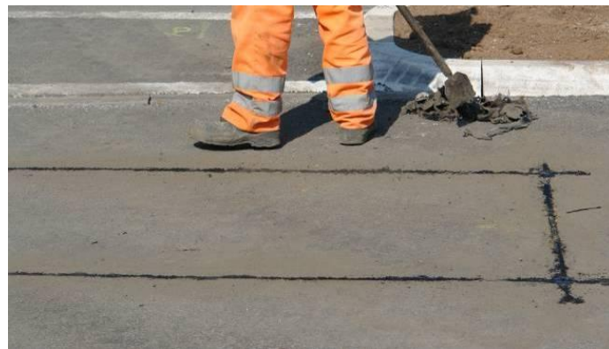
Bild 1: Herstellung einer Schleife im Vorfeld eines Tunnels
