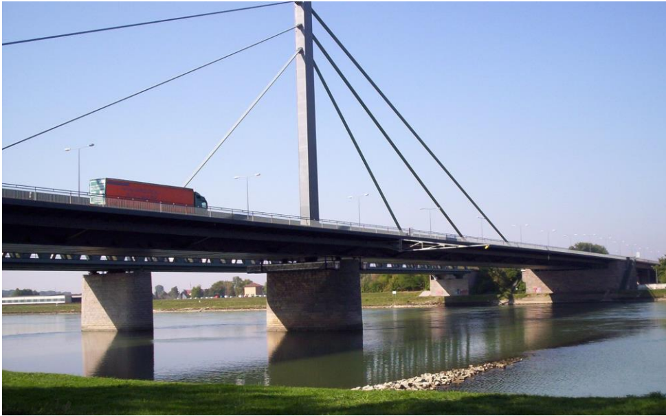
Abbildung: Rheinbrücke Maxau
