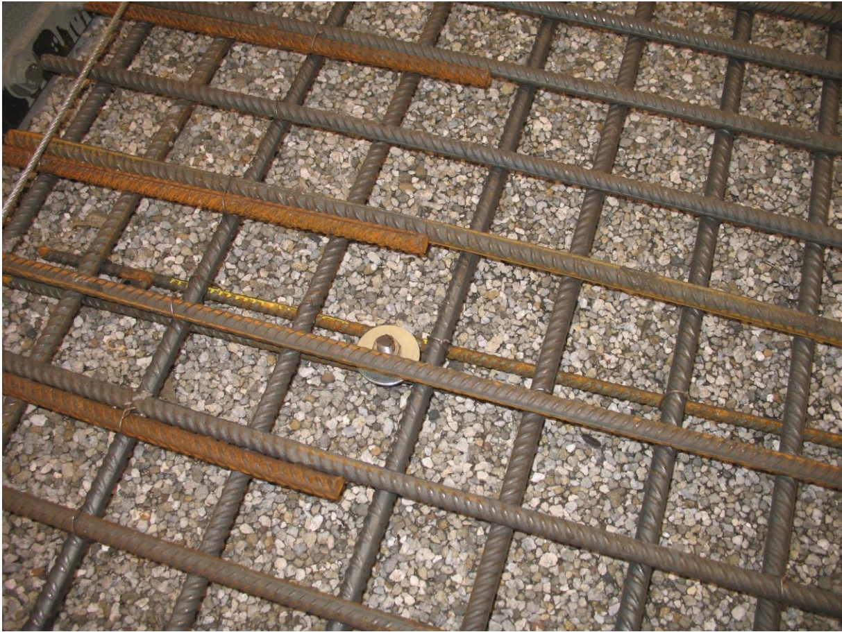
Abbildung: Vorbereiteter Betonierabschnitt mit Niederhalter
