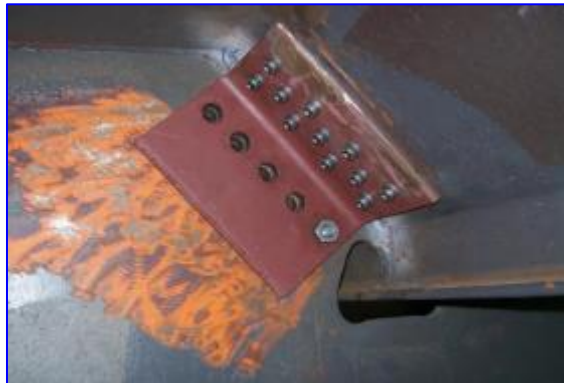
Genieteteter Anschluss der Steifen
