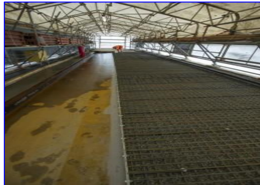
Aussteifung des Bleches durch UHPC-Beton oder Polymer-Asphalt / SPS-System
