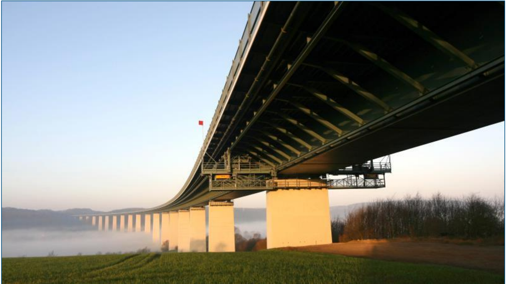
Talbrücke Mintard, A52
