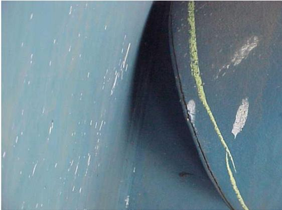
Schweißnahttriss im Verschlussdeckel der Hohlstreben
