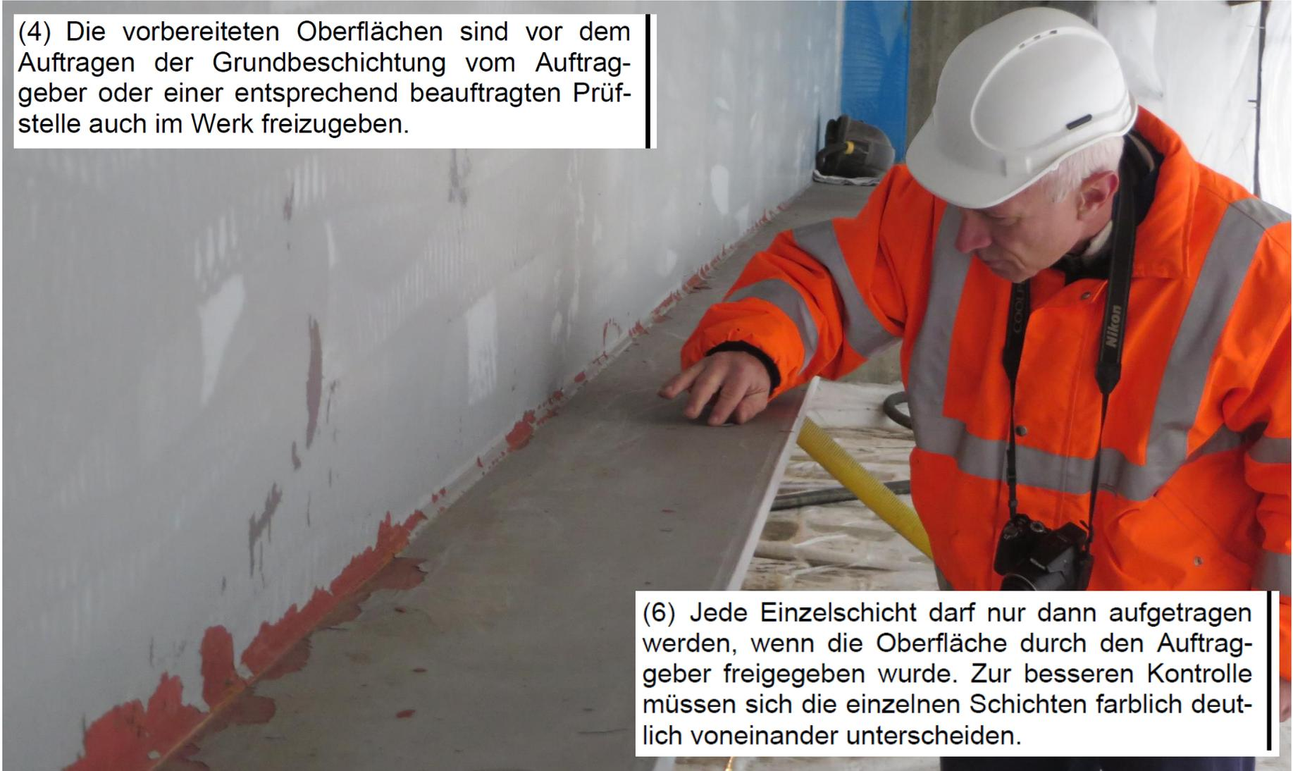
(6) Jede Einzelschicht darf nur dann aufgetragen werden, wenn die Oberfläche durch den Auftraggeber freigegeben wurde. Zur besseren Kontrolle müssen sich die einzelnen Schichten farblich deutlich voneinander unterscheiden.
