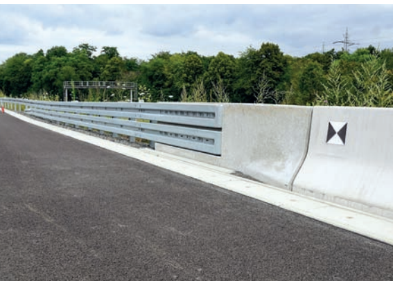
Übergangskonstruktion zur Verbindung von verschiedenen Schutzeinrichtungen
