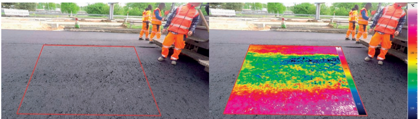
Betrachteter Bildausschnitt im sichtbaren (links) und im Infrarotbereich (rechts)
