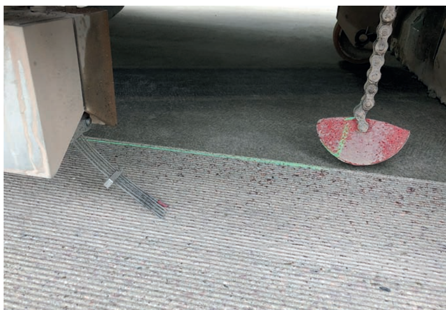
Lasergestützte Steuerung zur Linienführung der Grindingmaschine
