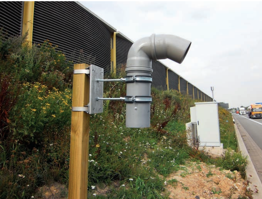
Messcontainer und Passivsammler an einem der vier Standorte der kontinuierlichen Messungen an der A1
