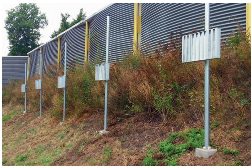
Bewitterungsgestelle mit Prüfkörpern an der A1 (Bild: KRONOS)
