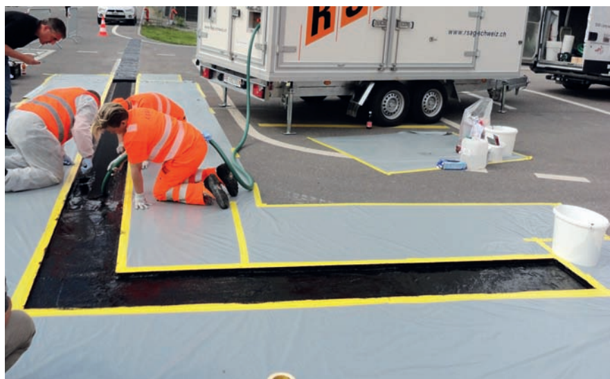
Maschinelles Einbau der Muldenfüllung
