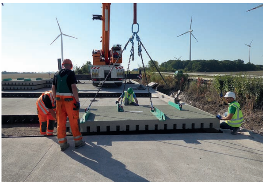
Herstellung eines Endbereichs mittels Fertigteilen (A14)
