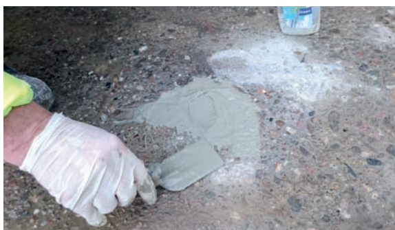
Einbau von Sensoren auf der „Intelligenten Brücke“
