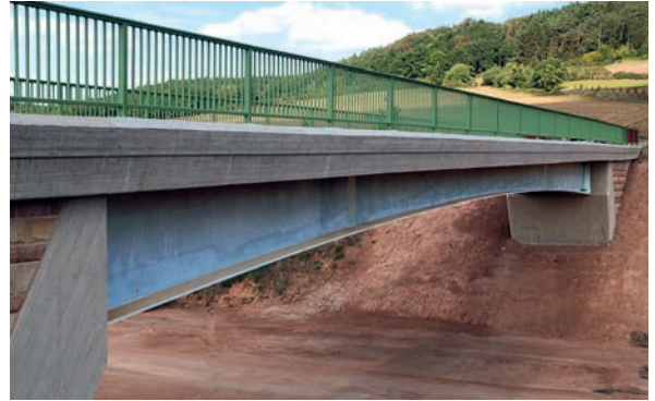
Verzinkte Verbundbrücke bei der Anschlussstelle Waldkappel-Hoheneiche
