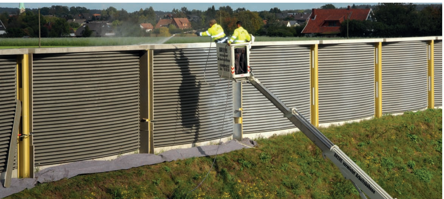
Beschichtungsarbeiten an der Lärmschutzwand an der A1
