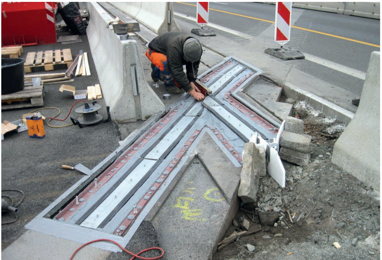
Fahrbahnübergang bei schwierigen geometrischen Verhältnissen
