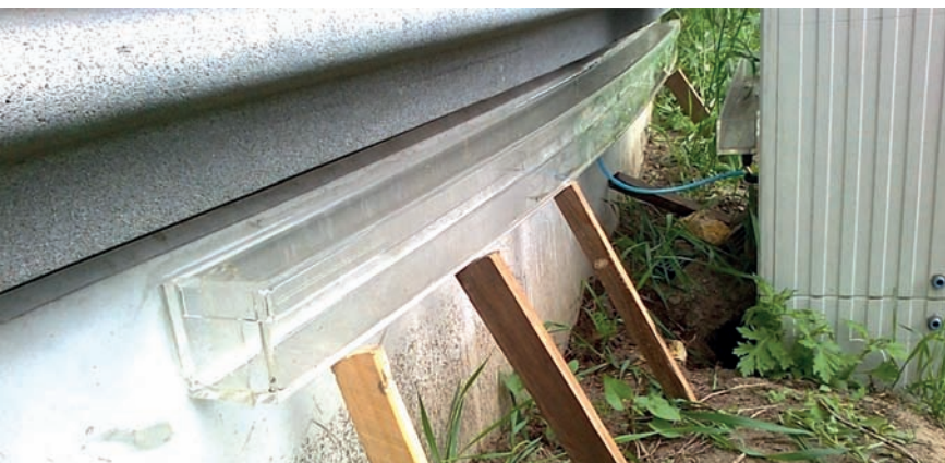
Trichterkonstruktion zur Sammlung ausreichender Mengen an Niederschlagswasser (Bild: UIT GmbH Dresden)
