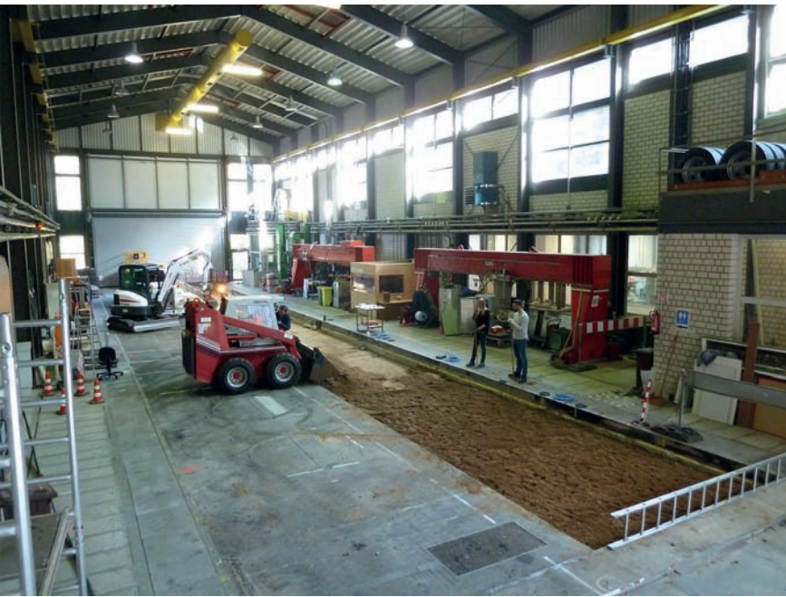
Einbau neuer Versuchsfelder in der BAST-Versuchshalle
