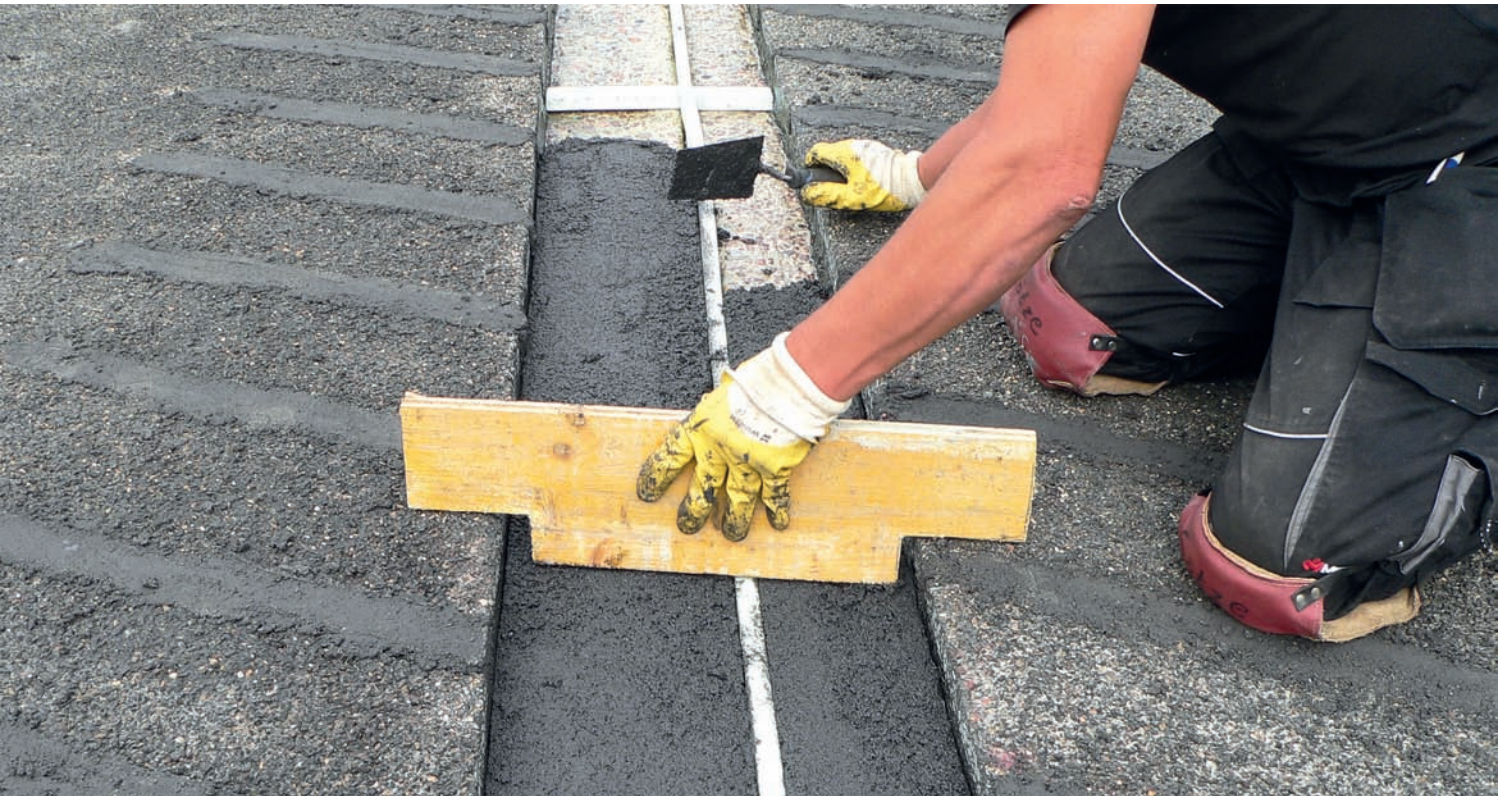
Herstellen einer gleichmäßigen Höhe der Fugenmulde durch Aufbringen eines Polymerbetons
