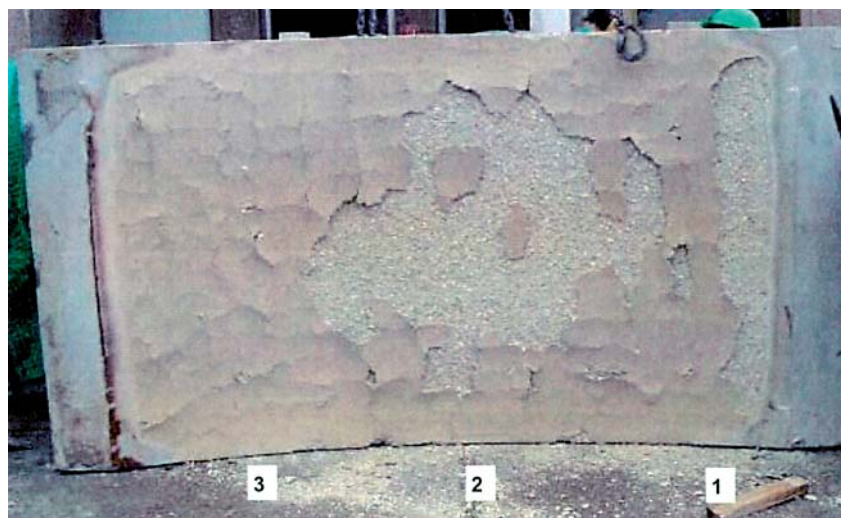
Tunnelbeton mit 2,0 kg/m 3 PP-Fasern nach Brandversuch (Foto: MPFA Leipzig)
