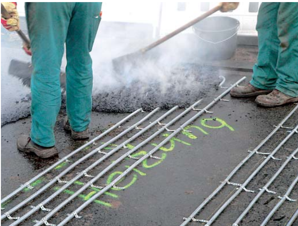
Einbau des Gussasphalts auf die fixierten Rohre
