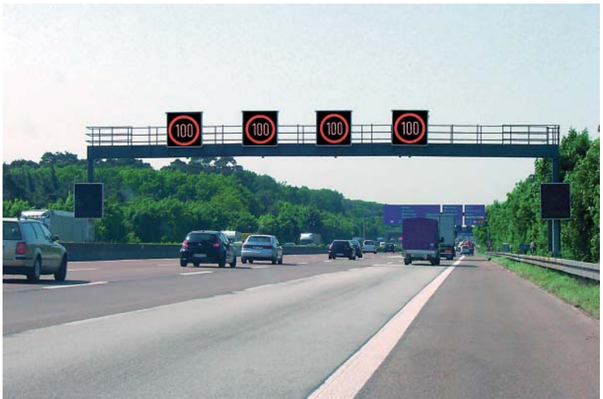
Streckenbeeinflussung (Foto: Hessische Straßen- und Verkehrsverwaltung)
