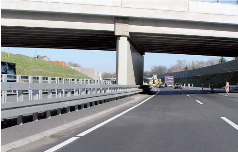
Heutiger Einsatz von Fahrzeug-Rückhaltesystemen, Schutzeinrichtung „Super-Rail“ im Mittelstreifen vor einem Brückenpfeiler
