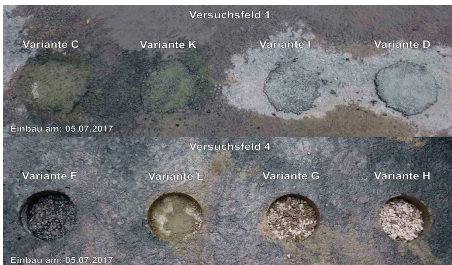
Versuchsfelder: Bohrkernentnahmestellen komplett verschlossen (Versuchsfeld 1, oben) und noch offen mit sichtbarer Unterkonstruktion (Versuchsfeld 4, unten) (Bild: Bergische Universität Wuppertal)
