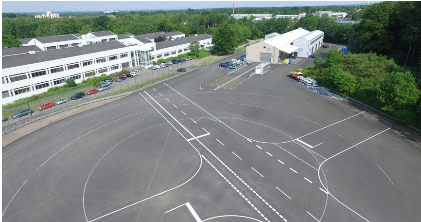
Fahrdynamikfläche mit markierter Straßenkreuzung für Forschungsaktivitäten zur aktiven Fahrzeugsicherheit
