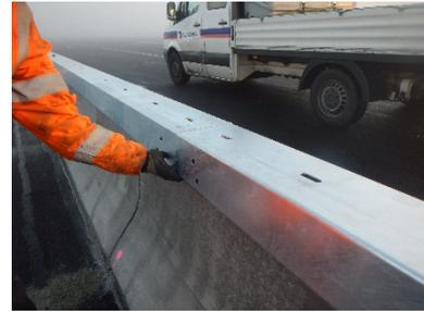
Abb. 6: Ausrichten der Kastenprofile
