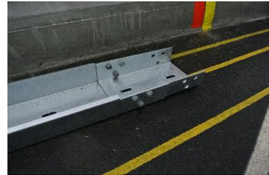
Abb. 3: Vorbereiten der Kastenprofile
