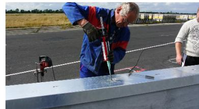
Abb. 10: Einpressen des Spezialmörtels
