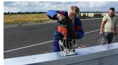
Abb. 7: Bohren der Ankerlöcher
