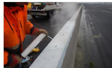
Abb. 8: Ausblasen der Bohrlöcher
