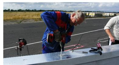
Abb. 11: Einschrauben des Betonankers
