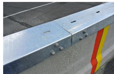
Abb. 5: Verbinden der Kastenprofile
