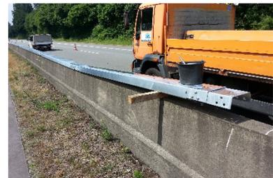
Abb. 4: Auslegen der Kastenprofile
