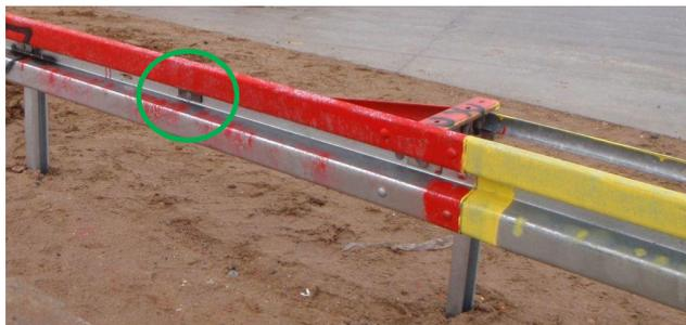
Der hinten am System verlaufende Abspanngurt wird von der Hinterkante des Abstandhalters an den Holm (in einem Abstand von 1 m vom Pfosten) geführt und dort verschraubt mit 1 HRK-Schraube mit Nase M 16x45, Güte 4.6 mit Mutter (40.01) und Unterlegscheibe 18 (40.30) sowie vorderseitig mit einer Decklasche M16.
