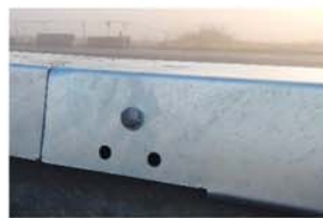
Abb. 3: Verbinden der Kastenprofile
