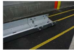
Abb. 1: Vorbereiten der Kastenprofile
