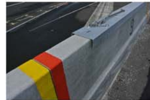
Abb. 2: Auslegen der Kastenprofile
