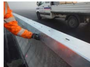
Abb. 4: Ausrichten der Kastenprofile
