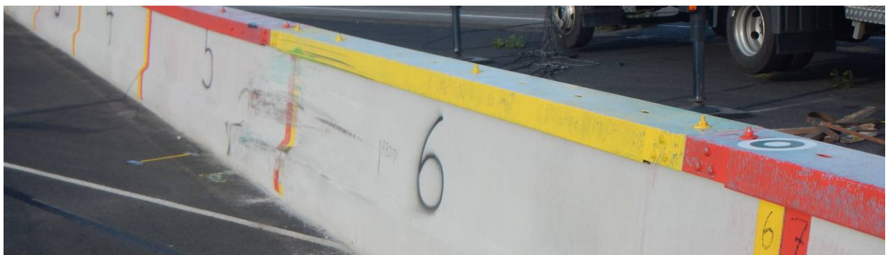
Bild 12 Anprallbereich nach dem Anprallversuch (Ansicht von vorne gegen Anprallrichtung)
