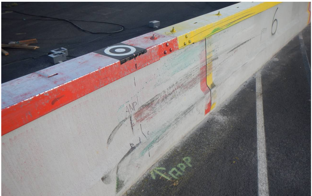
Bild 10 Anprallbereich nach dem Anprallversuch (Ansicht von vorne in Anprallrichtung)
