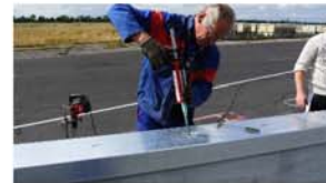
Abb. 9: Einpressen des Spezialmörtels
