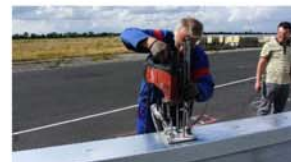
Abb. 6: Bohren der Ankerlöcher
