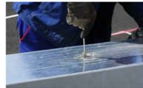
Abb. 8: Ausbürsten der Bohrlöcher
