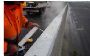
Abb. 7: Ausblasen der Bohrlöcher
