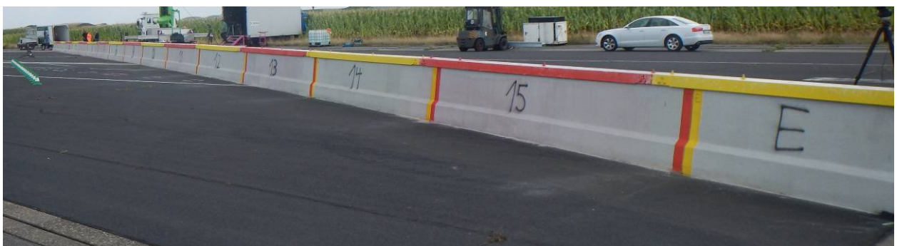
Bild 4 BSW O mit angebrachter Sanierungslösung (Ansicht von vorne gegen Anprallrichtung)
