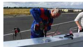
Abb. 10: Einschrauben des Betonankers
