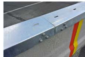
Abb. 2: Auslegen der Kastenprofile
