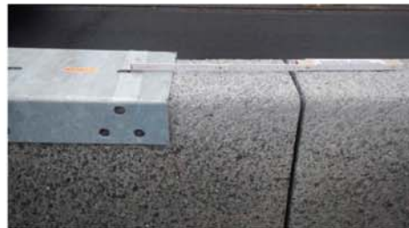
Abb. 5: Ausrichten des Kastenprofils
